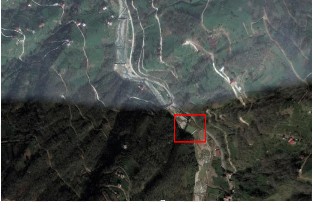
Şekil 22 Kale Hidroelektrik Santrala ait Regülatör alanının Uydudan Görünüşü
