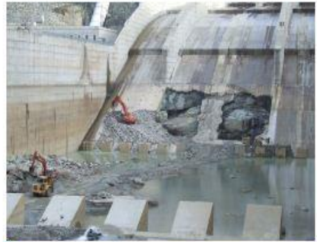
Oturma neticesinde dolusavakta meydana gelen hasar
