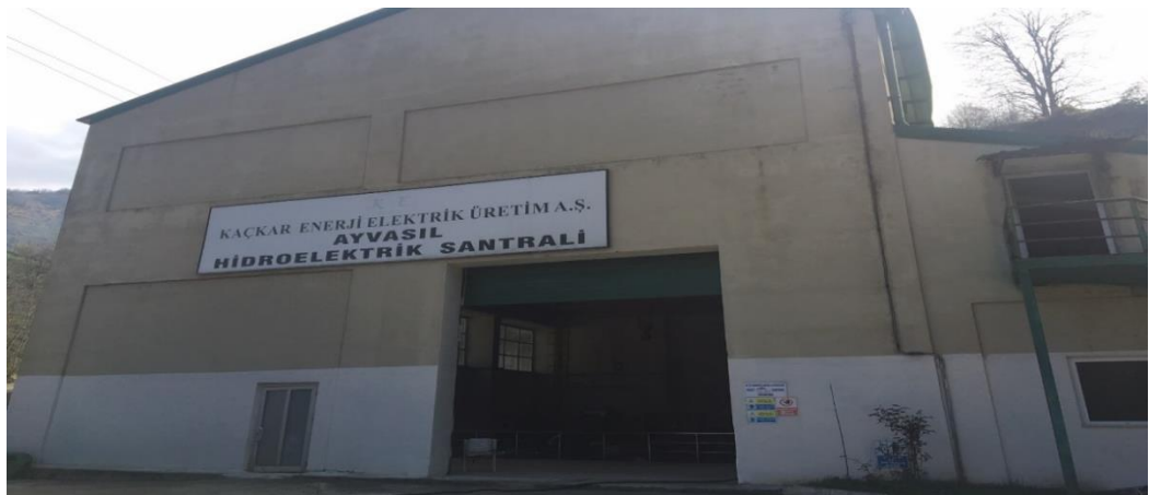
Şekil 11 Ayvasıl Hidroelektrik Santral Binası
