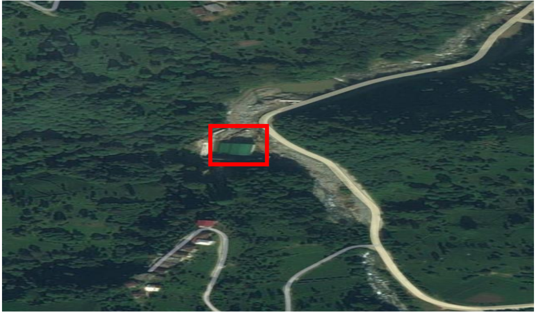
Şekil 9 Ayvasıl Hidroelektrik Santralinin Uydu Görüntüsü
