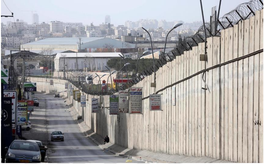
Şekil 3.2 Batı Şeria Duvarı 425
