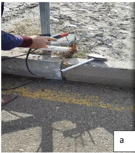
Fotoğraf 34:Çalışanın a) Kaynak Yaparken Metal Boruya Çıplak Elle Dokunması; b) İşle İlgisi Olmayan Kişinin İşe Müdahalesi
