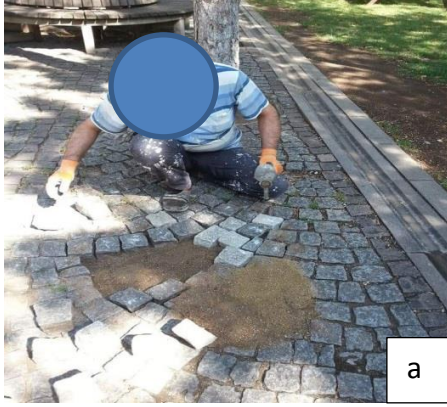
Fotoğraf 59: Çalışanın a) Zemin Üzerine Parke Taşı Döşemesi, b)Çalışma Ortamı Genel Görünümü
