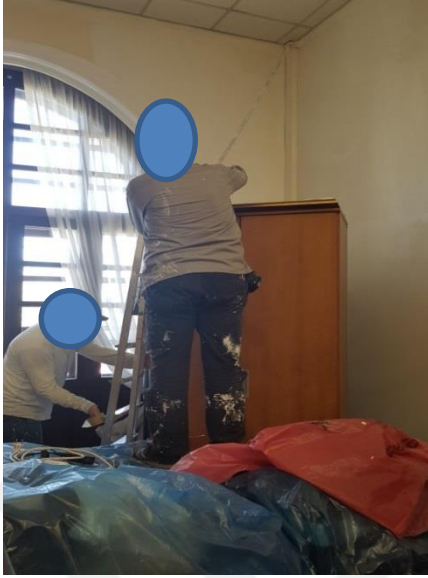
Fotoğraf 7: Masa ve Merdiven Üzerinde Boya Yapan Çalışanlar
