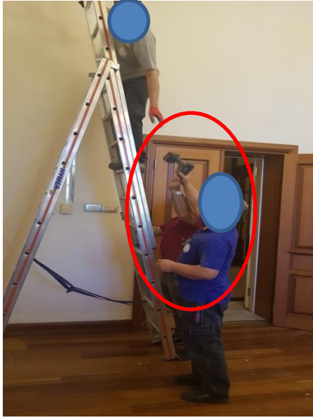
Fotoğraf 22: Yüksekten Çalışırken Aşağıya Malzeme Bırakma (a)) ve Çıplak Elle Elektrik Hattına Dokuma (b))
