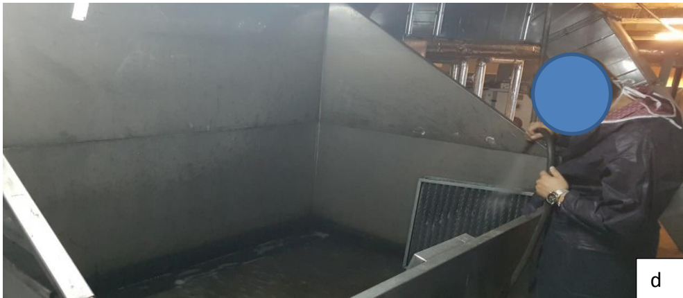
Fotoğraf 44:Aliminyum Kaset Klima Filtre Yıkama İşi (a), b), c) d))
