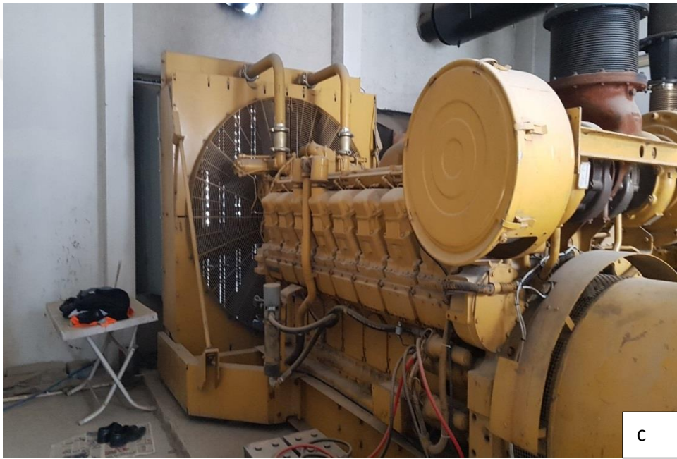
Fotoğraf 62:Trafo Merkezi; a) Anahat Boruları, b)İçi Yangın Söndürme Tüpleri, c) Enerji Merkezi
