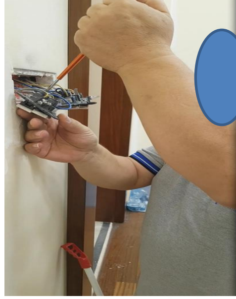
Fotoğraf 22: Yüksekten Çalışırken Aşağıya Malzeme Bırakma (a)) ve Çıplak Elle Elektrik Hattına Dokuma (b))
