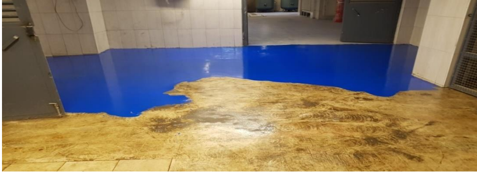
Fotoğraf 13: Hastane Zeminine Poliüretan (Epoksi) Uygulaması
