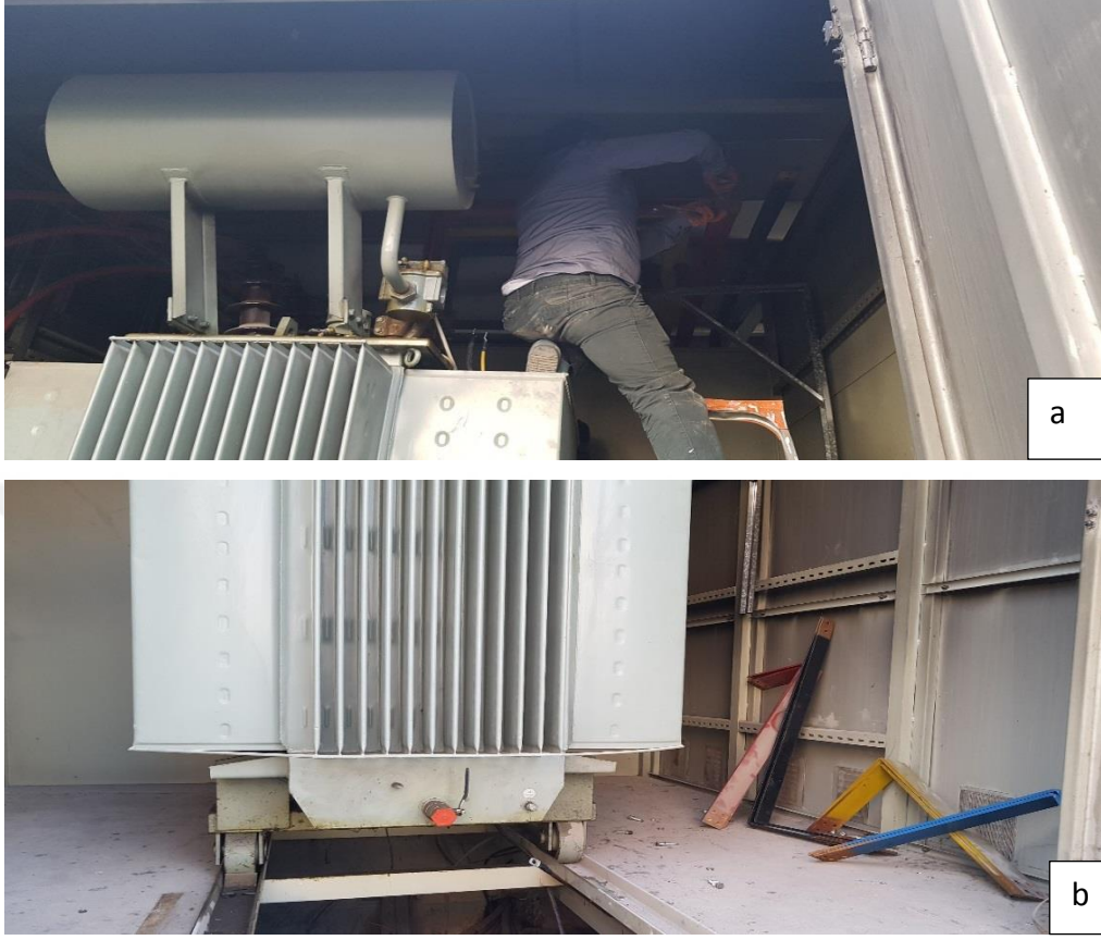
Fotoğraf 61: Trafo; a) Bağlantılarının Sökülmesi, b) İçi
