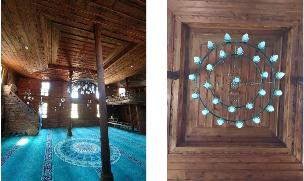
Şekil 84: Kastamonu Beldeğirmeni Köyü Tarihi Çınaraltı Cami Ahşap Tekne Tavan (Zamur Koçak Arşivi, 2020).
