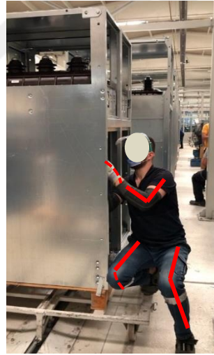
Şekil 55 Switch kablolarını mekanizmaya takma ve spiralleme alt faaliyet adımı
