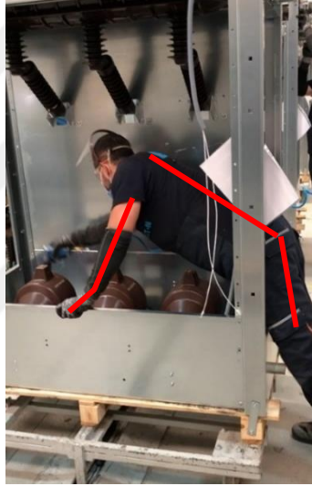
Şekil 34 Operatörün trafoların hücre içerisine montaj alt faaliyet adımı
