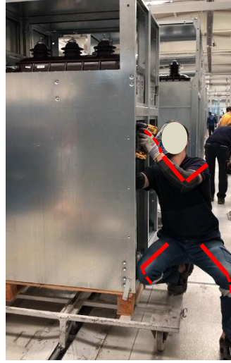
Şekil 54 Motor switchi kabloları montajı alt faaliyet adımı
