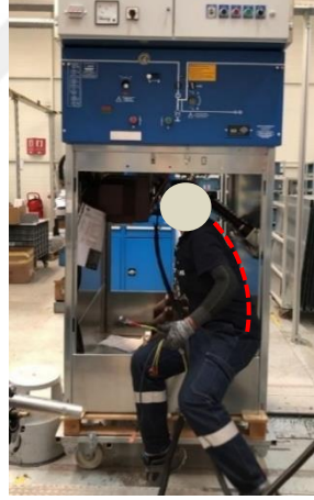
Şekil 71 Pano içi kablo bağlantıları alt faaliyet adımı
