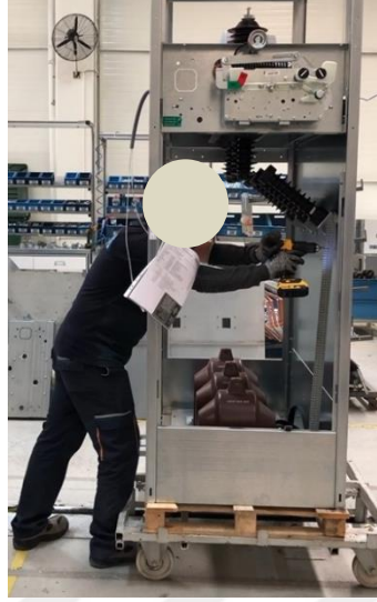
Şekil 35 Operatörün kablo kanallarını şarjlı el matkabı ile montaj işlemi alt faaliyet adımı
