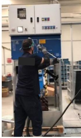
Şekil 70 Pano içi kablo bağlantıları alt faaliyet adımı
