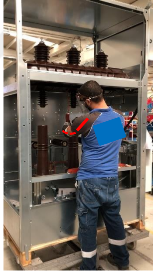
Şekil 56 Kesici ve ayırıcı bağlantı bakırları montaj alt faaliyet adımı
