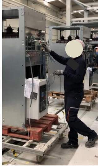
Şekil 43 Yük ayırıcı switch montaj işlemi alt faaliyeti adımları
