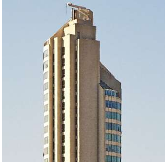
Şekil 5. 76: Simetri bozan çekirdeğin cephe görüntüsü (url-81)
