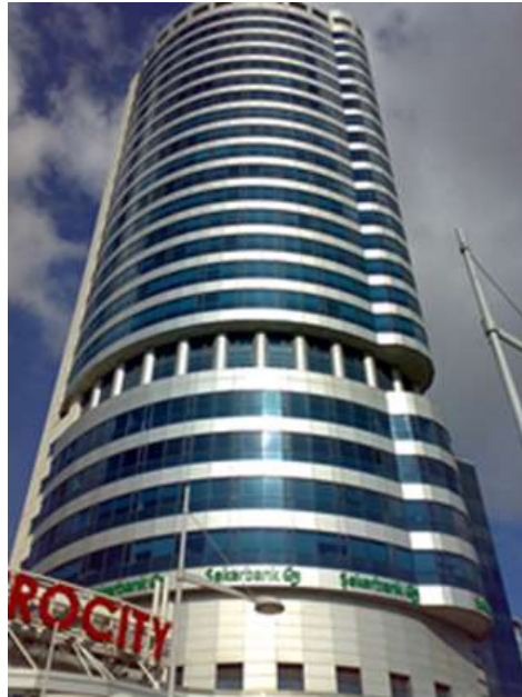
Şekil 5. 63: Ofis Kulesi Cephesinde Duvar ve Cam Malzemenin Değişkenliği (url-76)
