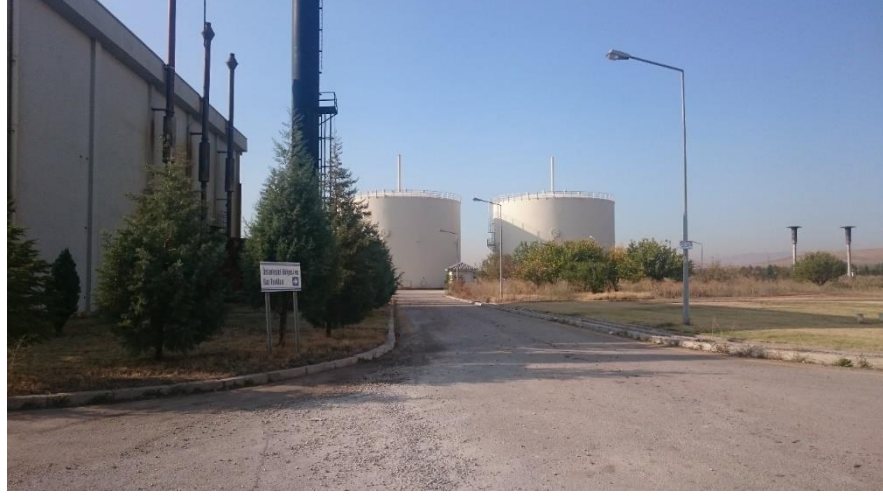
Şekil 6. 122 : Biyogaz Ölçüm İstasyonu
