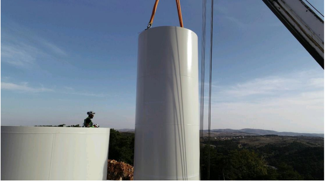
Şekil 6. 70 : Rüzgar Türbini Kulesinin Montajı
