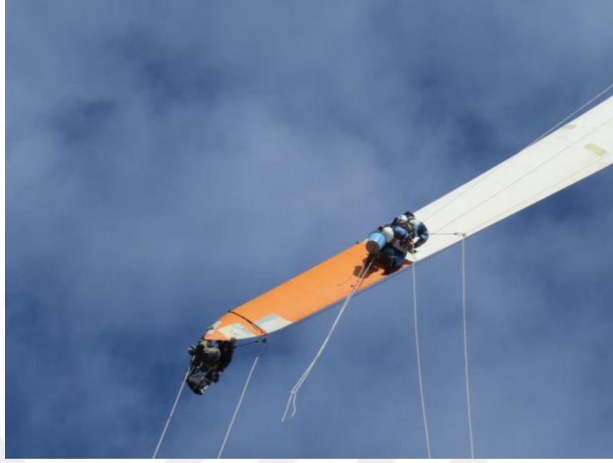
Şekil 6. 44 : Türbin Kanatlarında Bakım-Onarım Faaliyeti
