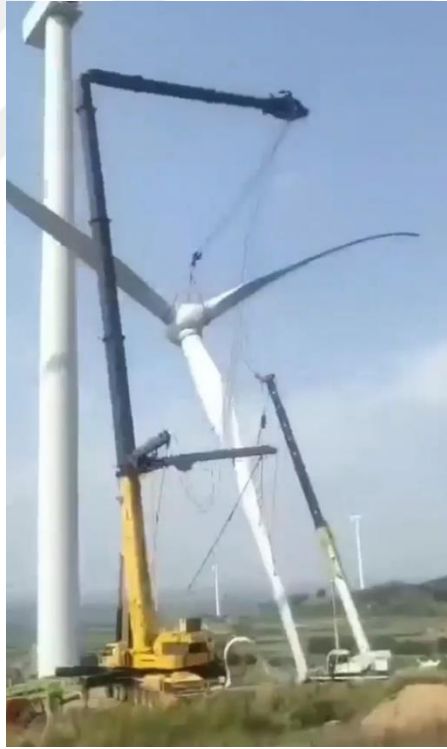
Şekil 6. 54 : Rüzgar Türbini Kanadının Montajı
