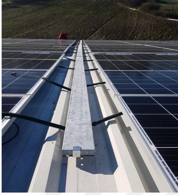
Şekil 6. 34 : Panel Topraklama
