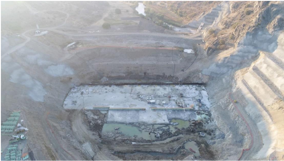
Şekil 6. 89 : Hidroelektrik Sahanın Kurulumu
