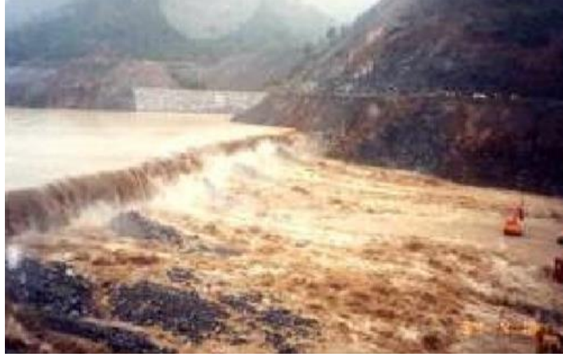
Şekil 6. 76 : İnşaat Halindeki Hidroelektrik Santrali Taşkın Görüntüsü
