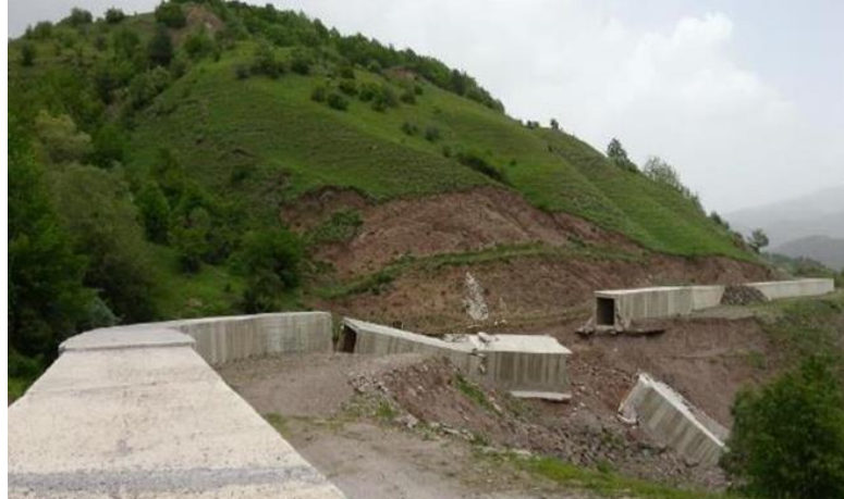
Şekil 6. 77 : Toprak Kayması Neticesinde Hasar Gören İleti Kanalı
