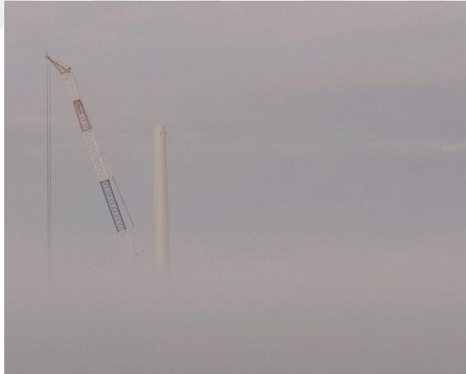
řekil 6. 69 : Sisli Havada Kule Montajı
