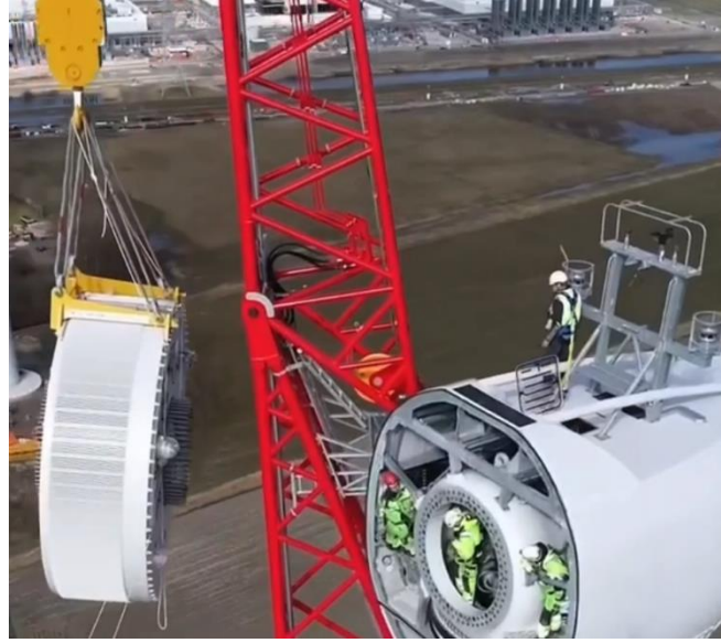
Şekil 6. 72 : Rotor Ekipmanının Montajı
