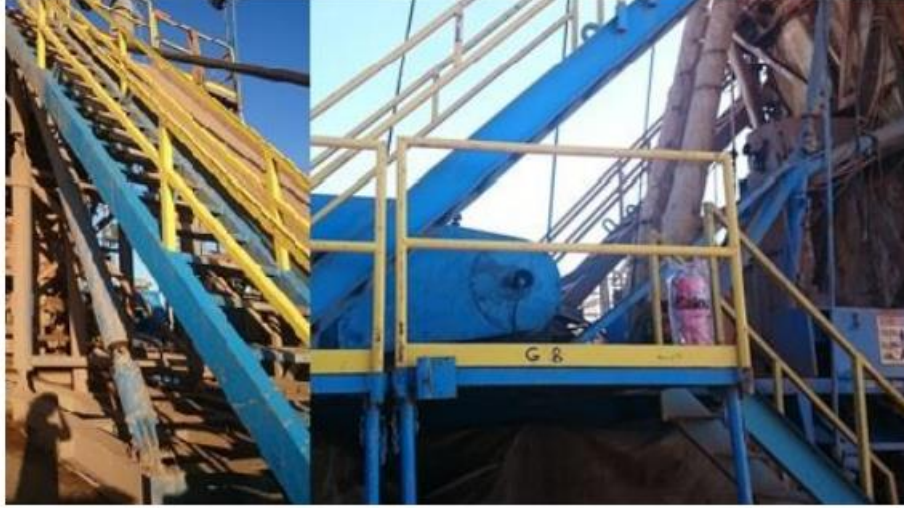
Şekil 6. 119 : Kule Ve Merdiven Korkulukları
