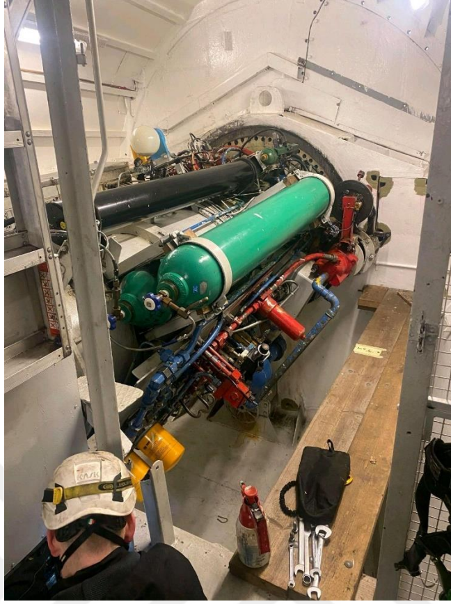
Şekil 6. 73 : Nacelle İçerisinde Bakım Çalışması
