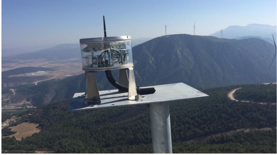
Şekil 6. 66 : Uçak İkaz Lambası
