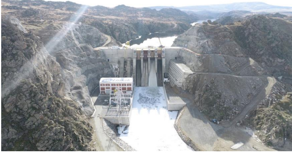
Şekil 6. 90 : Hidroelektrik Sahanın Kurulumu
