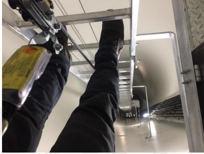
Şekil 6. 65 : Asansör İçerisindeki Yaşam Halatı
