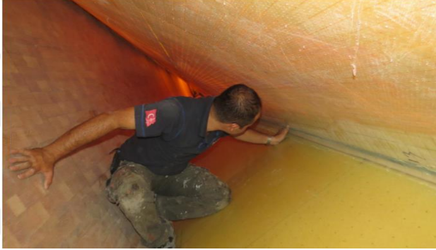
Şekil 6. 60 : Kanat İçerisinde Dar ve Kapalı Alanda Gerçekleşen Bakım Çalışması
