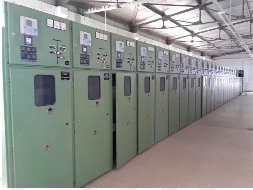
Şekil 6. 152 : Ayrıcı Ve Kesici Kumanda Odası
