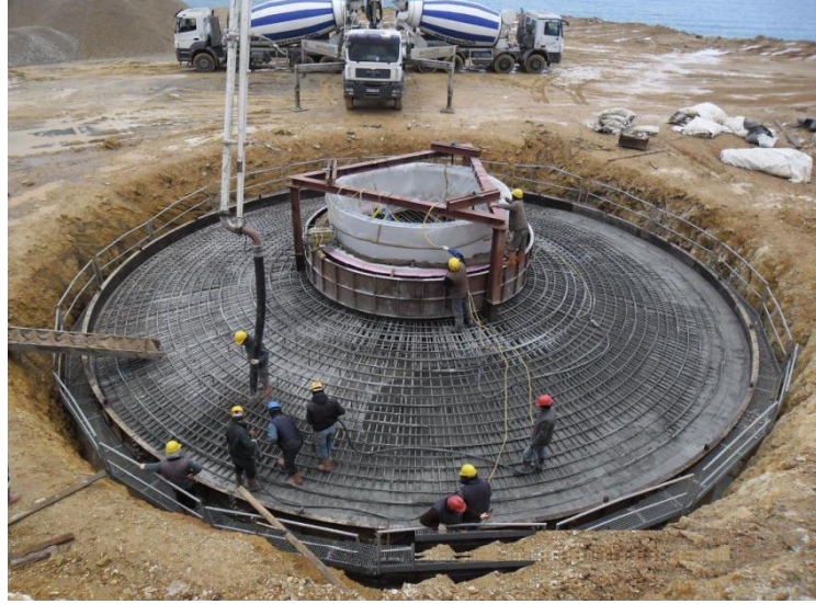
Şekil 6. 63 : Türbinin Yerleştirileceği Alana Beton Döküm İşlemi
