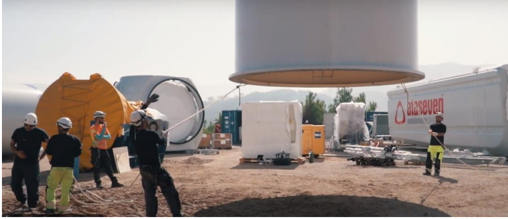
Şekil 6. 74 : Rüzgar Enerji Santrali Kule Montajı
