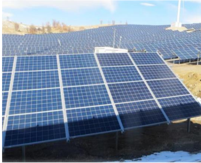
Şekil 6. 41 : Panele Gölge Düşme Olayı
