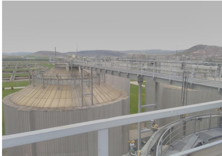
Şekil 6. 125 : Digester Acil Durum Vanaları
