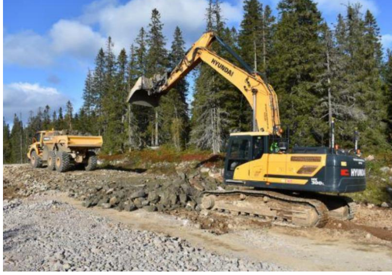
Şekil 6. 62 : Rüzgar Enerji Santrali İçin Yapılan Yol Çalışması
