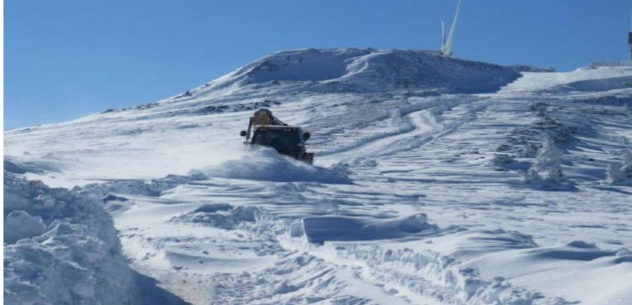
Şekil 6. 59 : Rüzgar Enerji Santralinin Kış Görünümü
