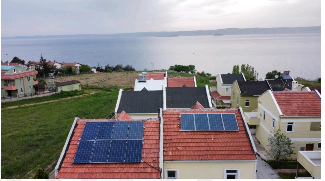
Şekil 6. 35 : Konut Çatı Tipi Uygulaması
