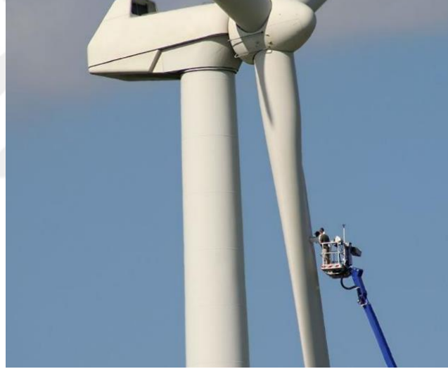
Şekil 6. 45 : Türbin Kanatlarında Bakım-Onarım Çalışması
