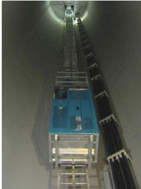
Şekil 6. 64 : Türbin İçerisinde Asansör İle Ulaşım
