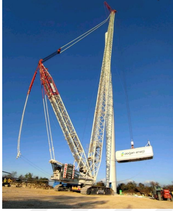
Şekil 6. 67 : Nacelle Kutusunun Montajı
