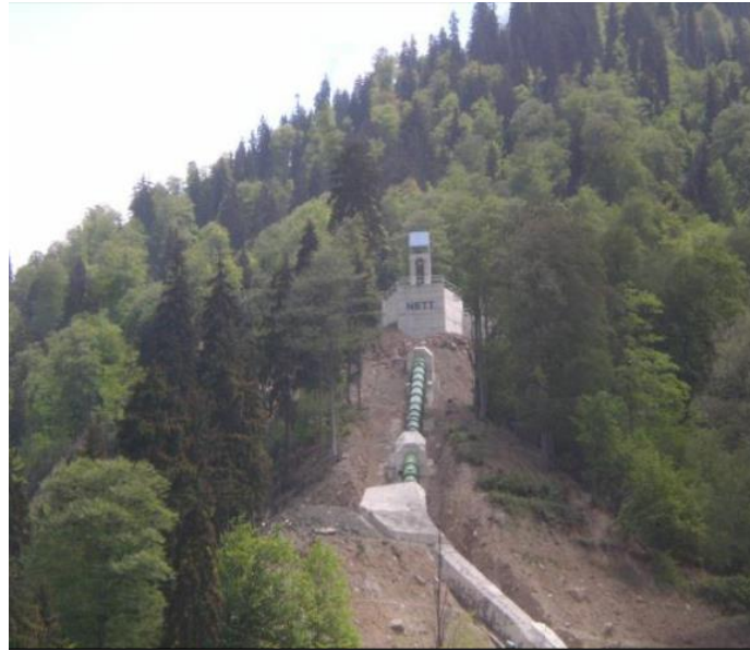
Şekil 6. 82 : Cebri Boruların Engebelik Alanda Görünümü
