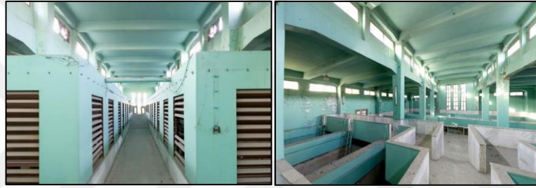
Şekil 126: Su Süzgeci Filtre İstasyonu Yapısı (Url-80)
