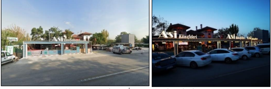
Şekil 207: AOÇ Gazi Tren İstasyonu Yol Cephesi (Url-133)
