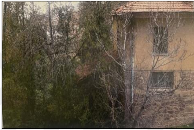
Şekil 107: Bedesten Pompa İstasyonu Yapısı (A.K.V.K.B.K.M.A. Bedesten Su Deposu ve Pompa İstasyonu Dosyası)
