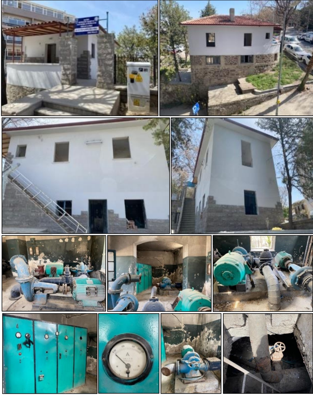
Şekil 108: Bedesten Pompa İstasyonu Yapısı ve Sahip Olduğu Özgün Teçizatlar
