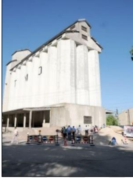
Şekil 96: Polatlı Silosu Restorasyon Aşaması (Anonim)
