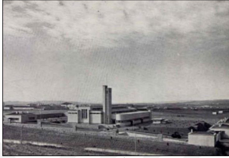
Şekil 127: Su Süzgeci Filtre İstasyonu Yapısı (Url-81)
