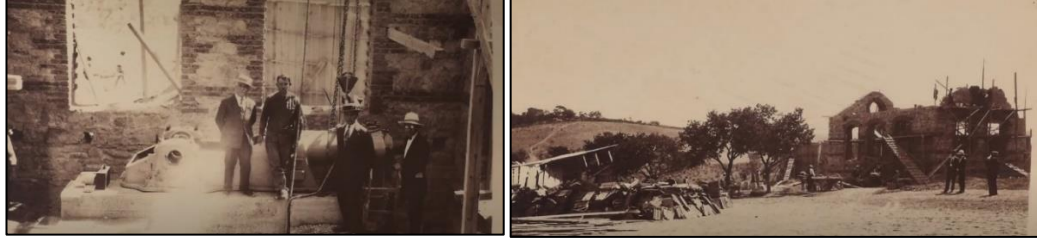
Şekil 111: Kavaklıdere Pompa İstasyonu Montajı, 1927 Yılı (Yurdanur 2018: 12-13)
