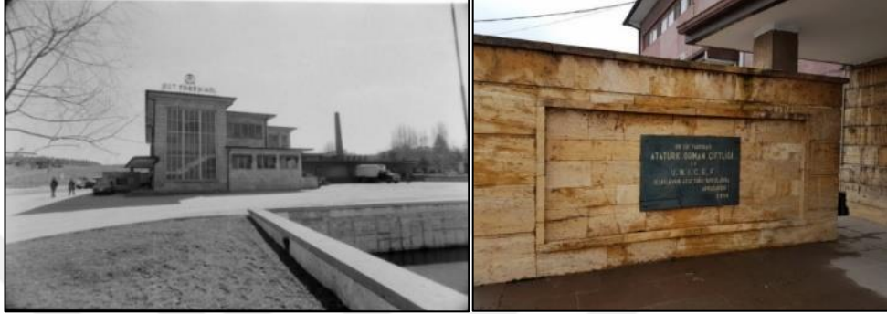
Şekil 53: AOÇ Süt Fabrikası Yapısı (A.K.V.K.B.K.M.A. AOÇ Süt Fabrikası Dosyası)
