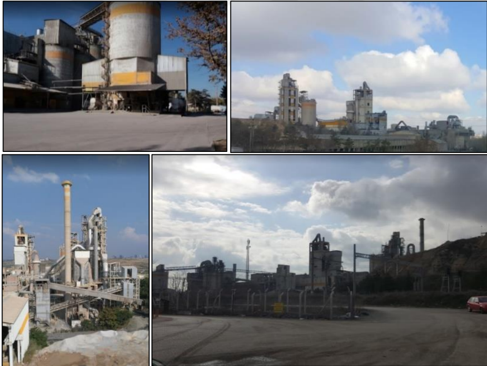
Şekil 193: Ankara Çimento Fabrikası (Url-124)
