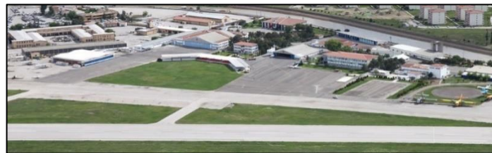
Şekil 146: Etimesgut Uçak Fabrikası 2021 Yılı (Url-88)
