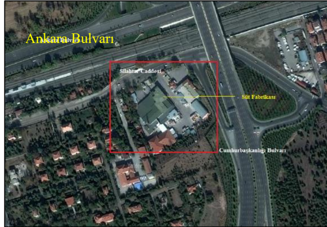
Şekil 50: AOÇ Süt Fabrikası Yapısı Konumu (Url-40)
