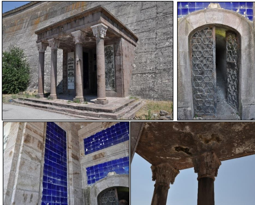
Şekil 117: Çubuk Barajı, Baraj Kapısı (A.K.V.K.B.K.M.A. Çubuk Barajı Dosyası)
