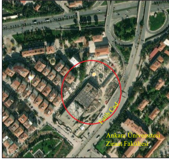
Şekil 125: Su Süzgeci Filtre İstasyonu Konumu (Url-79)
