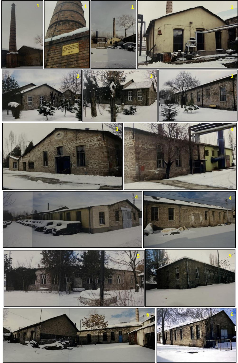
Şekil 160. Ankara Fişek Fabrikası Yapıları (A.K.V.K.B.K.M.A. Fişek Fabrikası Dosyası)
