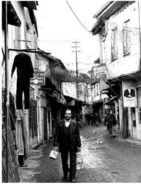
Şekil 93: Hacidoğan Mahallesi Çerkeş Sokak Çöküntü Bölgesi Haline Gelmeden Önce (Tunçer, Kişisel Arşiv)
