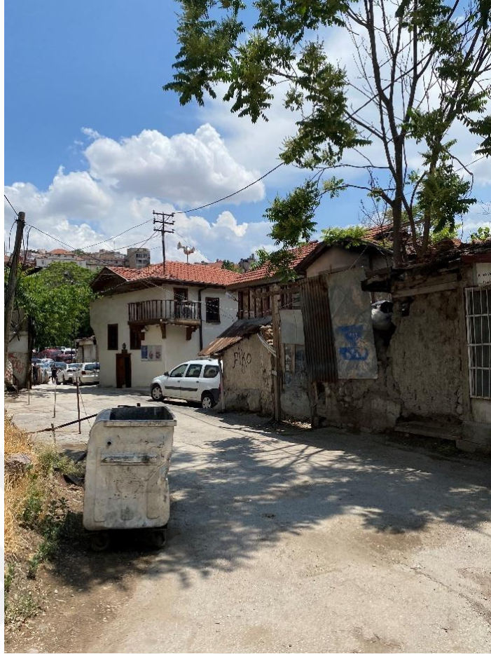
Şekil 128: Çerkes Sokak Yapısal Durum (Fotoğraf: Gür, C., 03/06/2022)
