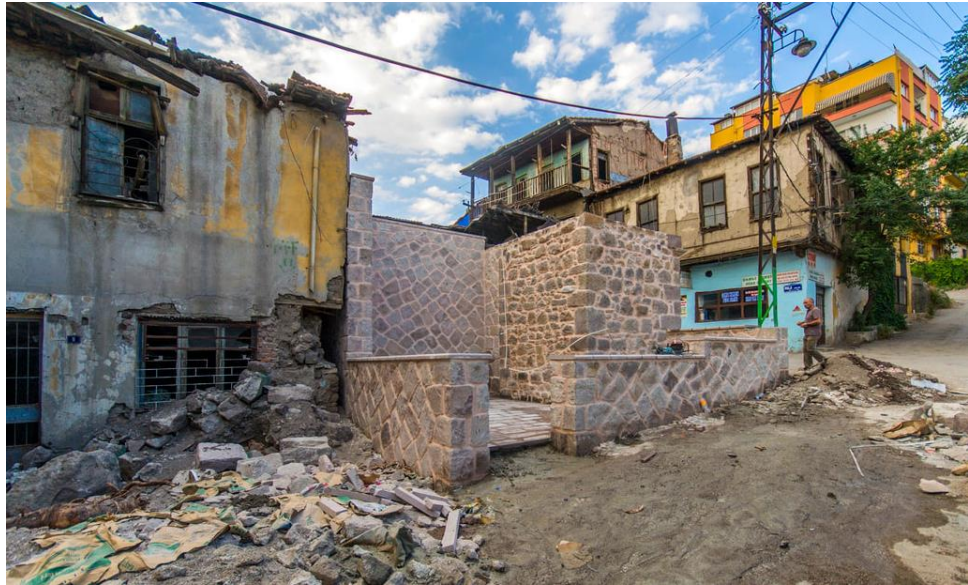
Şekil 95: Beton Yığınları Arasında Yok Olan Hacıdoğan Mahallesi (URL-45)
