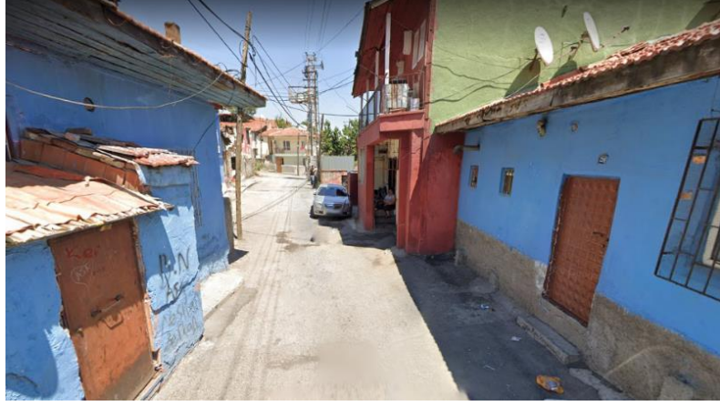
Şekil 134: Kale Mahallesi 3. Sokak Çevresel Kirlilik ve Altyapı Eksikliği (Google Haritalar Sokak Görünümü 2022)
