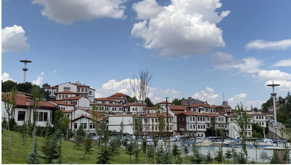
Şekil 150: Hacı Bayram'da Restore Edilmiş Yapılar (Fotoğraf: Gür, C., 26/05/2022)
