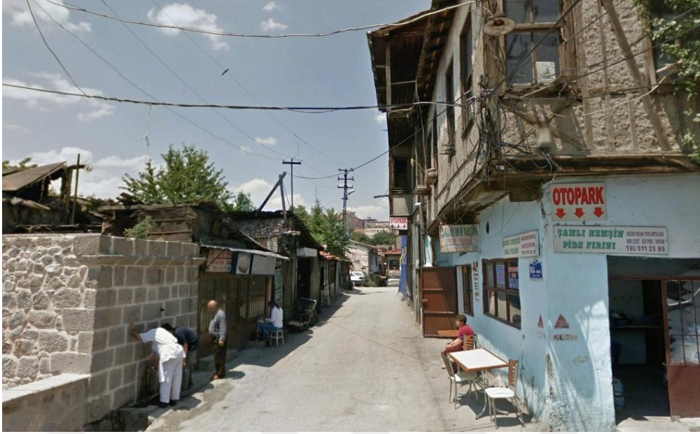
Şekil 130: Pala Sokak Altyapı Eksikliği ve Yapısal Durum (Google Haritalar Sokak Görünümü 2020)
