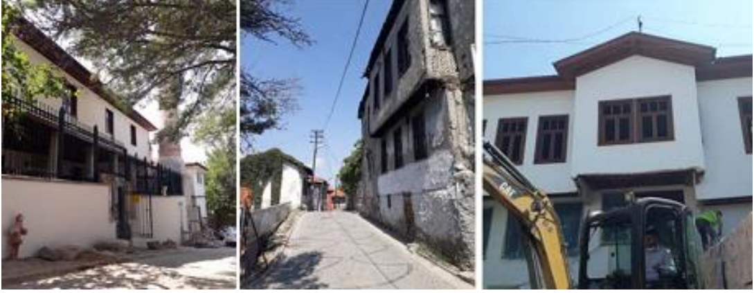
Şekil 87: Yenileme Çalışmaları Devam Eden Sokak ve Binalar (Sönmez vd., 2021)
