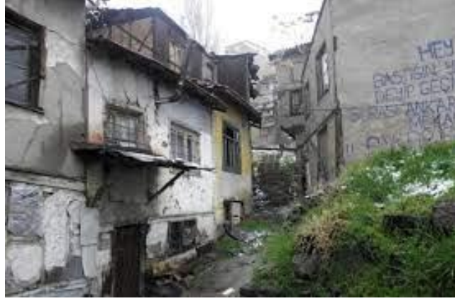
Şekil 92: Çöküntü Bölgesine Dönüşen Hacidoğan Mahallesiindeki Evler (URL-44)
