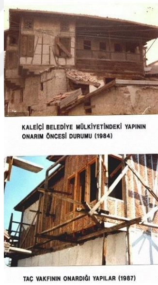
Şekil 81: Kale İçi Onarım Öncesi ve Sonrası Yapılar (URL-38)
