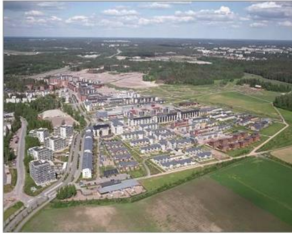
Şekil 10: Latokartano Konut Bölgesinin Güneyden Görünüşü (Adil, 2010)
