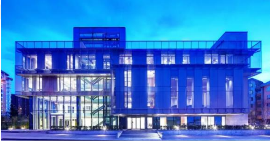
Şekil 4.1: Türkiye Mütcahhitler Birliği Binası Cephe Görsel (TMB 2022)
