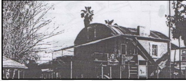
Şekil 3.25: Adana İlk Gar Binası, 1912. Kaynak: Akpolat, 2004.
