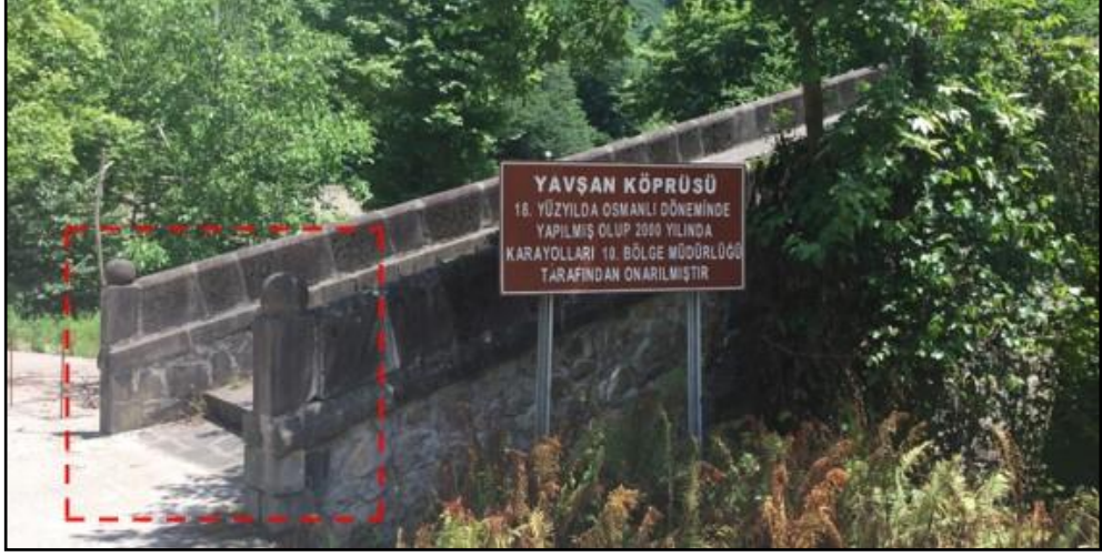
Şekil 42: Taş köprüye ait bir eleman olan baba taşı örneği Yavşan Köprüsü, Giresun-Homurlu Mahallesi Yağmurca Köyü arası (Yazarın Arşivi)
