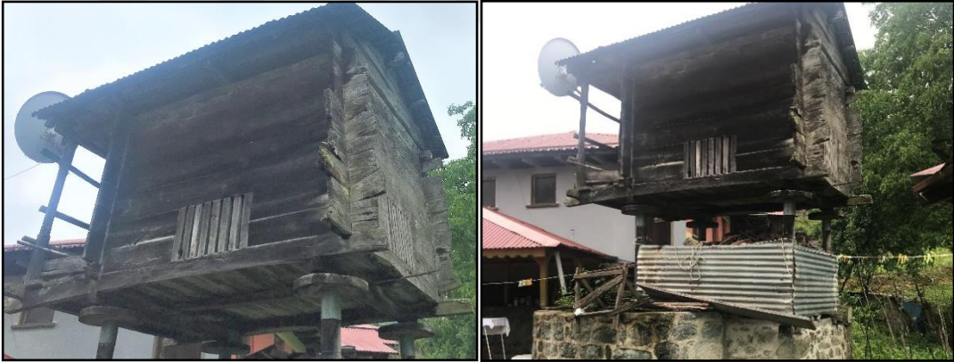
Şekil 71: Ekleme ve özgün olmayan malzeme sonucu “örüntü dili” kriteri dışında kalan serender örneđi Artvin-Arhavi-Kireçlik Köyü (Yazarın Arşivi)
