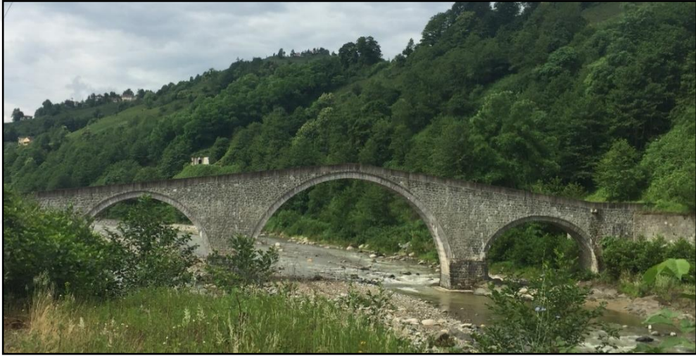
Şekil 37: Farklı büyüklükteki açıklıklardan oluşan taş köprü örneği Koca Köprü, Rize-Pazar-Kocaköprü Köyü (Yazarın Arşivi)
