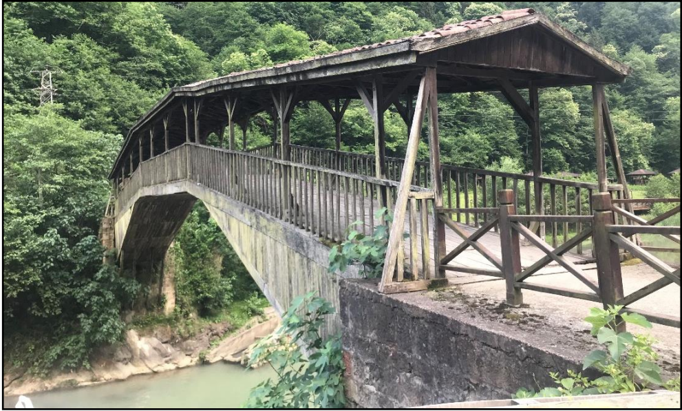
Şekil 33: Ahşap köprülerde strüktürel boşluk Hapsiyaş Köprüsü, Trabzon-Of (Yazarın Arşivi)
