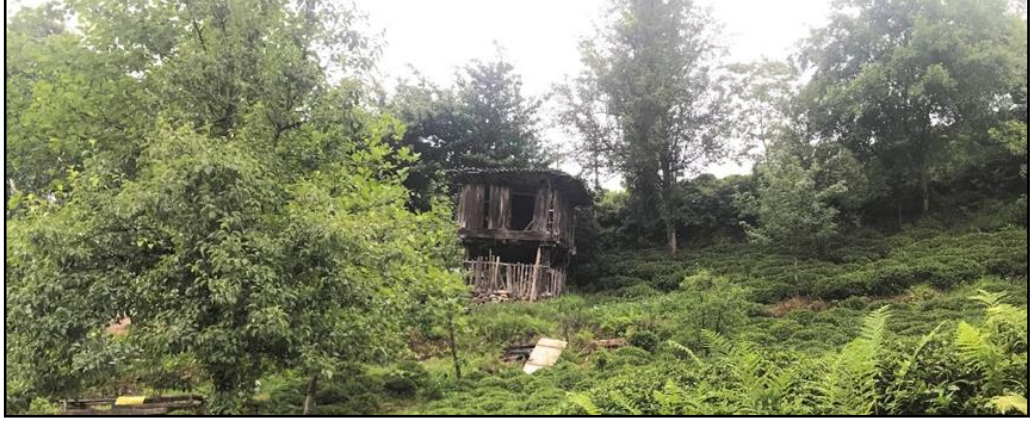
Şekil 72: Bakımsızlık nedeniyle işlevselliğini yitiren serender örneği Rize-Merkez-Kömürcüler Köyü (Yazarın Arşivi)
