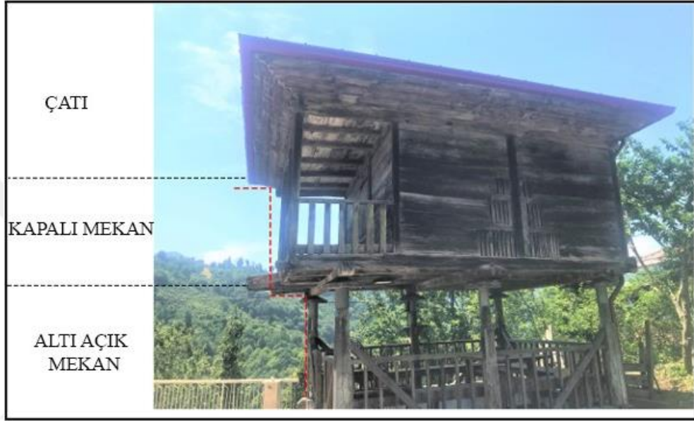
Şekil 57: Yukarıya doğru genişleyen serender örneği Trabzon-Sürmene-Dirlik Mahallesi (Yazarın Arşivi)
