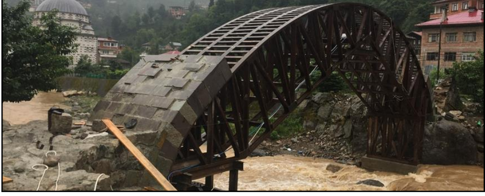
Şekil 63: Farklı bir strüktürel sistemle “yeniden” inşa edilen taş köprü Ambarlık Köyü Köprüsü, Rize-Merkez-Ambarlık Köyü (Yazarın Arşivi)
