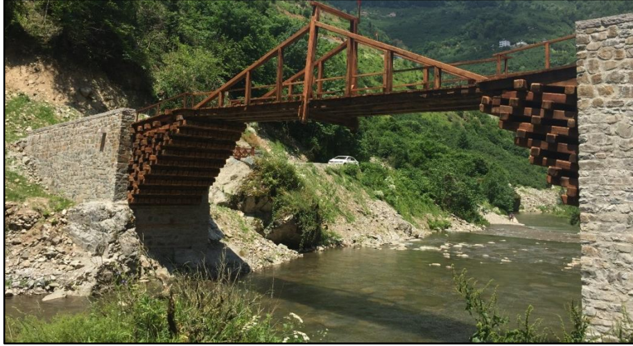
Şekil 45: Ahşap köprülerde strüktürel boşluk Başkotanı Köprüsü, Ordu-Mesudiye-Kabadüz (Yazarın Arşivi)
