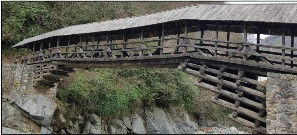
Şekil 44: Taşıyıcı ayağa bindirilen ana ve konsol kirişler Buzlupınar Köprüsü, Rize-Çayeli-Buzlupınar köyü (Yazarın Arşivi)
