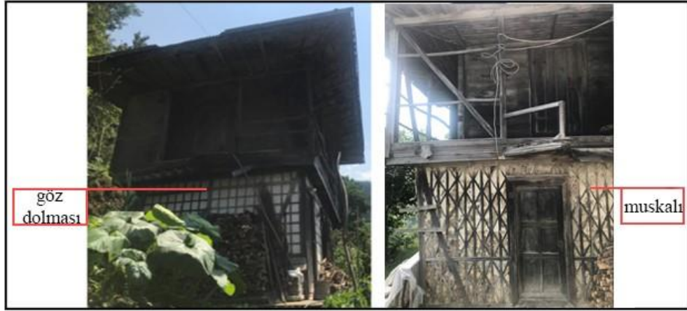
Şekil 54: Zemin katta göz dolma veya muskalı göz dolma tekniği uygulanan serender örneği Trabzon-Dernekpazarı-Tırhandoz Köyü ve Kondu Köyü (Yazarın Arşivi)
