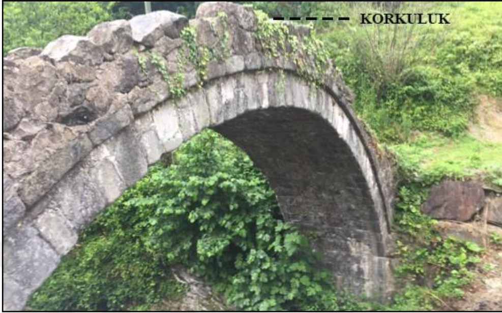
Şekil 40: Korkuluğun dairesel olarak biçimlendiği taş köprü örneği Başoba Köyü Köprüsü, Artvin-Hopa-Başoba Köyü (Yazarın Arşivi)
