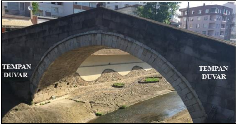
Şekil 39: Tempan duvarın kesme taştan inşa edildiği köprü örneği Köprü 1, Ordu-Altınordu-Selimiye Mahallesi (Yazarın Arşivi)
