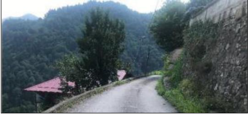
Şekil 24: Teras-yol ilişkisi özelinde örüntü dili Trabzon-Dernekpazarı-Kondu Köyü (Yazarın Arşivi)
