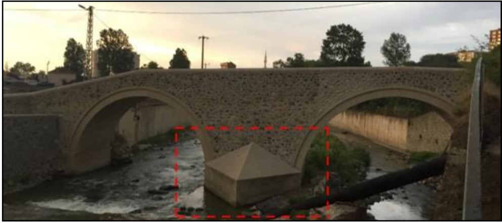
Şekil 43: Selyaran bulunan taş köprü örneği Kalamina (Söğütlü) Köprüsü, Trabzon-Akçaabat-Osmanbaba Mahallesi (Yazarın Arşivi)
