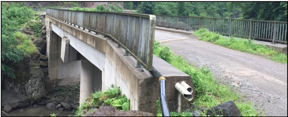
Şekil 64: Yıkılan tarihi ahşap köprü yerine “yer”in fiziksel niteliğine aykırı olarak “yeniden” inşa edilen köprü Kayaaltı Köprüsü, Ordu-Altınordu-Ambarlık Köyü (Yazarın Arşivi)
