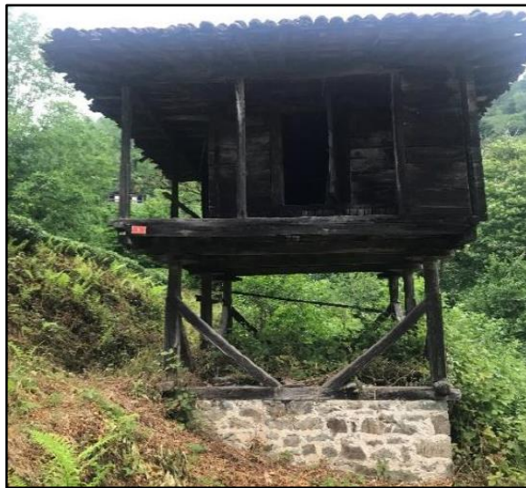
Şekil 55: Serenderde depo alanının oluşturulması Artvin-Arhavi-Arılı Köyü (Yazarın Arşivi)
