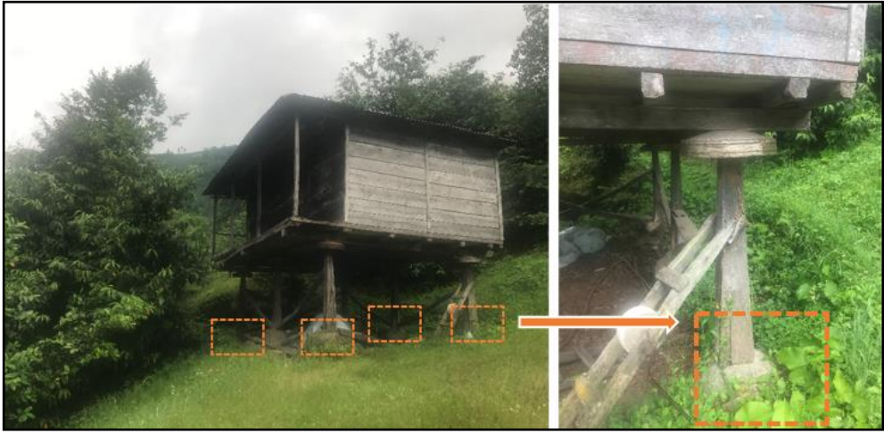
Şekil 51: Yer seçiminde düz zemin üzerine kurulan serender örneği Ordu-Altınordu-Gerce Mahallesi (Yazarın Arşivi)
