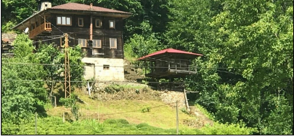
Şekil 26: Teras-yapı yeri ilişkisi özelinde örüntü dili Rize-Hemşin-Ortaköy Mahallesi (Yazarın Arşivi)
