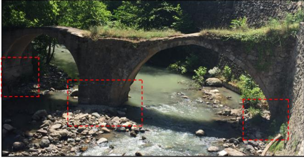
Şekil 31: Taş köprülerde “yer”e kısmen yapılan müdahale Köprü 1, Trabzon-Maçka-Bahçekaya ve Esiroğlu Mahalleleri arası (Yazarın Arşivi)
