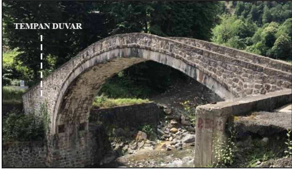
Şekil 38: Tempan duvarın moloz taştan inşa edildiği köprü örneği Ortaköy Köprüsü, Rize-Hemşin-Çaneva Köyü (Yazarın Arşivi)
