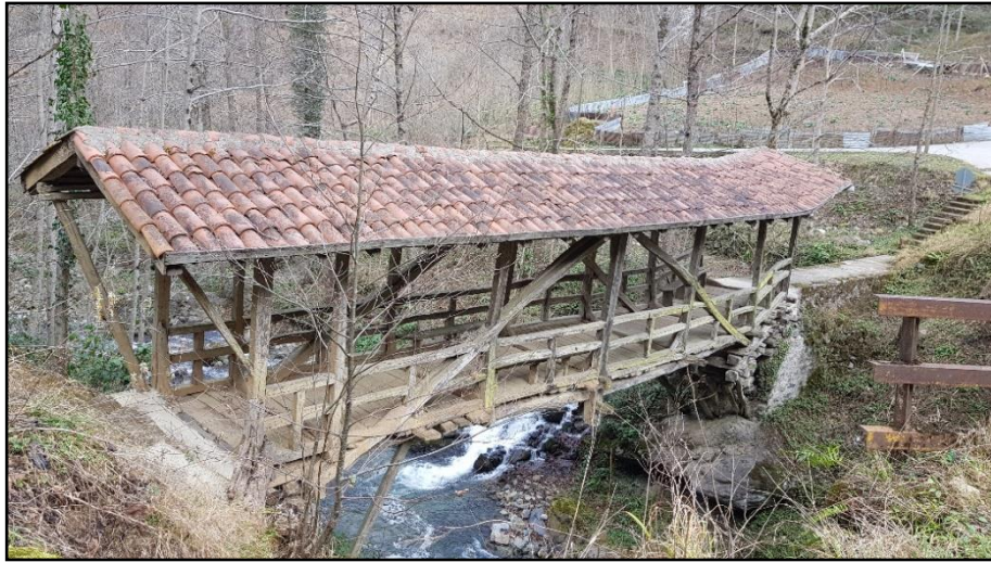
Şekil 46: Ahşap köprüye entegre esilen semer çatı Eğridere Kiremitli Köprüsü, Trabzon-Çaykara-Buzlupınar köyü (Yazarın Arşivi)
