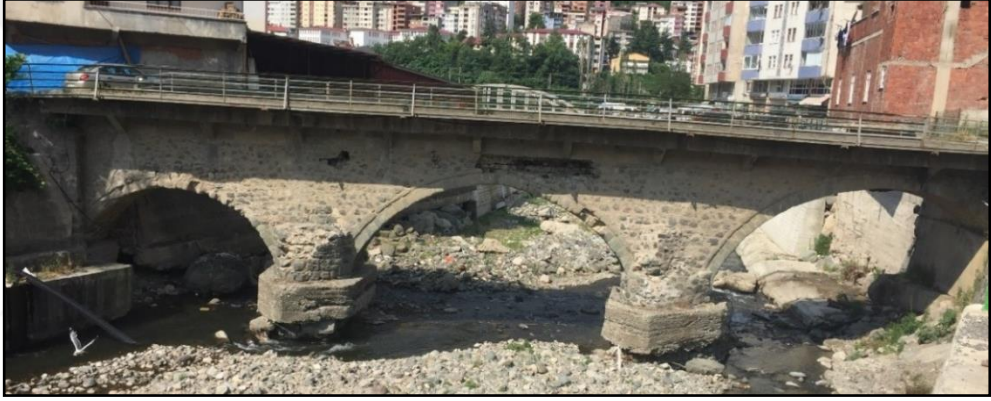
Şekil 60: Yerel malzemenin dışına çıkılarak “yenilenen” köprü örneği Üç Gözlü Kesmetaş Köprüsü, Artvin-Borçka-Aksu Mahallesi (Yazarın Arşivi)
