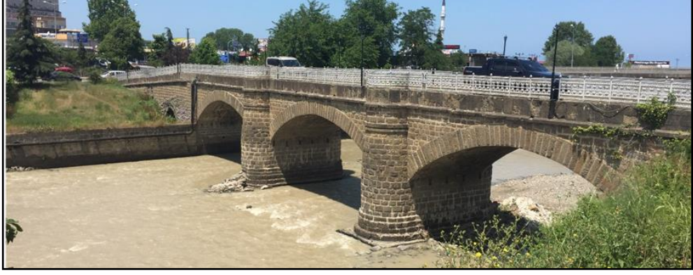
Şekil 61: Özgün malzemeyle ilişkisi olmayan restorasyon örneği Değirmendere Köprüsü, Trabzon-Ortahisar-Sanayi Mahallesi (Yazarın Arşivi)
