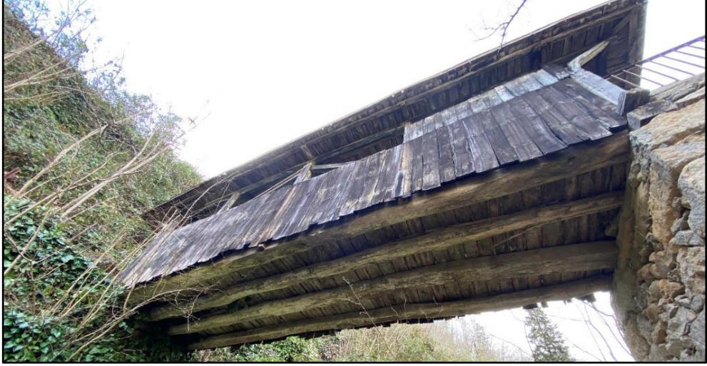
Şekil 32: Ahşap köprülerde “yer”e kısmen yapılan müdahale Yenice Köprüsü, Trabzon-Dernekpazarı-Kondu Köyü (Yazarın Arşivi)
