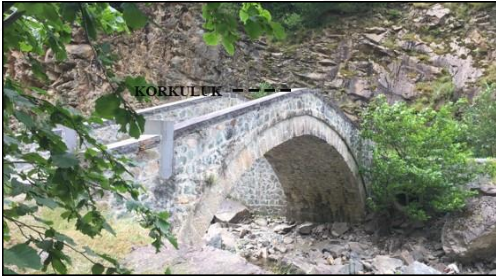
Şekil 41: Korkuluğun üçgensel olarak biçimlendiği taş köprü örneği Sincan Köprüsü, Trabzon-Arsin-Başdurak Mahallesi (Yazarın Arşivi)
