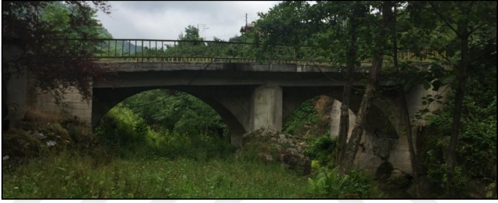
Şekil 62: Eskisi yerine “yer”in fiziksel niteliğine aykırı inşa edilen yeni köprü Değirmenyanı Köprüsü, Ordu-Gülyalı-Kestane Mahallesi (Yazarın Arşivi)
