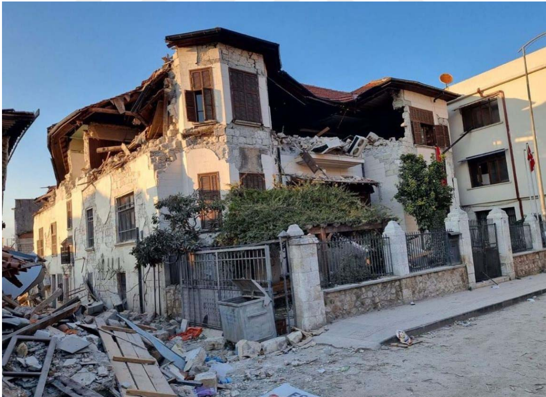
Şekil 6.16: Esnaf Odası (Depremden Sonra)
