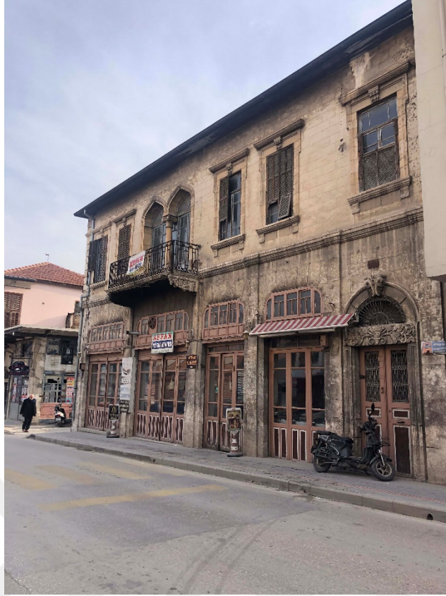
Şekil 6.13: Affan Kahvesi (Depremden Önce)
