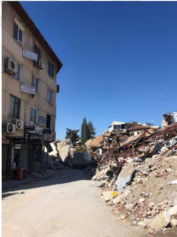
Şekil 6.6: Resmi Bina ve Dükkanları (Depremden Sonra)
