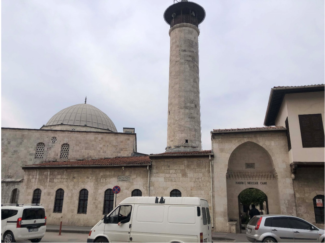
Şekil 6.31: Habib-i Neccar Camii (Depremden Önce)
