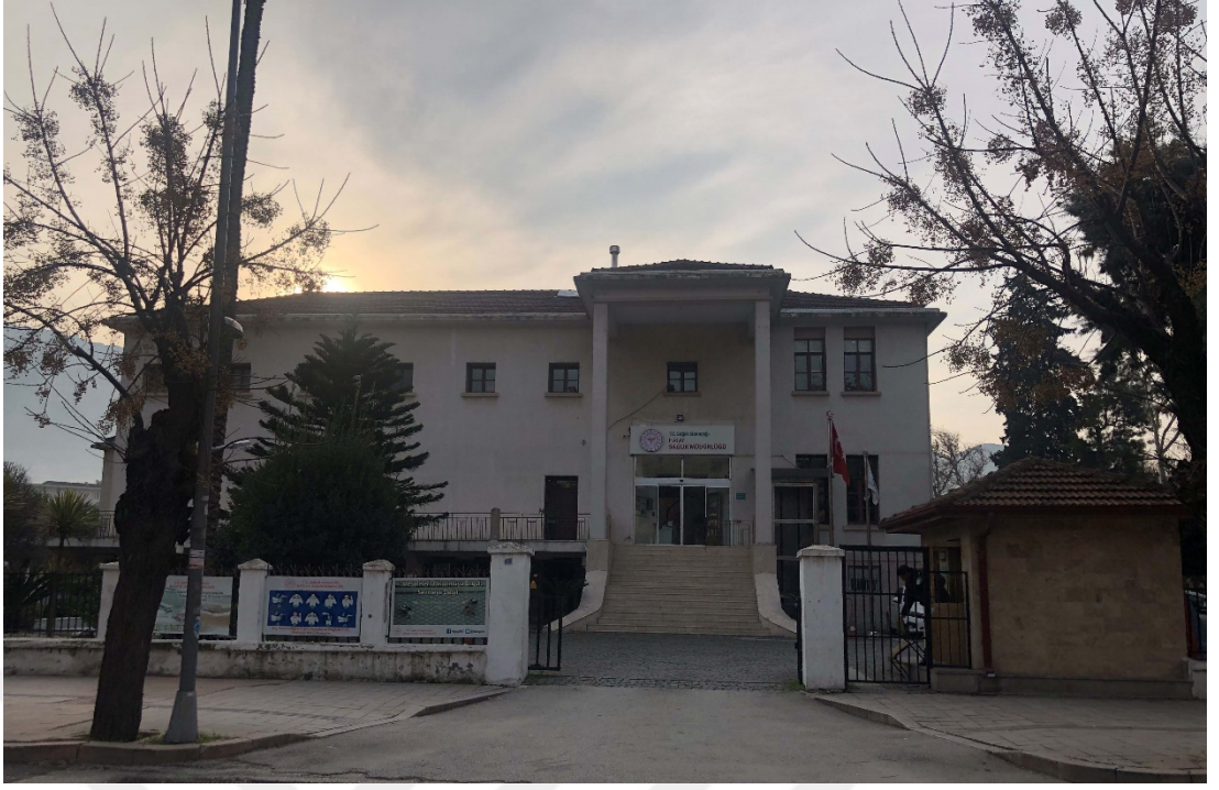
Şekil 6.27: Sağlık İl Müdürlüğü (Depremden Önce)
