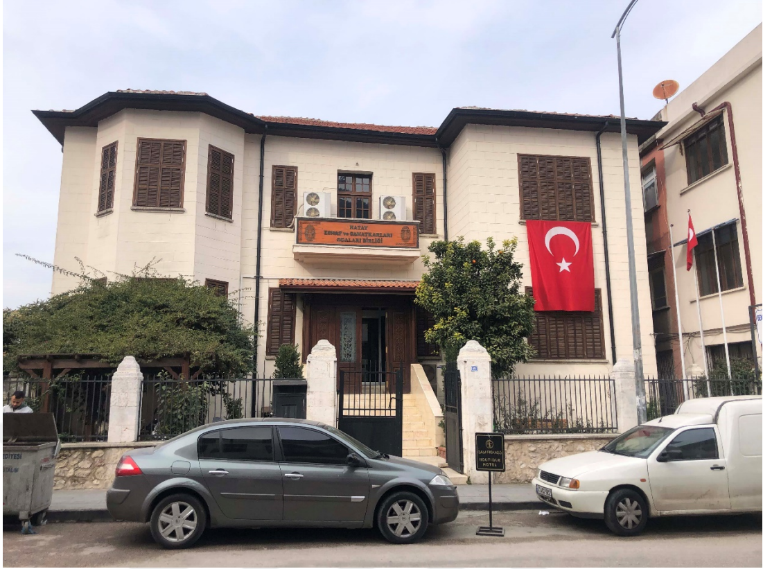
Şekil 6.15: Esnaf Odası (Depremden Önce)
