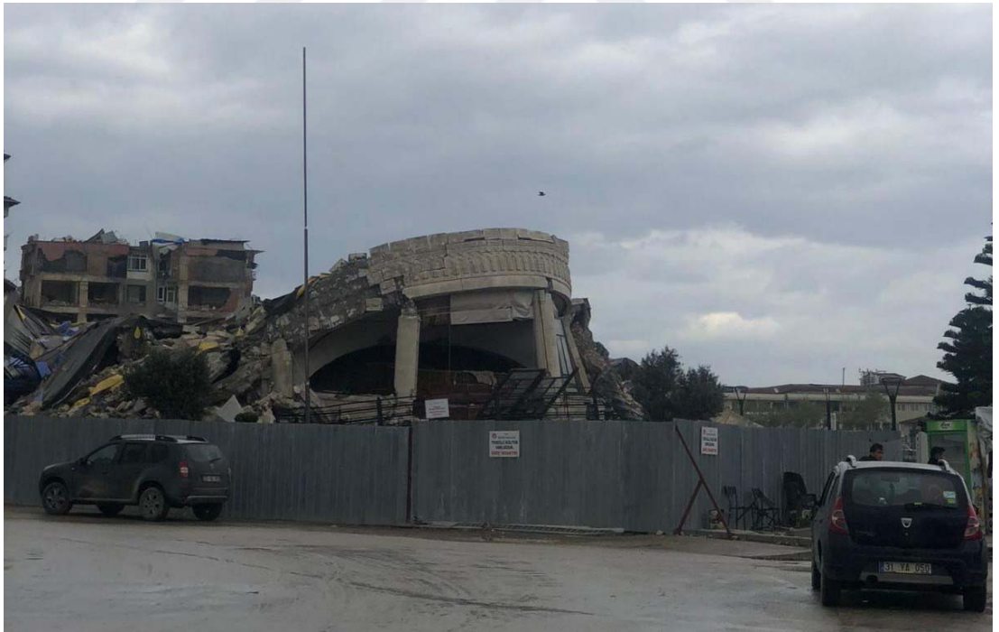
Şekil 6.22: Meclis Binası (Depremden Sonra)
