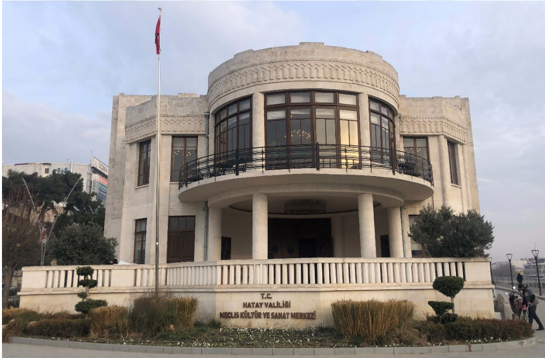
Şekil 6.20: Meclis Binası (Depremden Önce)
