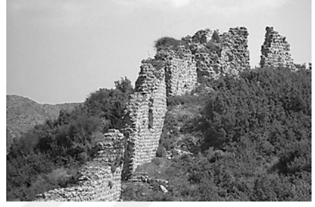
Şekil 5.2 : Antakya Kalesi ve Surları (Kişisel arşiv 2021)
