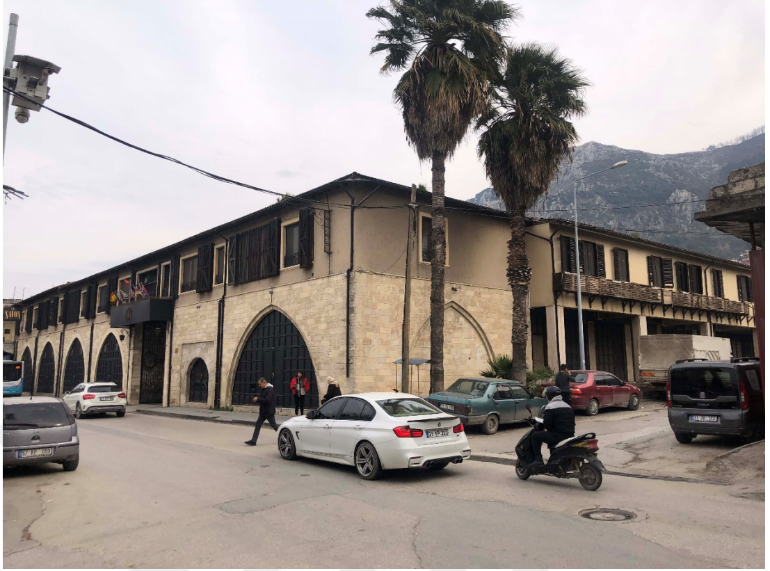
Şekil 6.17: Savon Otel (Depremden Önce)
