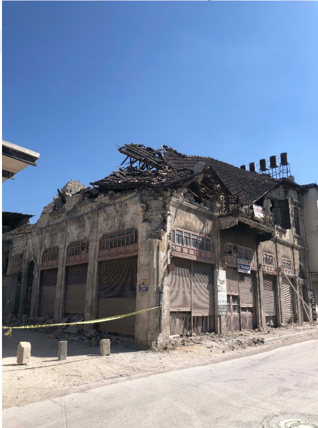
Şekil 6.14: Affan Kahvesi (Depremden Sonra)
