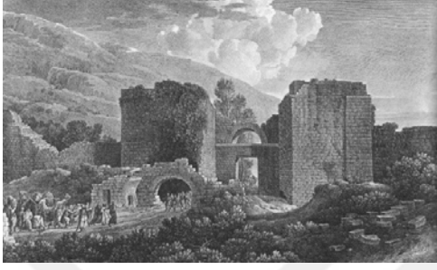
Şekil 5.1 : Antakya Kalesi ve Surları ( Cassastan aktaran İstek 2020)
