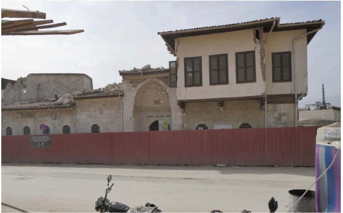
Şekil 6.33: Habib-i Neccar Camii (Depremden Sonra)
