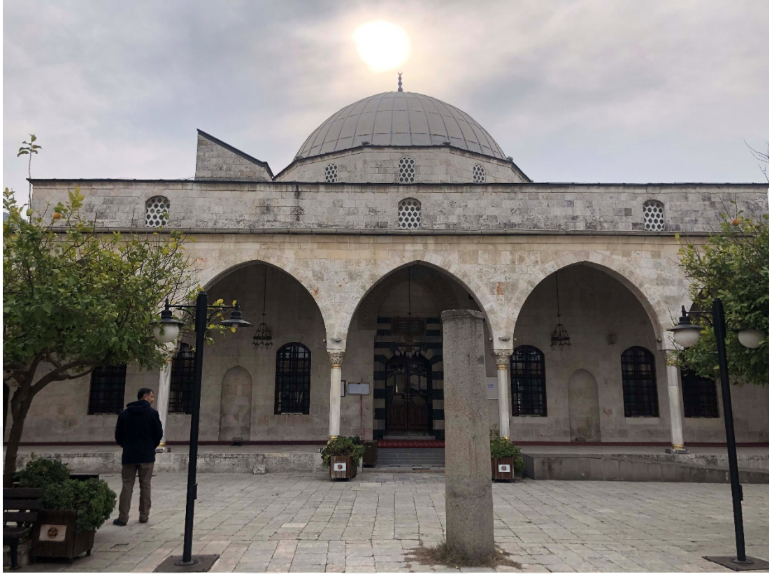
Şekil 6.32: Habib-i Neccar Camii (Depremden Önce)
