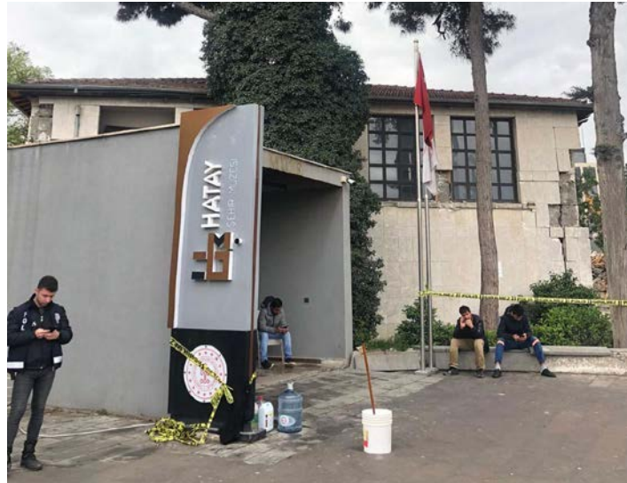
Şekil 6.30: Şehir Müzesi (Depremden Sonra)
