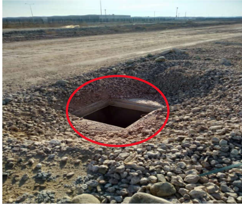
Şekil 2. 4: Yurt İnşaatı (Doğan, 2019)
