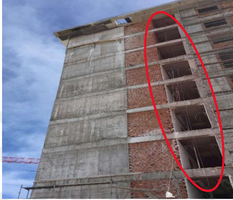
Şekil 2. 3: Yurt İnşaatı (Doğan, 2019)
