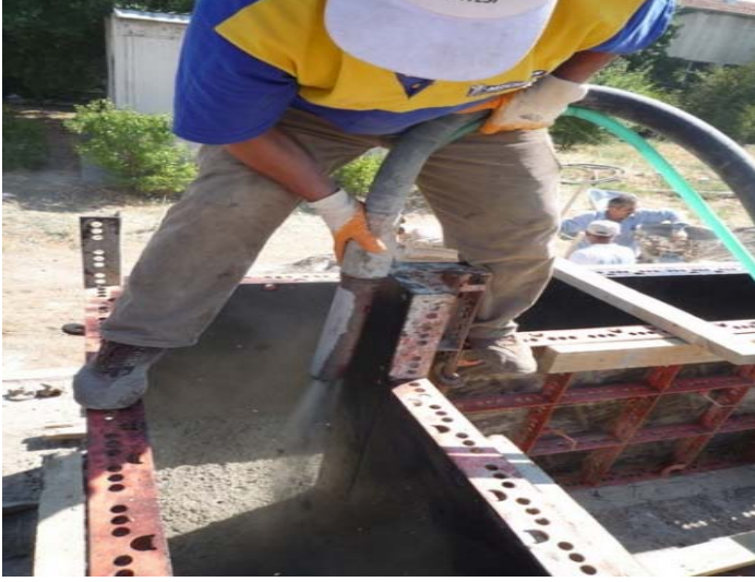
Resim 8. Püskürtme Makinası ile Kalıp İçine Harç Püskürtülmesi
