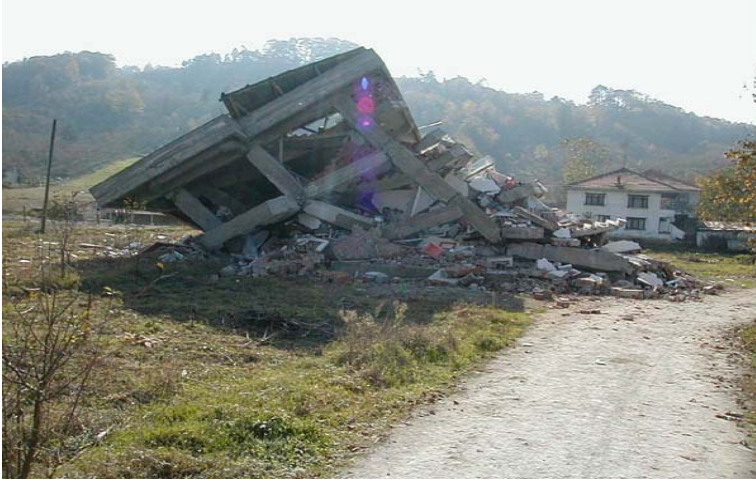
Resim 4. İzmit (1999) Depreminde İskelet ve Yığma Yapı Davranışı
