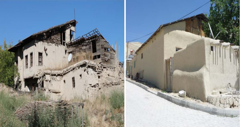
Şekil 12. Solda Sivas Divriği’de (Ceren BİLGE Arşivi 2013), Sağda Malatya Darende’de Düz Toprak Damlı Bir Konuta Eklenen Çatı
