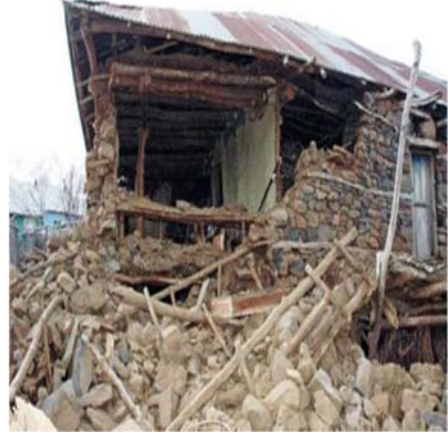
Şekil 15. Elazığ Depreminde Şekil 13a ve 13b'deki Sağlam Kalan Evlerin Yakınında, Yapı Kurallarına Uygun Yapılmadığı İçin Yıkılan Evler (Fotoğraf: B. Büyükyıldırım)
