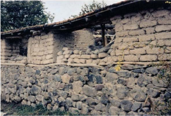
Şekil 11. Zemin Kat Duvarları Toplama Taşlarla Yapılmış Depreme Dayanıksız Bir Yapı, İlhanlı Köyü (Ayaş) (B. Claasz Coockson, Living in Mud )
