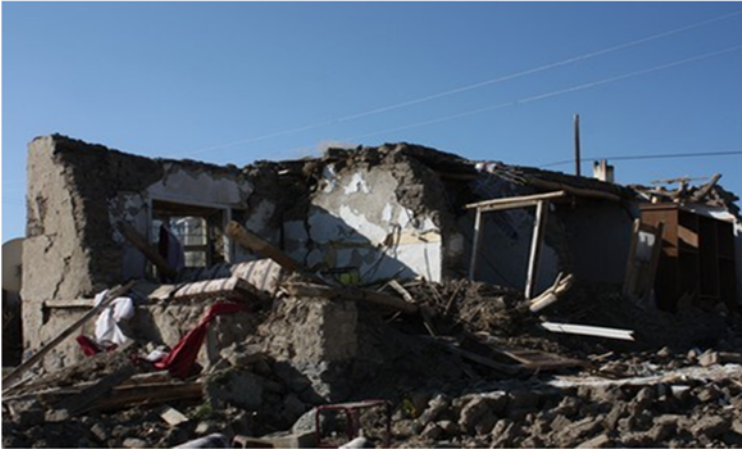
Şekil 16. Van Depreminde Yıkılan Kerpiç Yapılardan Bir Örnek (Fotoğraf: A. Parsa)
