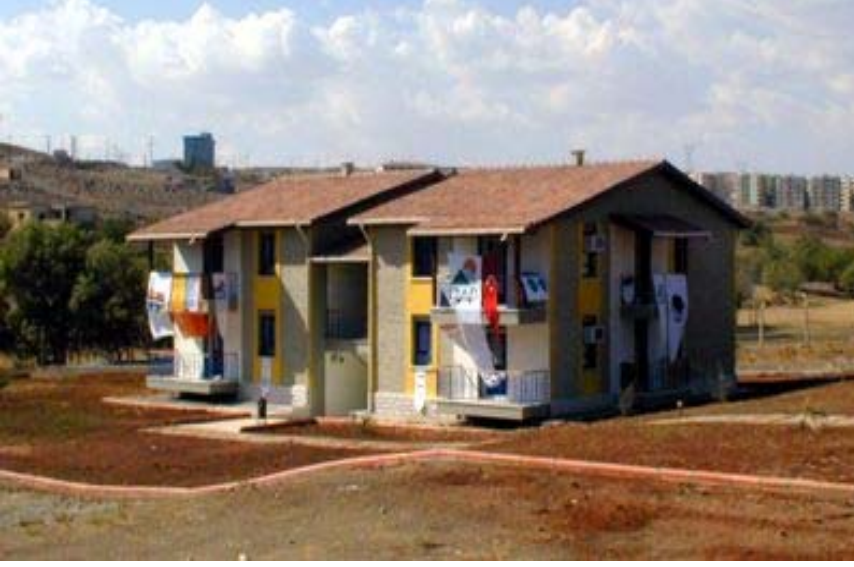
Resim 10. Şanlıurfa - GAP İdaresi Tesislerinde İki Katlı 4 Daireli Örnek Kerpiç Yapı
