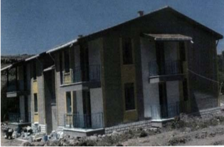
Şekil 8. Marnlı Toprak ve Çimento Karışımı Bloklarla Yapılmış Yığılma Yapı; 4 Daireli Lojman. Şanlıurfa, 2000 (Proje ve Uygulama: Prof. B. Işık)
