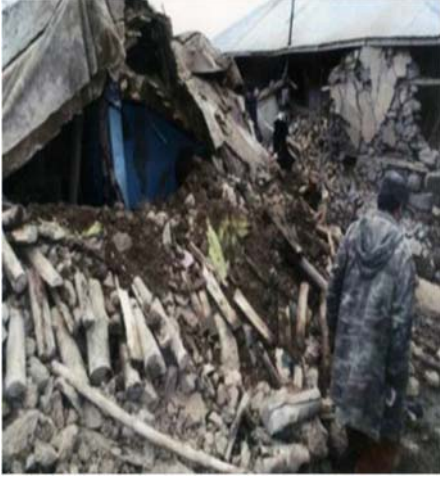
Şekil 15. Elazığ Depreminde Şekil 13a ve 13b'deki Sağlam Kalan Evlerin Yakınında, Yapı Kurallarına Uygun Yapılmadığı İçin Yıkılan Evler (Fotoğraf: B. Büyükyıldırım)
