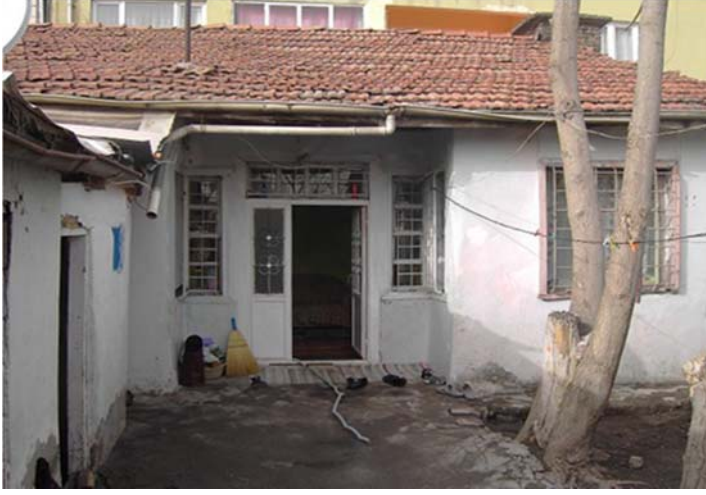
Şekil 19. Düzce-Gölcük-Yalova Hattı Üzerindeki Altınova'da Petek Çiftliği'nde 1950'de Y. Müh. Mimar Özer ARIN'ın Yaptığı Kerpiç Evler, Büyük Ölçüde Yapının Yıkılmasına ve Can Kaybına Sebep Olan 1999 Marmara Depreminde Sağlam Kalmıştır.
