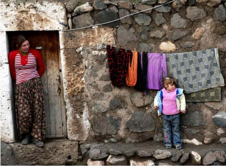
Şekil 10. Dere Yataklarından Toplanmış Taşlar ve Çamur Harçla Yapılmış Bir Duvar, Gaziemir Köyü (Aksaray) ( www.fotokritik.com/kullanici/kibele ).
