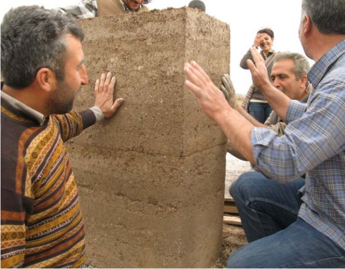
Resim 7. Tokmamlama Tekniği İle Duvar
