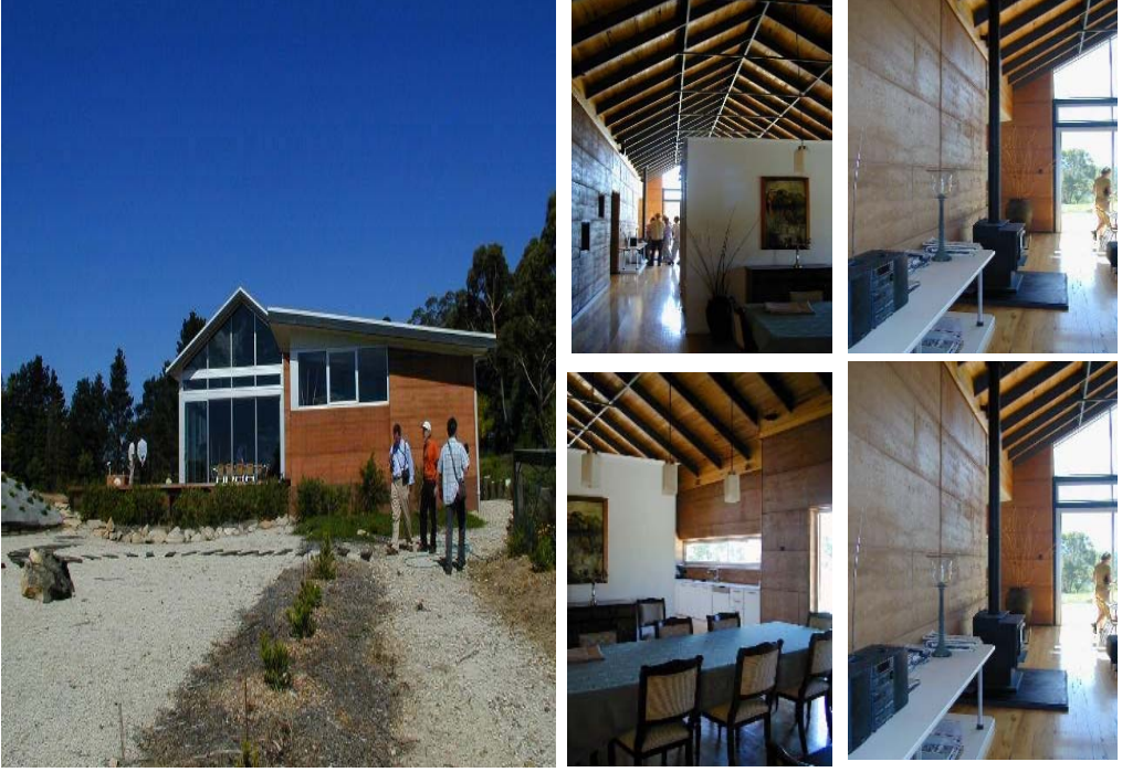
Resim 9. Avustralya'da Tokmıklama Tekniği ile Kerpic (Toprak) Yapı
