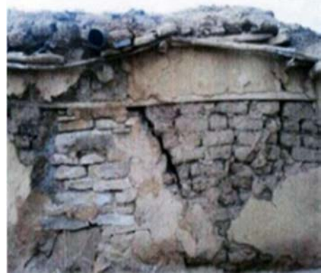
Şekil 21. Hatıllı Duvarda Deprem Etkisi; Deprem Çatlağı Hatılda Kesiliyor
