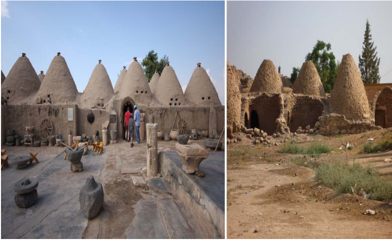
Şekil 5. Şanlıurfa'nın Harran İlçesi'nde Bulunan Konik Kubbeli Yığma Kerpiç Geleneksel Yapılardan İki Örnek.
