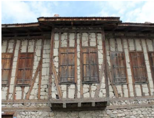
Şekil 7. Safranbolu Yörük Köyü'ndeki Kerpiç Dolgulu Ahşap Karkas-Çatki Sistem (Hımış) Geleneksel Bir Konut
