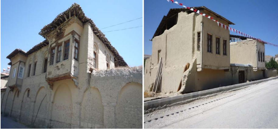
Şekil 9. Malatya İli Yedizönü (Solda) ve Darendede (Sağda) İlçelerinde Yer Alan Karma Sistemle İnşa Edilen Geleneksel Konut Örnekleri.
