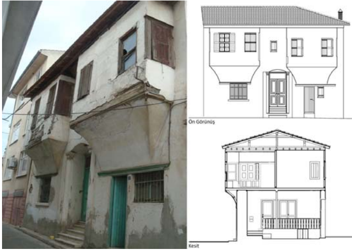
Şekil 10. Balıkesir Havran'da “yığma kerpiç sistem” ve “kerpiç dolgulu ahşap karkas-çatki sistem”in bir arada görüldüğü Karma Sistem Geleneksel Kerpiç Konut (MSGÜ Mimarlık Bölümü Restorasyon Anabilim Dalı Arşivi 2013).
