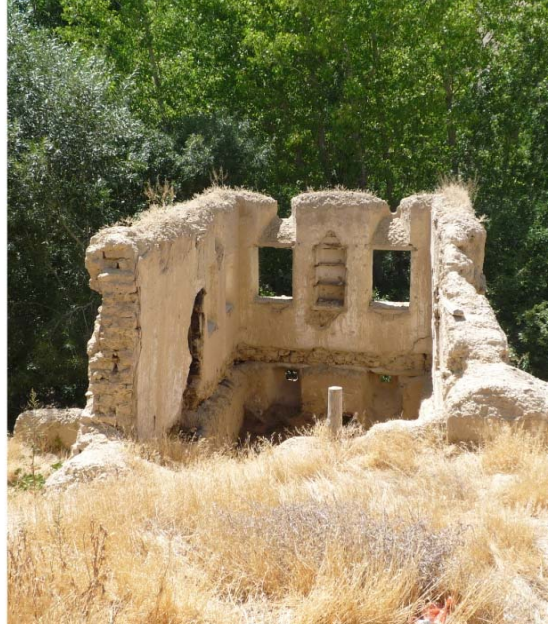
Şekil 11. Solda Suyun Kerpiç Duvarlarda Neden Olduğu Hasarlar (Feilden, 1994); Sağda Malatya Darende’de Üst Örtüsü Yıkılmış ve Doğal Bozulmaya Açık Geleneksel Kerpiç Bir Yapıda Bozulma
