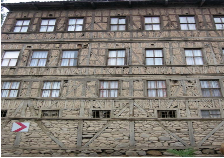
Şekil 8. Orhangazi Sölöz'de Taş ve Kerpiç Dolgulu Ahşap Karkas-Çatki Sistem (Hımiş) Geleneksel Bir Konut
