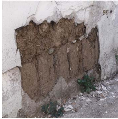
Şekil 20a, 20b. 1950'de Yapılan Altınova-Petek Çiftliği'ndeki Kerpiç Ev ve Sıvası Dökülen Yerden Görülen Kerpiç Duvar Detayı, Ağustos 2010 (Fotoğraf: A. Ersoy)
