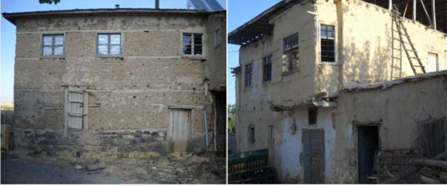
Şekil 13a, 13b. 2010 Elazığ Depreminde Yıkılan Evlerin Hemen Yakınında Yıkılmayan Evlerden İki Örnek (Fotoğraf: B. Büyükyıldırım)
