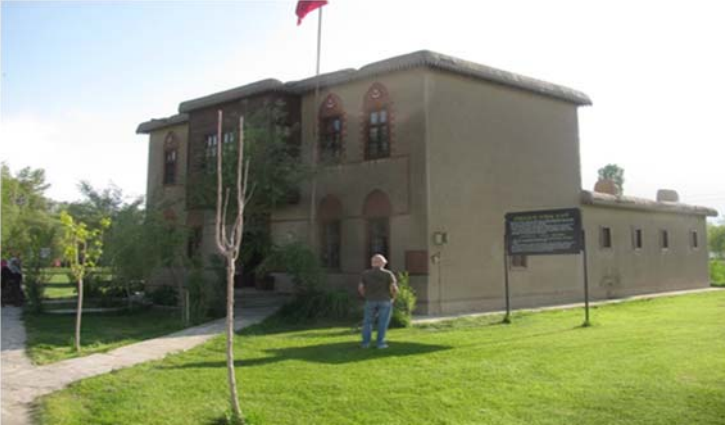
Şekil 14. 2011 Van Depreminde Yıkılmayan Eski Van Evi Örneği (Fotoğraf: A. Kafescioğlu)
