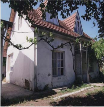
Şekil 20a, 20b. 1950'de Yapılan Altınova-Petek Çiftliği'ndeki Kerpiç Ev ve Sıvası Dökülen Yerden Görülen Kerpiç Duvar Detayı, Ağustos 2010 (Fotoğraf: A. Ersoy)
