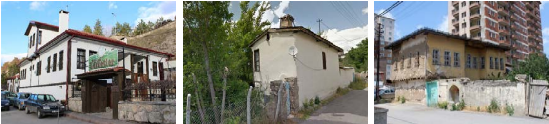
Şekil 6. Sivas geleneksel konutların sokak-cephe ilişkisi (Gülhayat Kılıcı)
