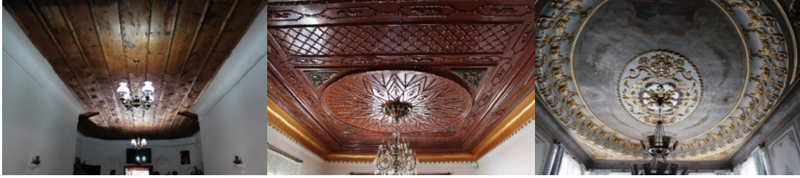
Şekil 16: Sivas konutlarında tavan kaplaması örnekleri sırasıyla: çitalı ahşap tavan, göbekli ahşap oyma tavan ve alçı kaplama tavan (Gülhayat Kılıcı)
