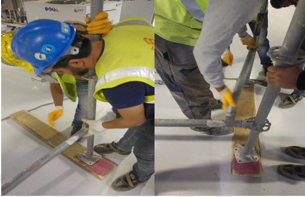
Şekil 12: Kısa ve uzun yatay elemanların bağlantısı
