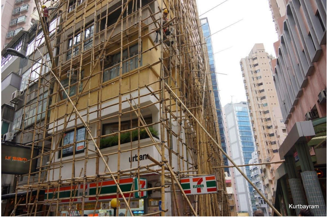
Şekil 1: Hong Kong' da dış cephede kullanılmak üzere bambudan yapılmış iskele [1]
