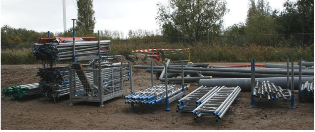
Şekil 5: İskele malzemelerinin cins ve ebatlarına göre uygun olarak istiflenmesi
