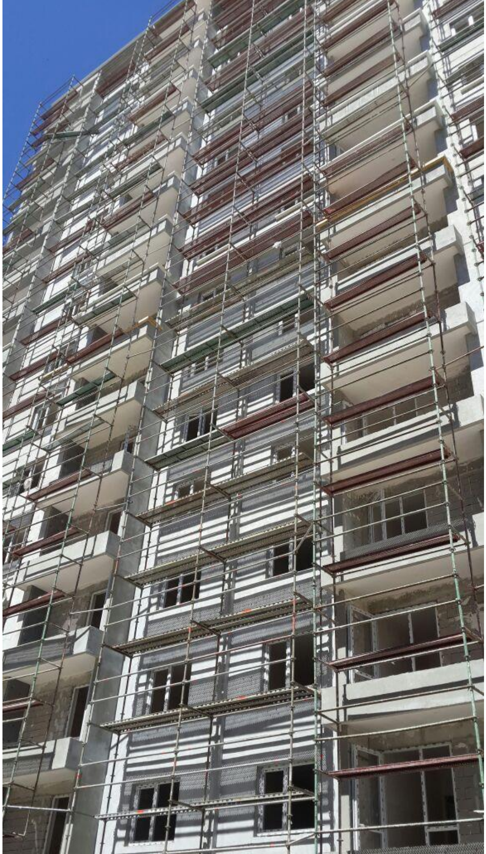
Şekil 27: Konut projesinde çalışma yapılan örnek iskele
