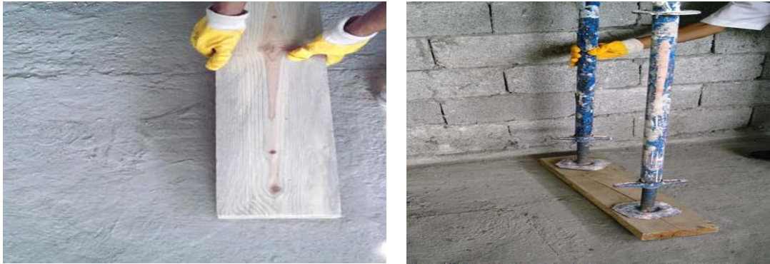
Şekil 25: Taban ayar vidaları ve dikmelerin yerleştirilmesi.
