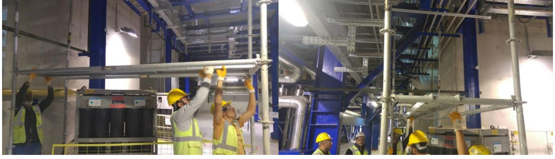
Şekil 14: Üst kat yürüme bantlarının yerleştirilmesi
