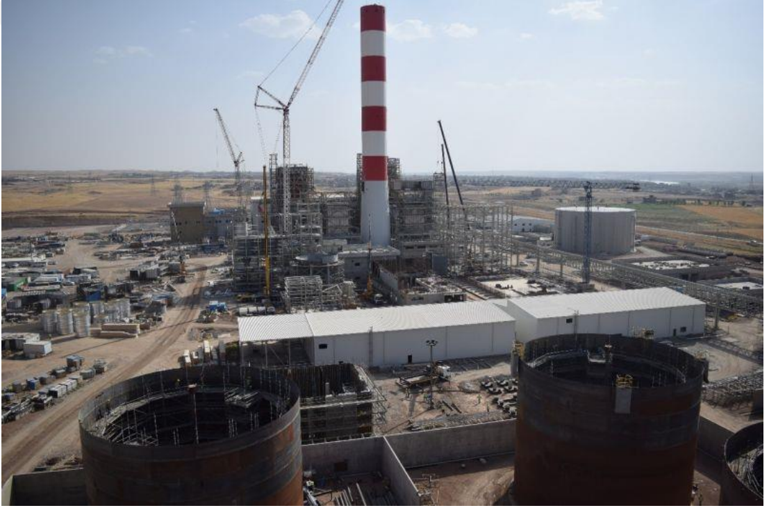
Şekil 28: 2x150 MW Khabat termik santrali şantiyesi.
