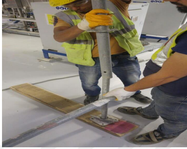
Şekil 11: Taban plakası, taban ayar mili ve başlangıç elemanının yerleştirilmesi
