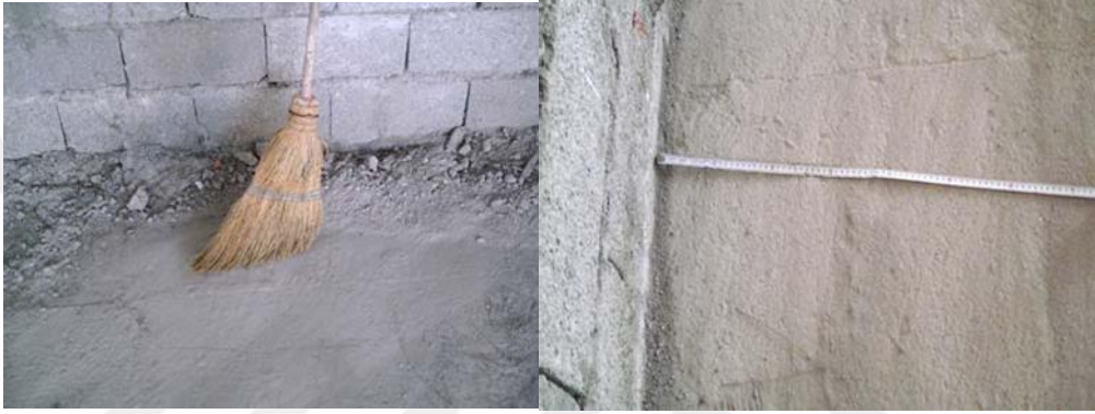
Şekil 24: İskelenin kurulacağı zeminin temizlenmesi ve mesafe ölçümü.
