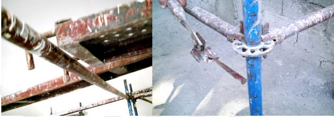
Şekil 26: İskele yatay bağlantıları ve metal kalasların yerleştirilmesi.
