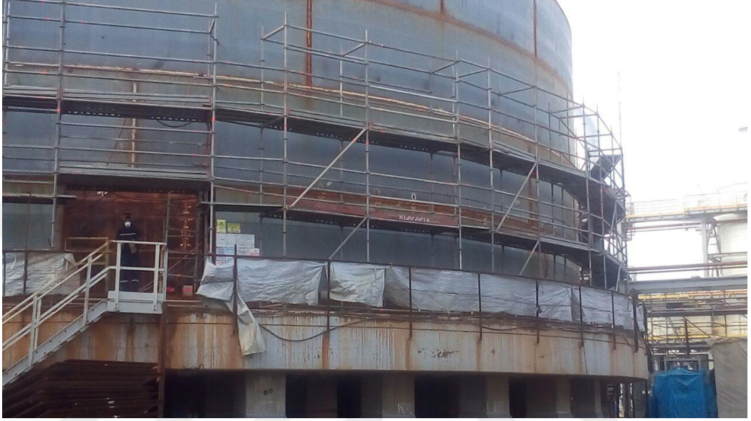
Őekil 21: Sahada kurulumu devam eden iskele.
