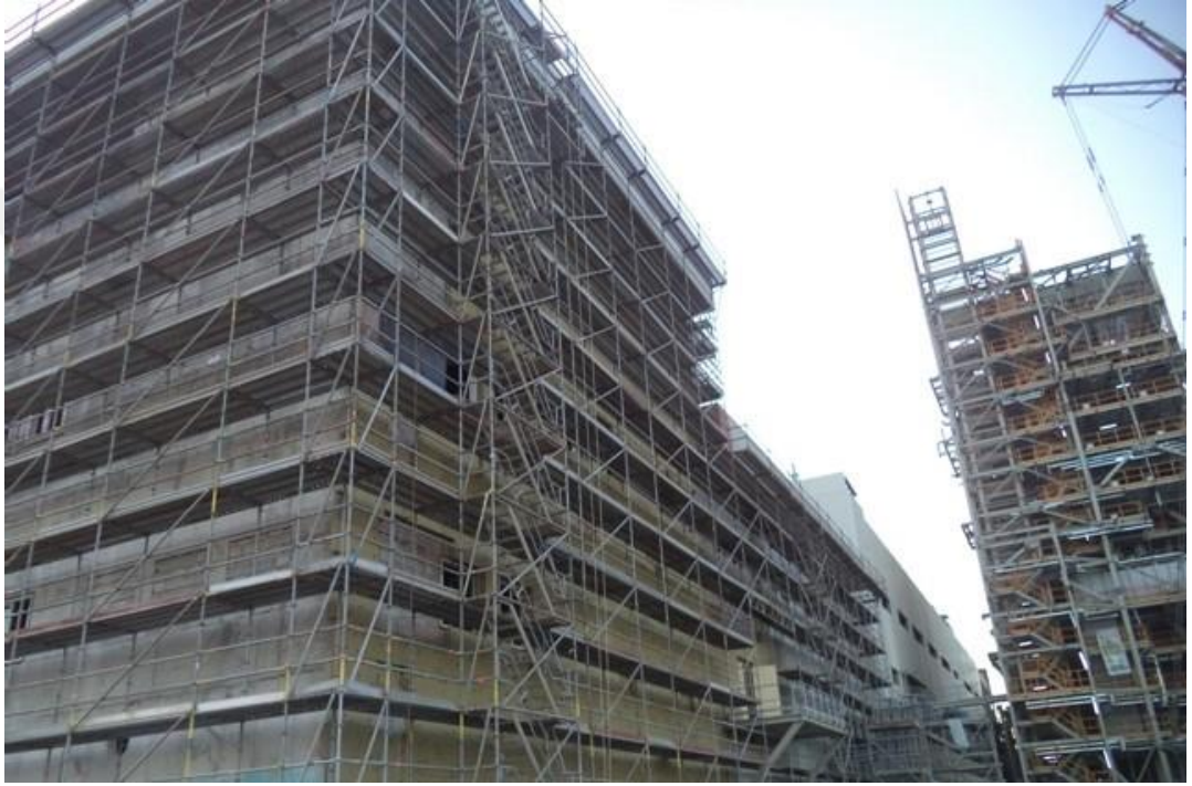
Şekil 29: Şantiye alanında kurulmuş olan örnek iskele
