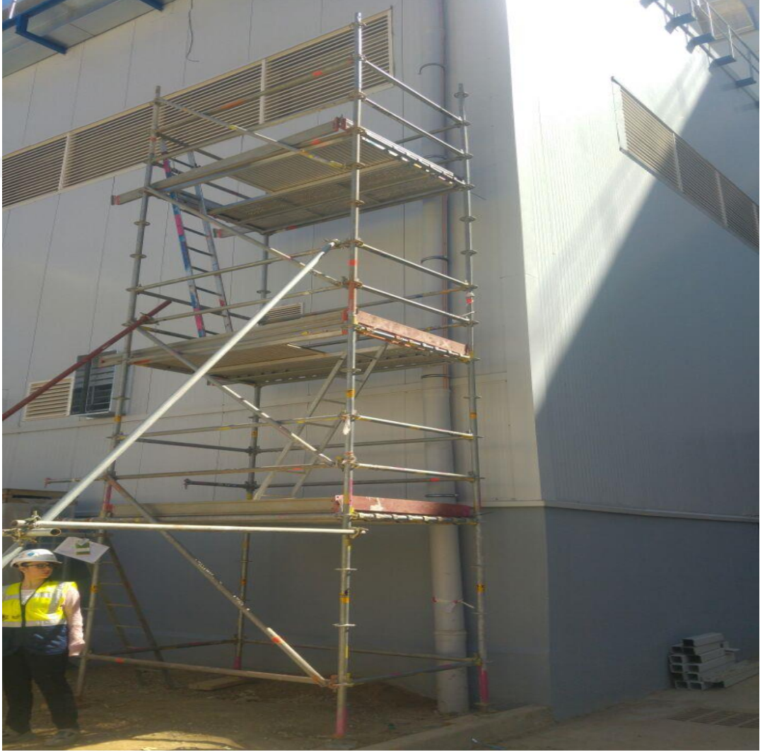
Şekil 17: Şantiye içerisinde kurulmuş örnek iskele
