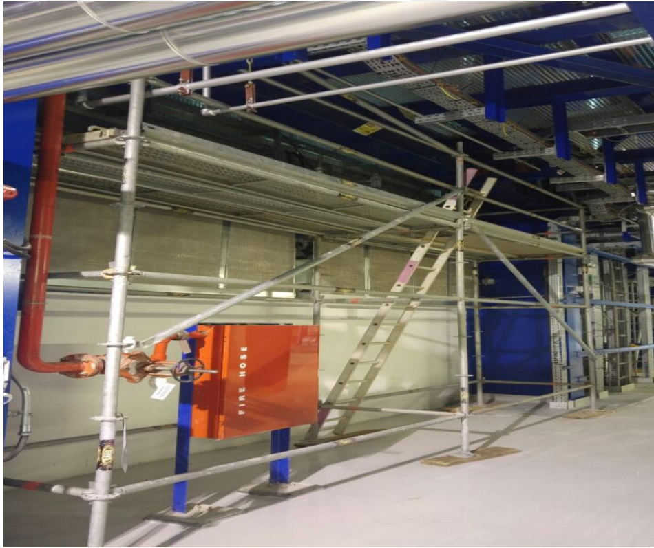
Şekil 15: Tamamlanan iskele örneği
