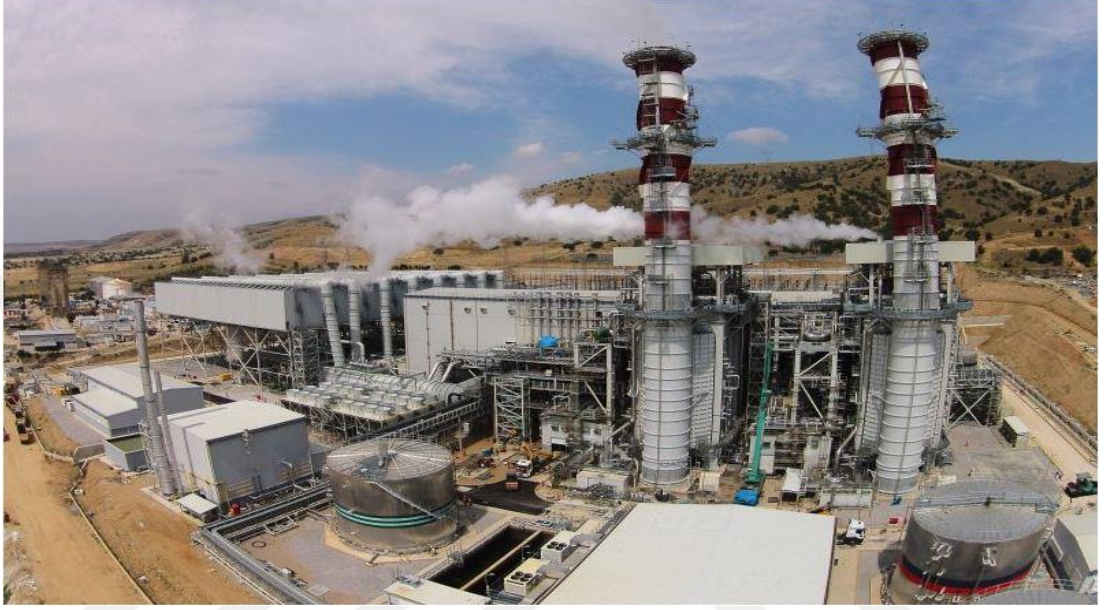
Şekil 8: İç Anadolu Doğalgaz Kombine Çevrim Santrali
