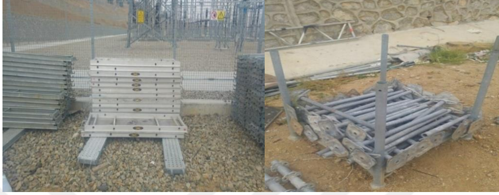
Şekil 9: Malzeme depo alanı
