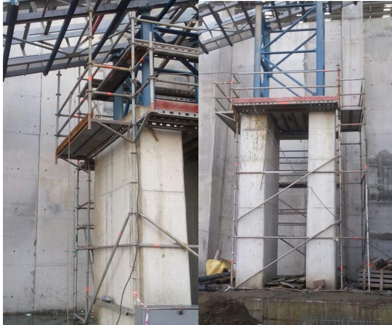
Őekil 22: Sahada kurulumu tamamlanmıř iskele.
