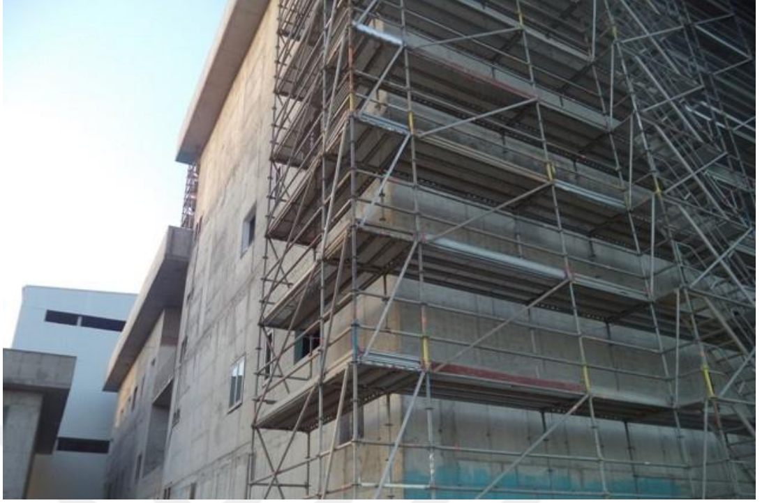
Şekil 30: Şantiye alanında kurulmuş olan örnek iskele
