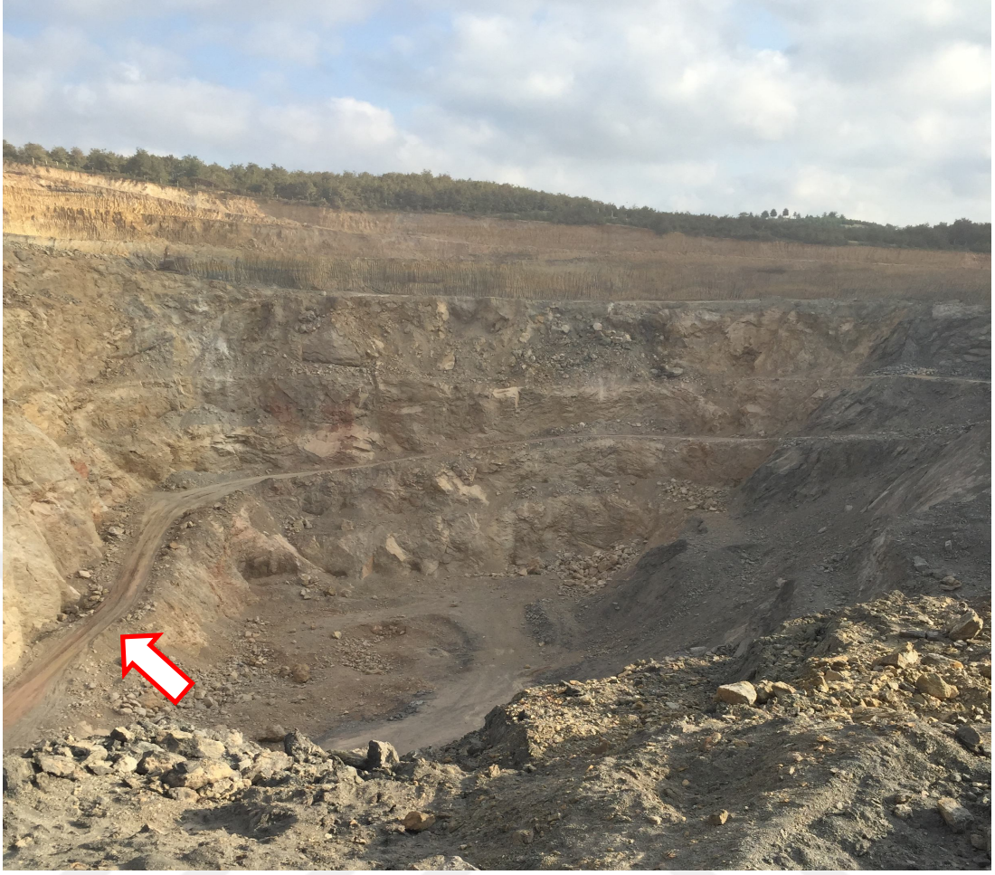
Şekil-20: Uygun olmayan basamak genişliği
