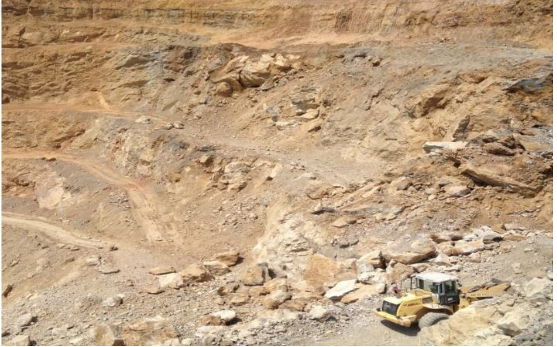
Şekil-15: Ekskavatör temizleme çalışması
