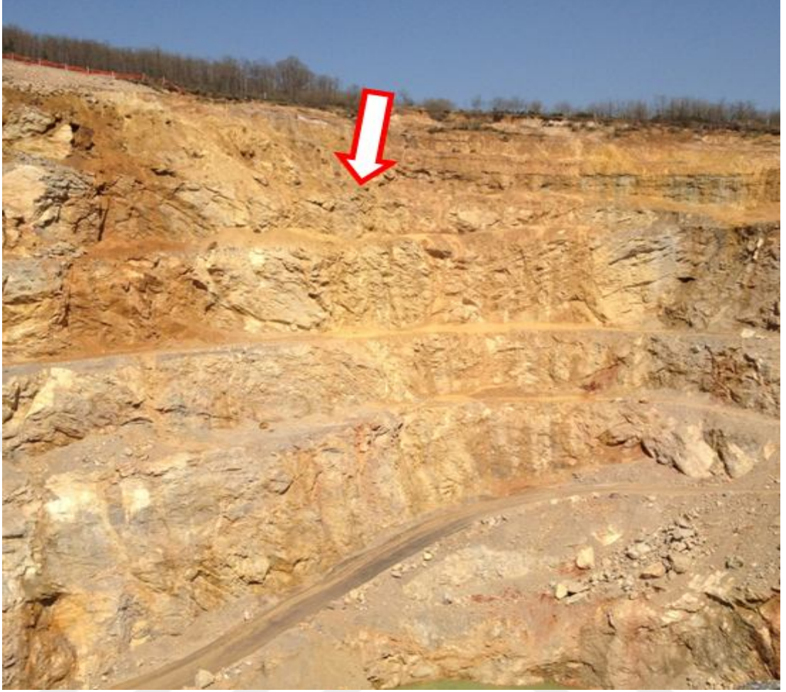
Şekil-17: Uygun olmayan şev
