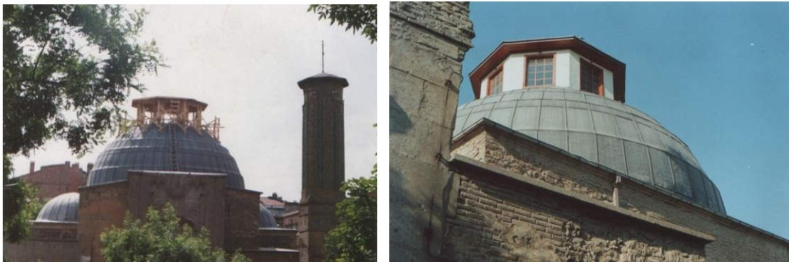
Resim 2.17. Aydınlatma feneri yapım aşaması ve sonrası (KRAM Arşivi)
