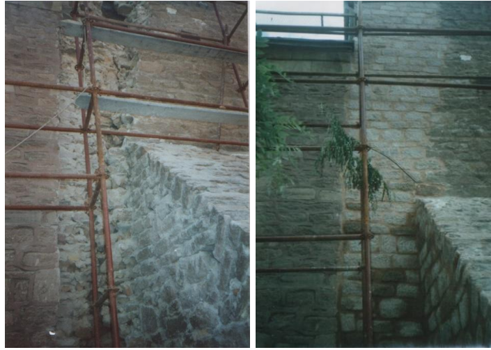
Resim 2.22. Eyvanın batı cephesindeki çatlağın horasan harçla sağlamaştırılması (KRAM Arşivi)
