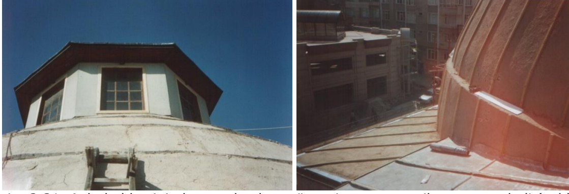
Resim 2.21. Avlu kubbesinin kurşun kaplama öncesi çamur siva ile sıvanmış hali (solda), kurşun kaplanması (sağda) (KRAM Arşivi)
