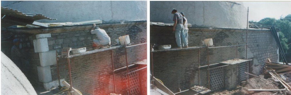
Resim 2.23. Batı ve güney cephesinde, kısmi taş ve tuğla malzemenin ve derzlerin yenilenmesi (KRAM Arşivi)
