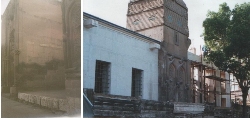
Resim 2.19. Taç kapı ile minare arasındaki mekanın onarım öncesi ve sonrası durumu (KRAM Arşivi)
