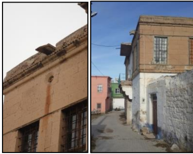
Resim 6. Geleneksel Niğde Evleri'nde Düz Dam Ve Taş Çörten Detayı
