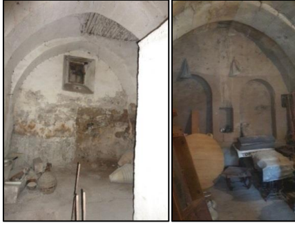
Resim 13. Üzeri Tonozla Örtülen Zemin Kat
