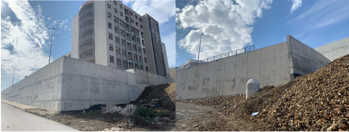
Şekil 12. İstinat Duvarının Uygulanmış Görünüşü
