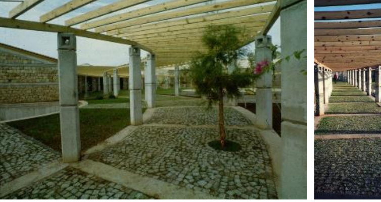
Şekil 3. Pergolalar ve Prefabrik Brüt Beton Kolonlar
