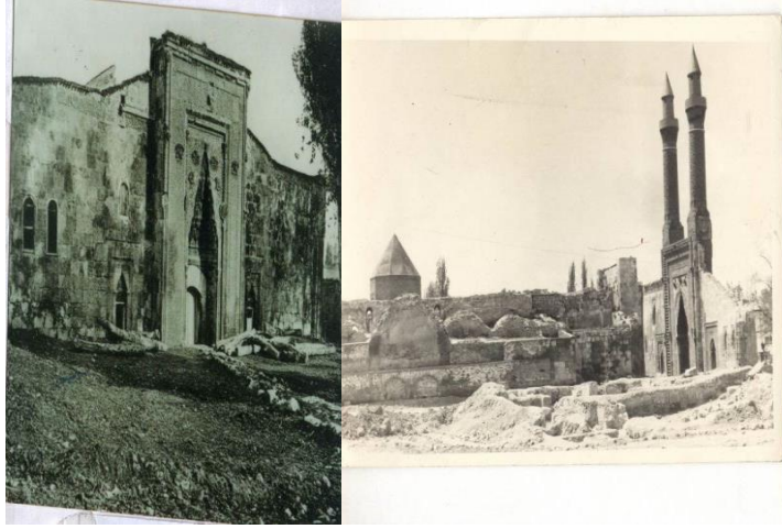
Resim 3.2. 192.Sivas Park alanı içerisinde bulunan Buruciye Medresesi, Çifte Minareli Medrese ile Keykavus Şifahanesi ve kalıntılar (web kaynak 4)
