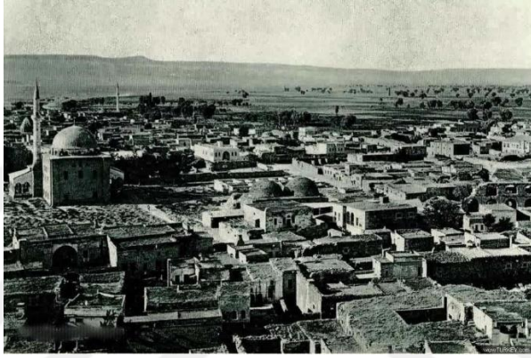
Resim 3.2. 150.Kayseri Kurşunlu Cami ve Çevresi, park yapılmadan önce eski evlerin bulunduğu alanlar (Web kaynak 4)
