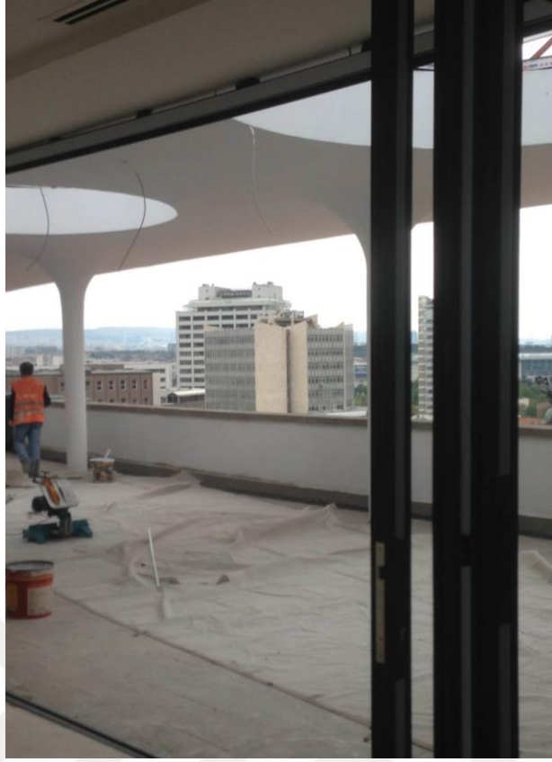
Resim 152: Restorasyon Aşaması, 5. kat (Şen, A. 2019)
