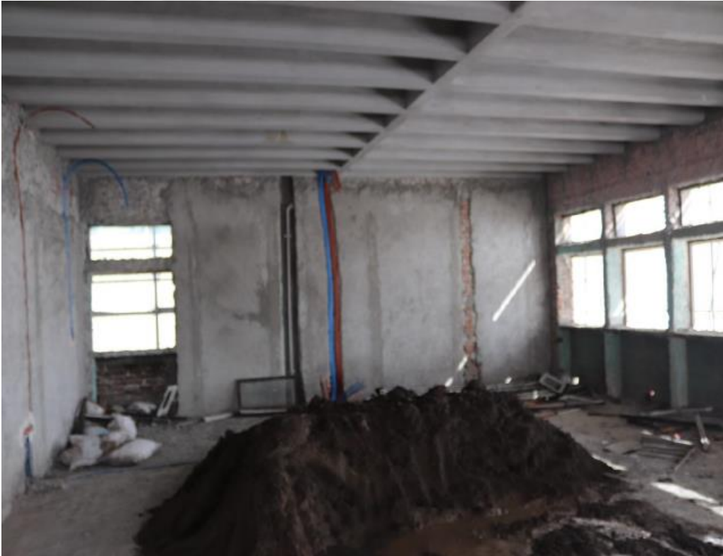
Resim 149: Restorasyon Aşaması, 5. kat (Şen, A. 2019)
