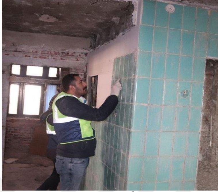
Resim 113: Restorasyon Aşaması Raspa İşlemi, 2. Kat (Şen, A. 2019)
