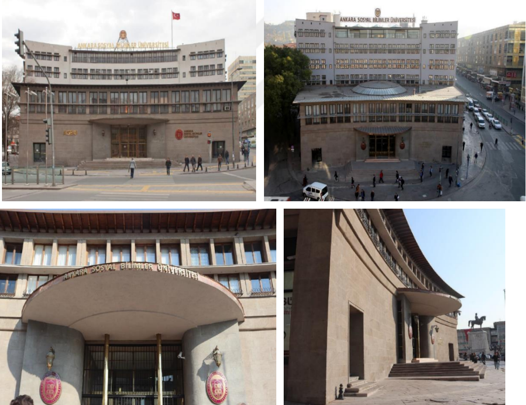
Resim 63: Batı Cephesi (Şen, A. 2019)
