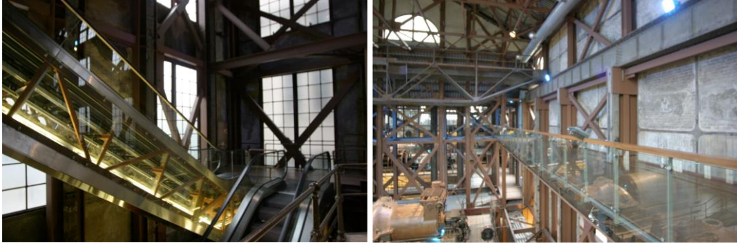
Resim 27: Yenilemede eklenen yürüyen merdivenler ve seyir platformu (Yapı, 2007)
