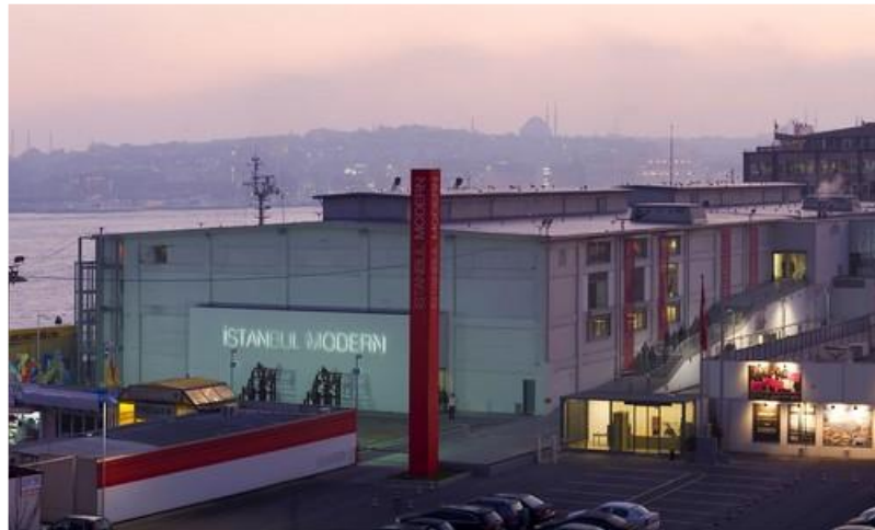
Resim 28: İstanbul Modern Genel Görünüm (Yapı, 2005)
