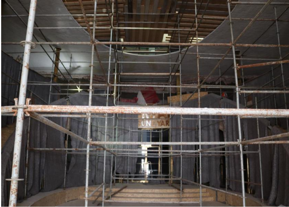
Resim 102: Restorasyon Uygulama Aşaması, Zemin Kat (Şen, A. 2019)
