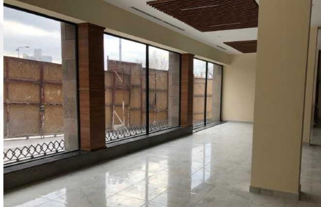
Resim 100: Restorasyon Ařaması ve Sonrası, Zemin Kat (řen, A. 2019)
