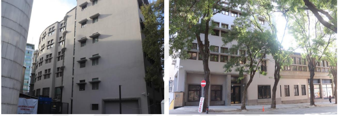
Resim 64: Doğu Cephesi ve Kuzey Cephesi (Şen, A. 2019)
