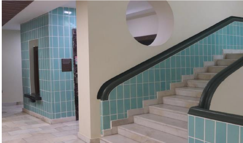
Resim 112: Restorasyon Öncesi ve Sonrası, 2. Kat (Şen, A. 2019)
