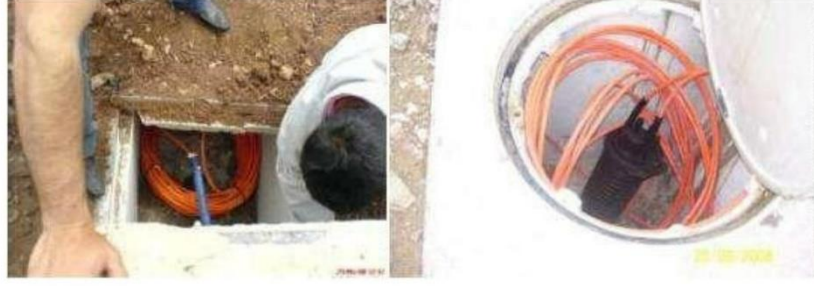
Őekil 13. Laka Teknięi ile Kablo ekimi
