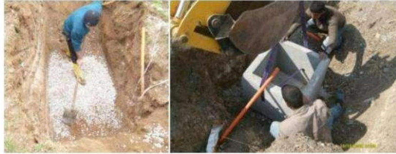
Şekil 10. Menhol Yerleştirilmesi
