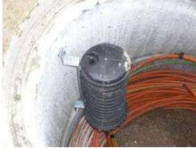
Şekil 14. Menholde Ek Kutu Montajı
