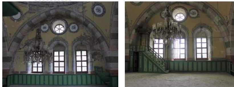
Şekil 3.12.11. Han Camisi Doğu ve Batı Cephesi Görünüşleri ile harimin doğusu ve batısından görünümü. Çizimler UMK Mimarlık ve Restorasyon'a, fotoğraflar yazara aittir.
