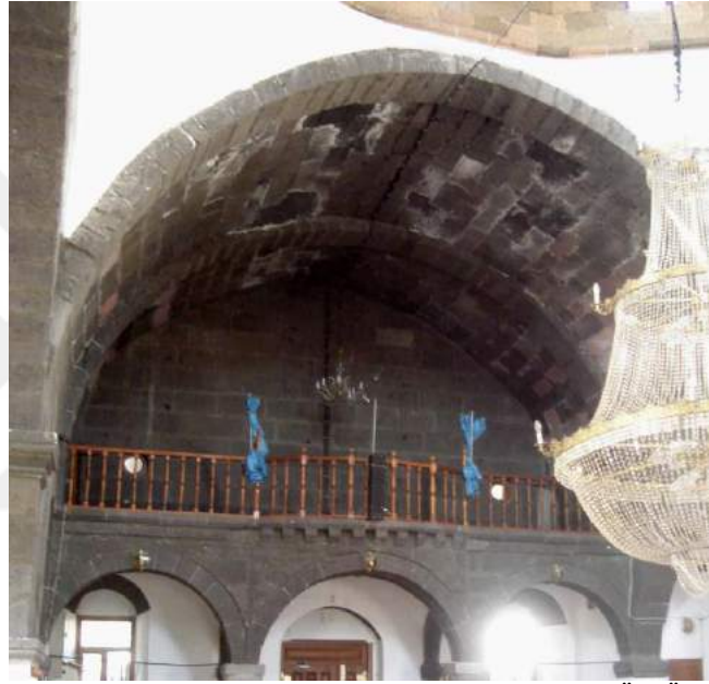
Şekil 3.14.9. Tomarza Merkez Camisi Harim Girişinin Üst Örtüsü. Kaynak: (Solak, 2013, s. 469)
