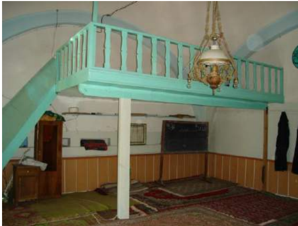
Şekil 3.7.10. Gesi Orta Mahalle Camisi Mahfili. Kaynak: (Solak, 2013, s. 407)
