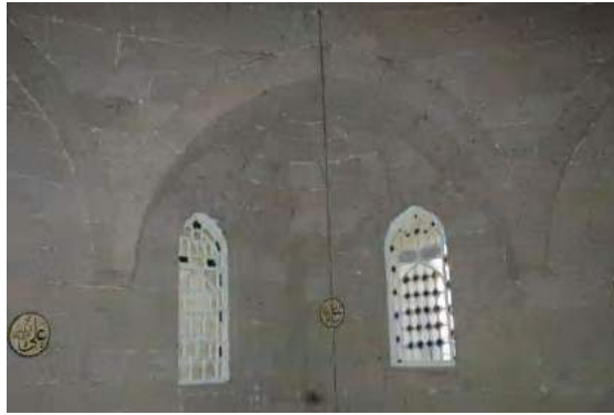
Şekil 3.5.16. Merzifonlu Kara Mustafa Paşa Camisi kubbeye geçişi sağlayan tromplar. Kaynak: (Bozkurt, 2013, s. 186)
