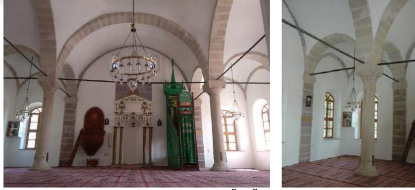
Şekil 3.13.15. Aziziye Camisi Tonozlu Üst Örtüsü ve Küçük Kubbeleri. Kaynak: (Gündoğan, 2015, s. 177-178)
