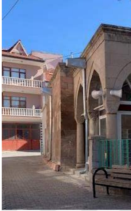
Şekil 3.3.5. Daniş Ali Bey (Büyük Bürüngüz) Camisi Kuzey Cephesi. Fotoğraf yazara aittir.
