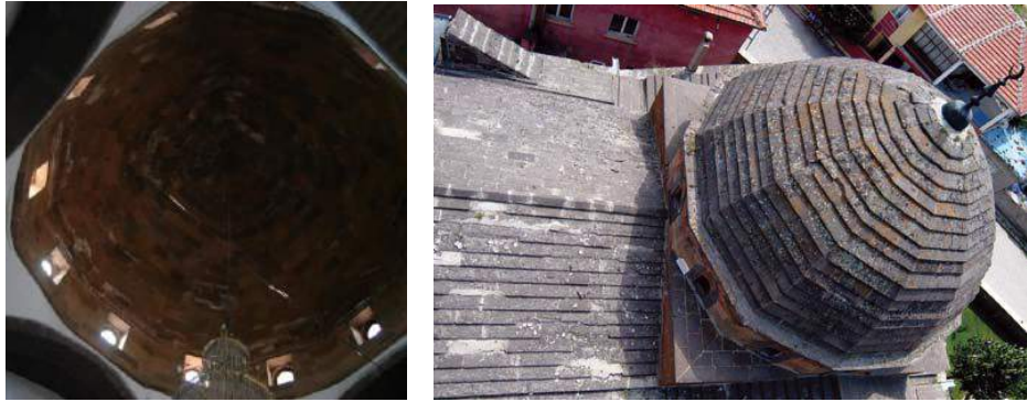
Şekil 3.14.10. Tomarza Merkez Camisi Kubbesi. Soldaki fotoğraf: (Solak, 2013, s. 468), sağdaki fotoğraf: (Özbek, 2011a, s. 60)
