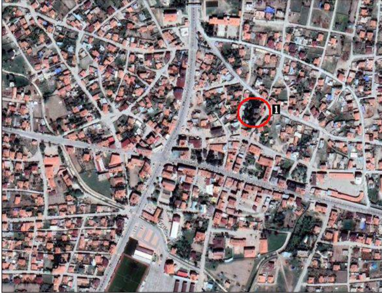
Numaralandırma: 1-Tomarza Merkez Camisi (1906). Kaynak: (Google Earth, 12.01.2021)
