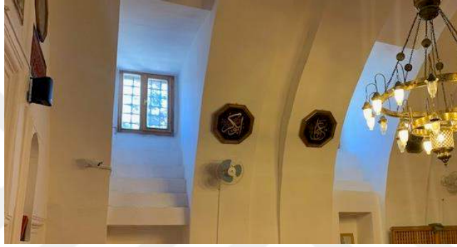
Şekil 3.3.8. Daniş Ali Bey (Büyük Bürüngüz) Camisi 2. bölümün pencere merdivenleri. Fotoğraf yazara aittir.
