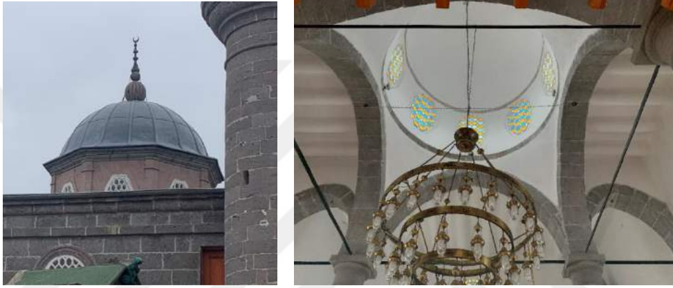
Şekil 3.9.13. Ali Saip Paşa Camisi Kubbesi. Fotoğraflar yazara aittir.
