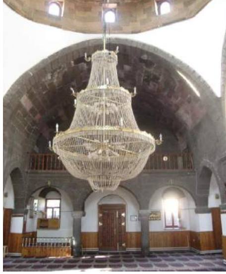
Şekil 3.14.11. Tomarza Merkez Camisi Kubbeye Geçişi Sağlayan Pandantif. Kaynak: (Solak, 2013, s. 467)
