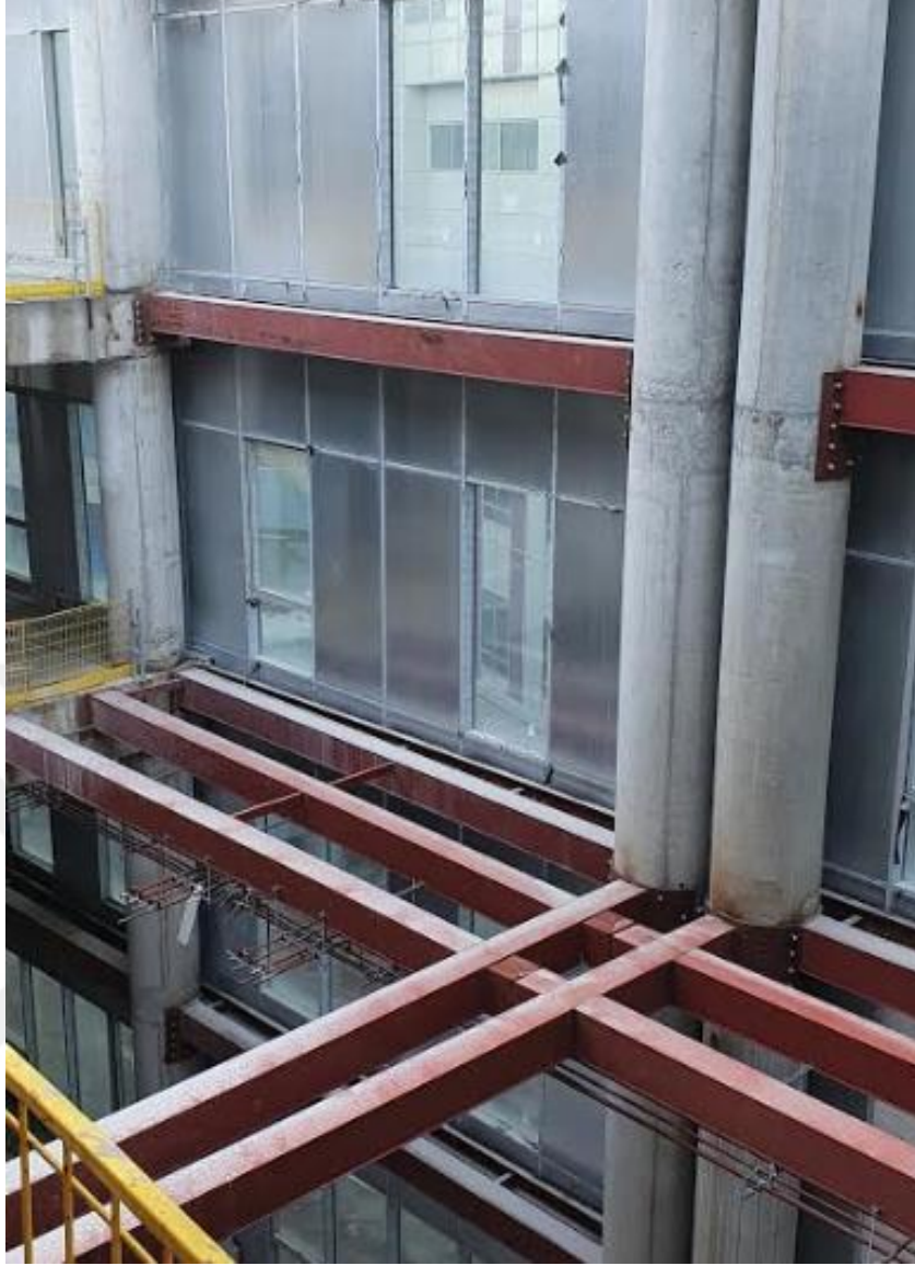
Şekil 6.25. Örnek 7 Cephe Görünümü (Kişisel Arşiv-2018)
