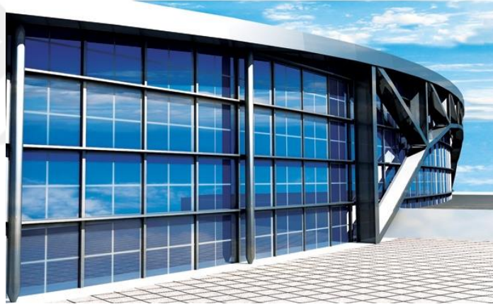
Şekil 2.10. Kapaklı Alüminyum Giydirme Cephe Sistemi Örneği (URL-7)
