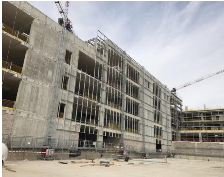
Şekil 2. 3. Çubuk Sistemde Düşey ve Yatay Profillerinin Yapıya Montajı (Kişisel Arşiv -2017)
