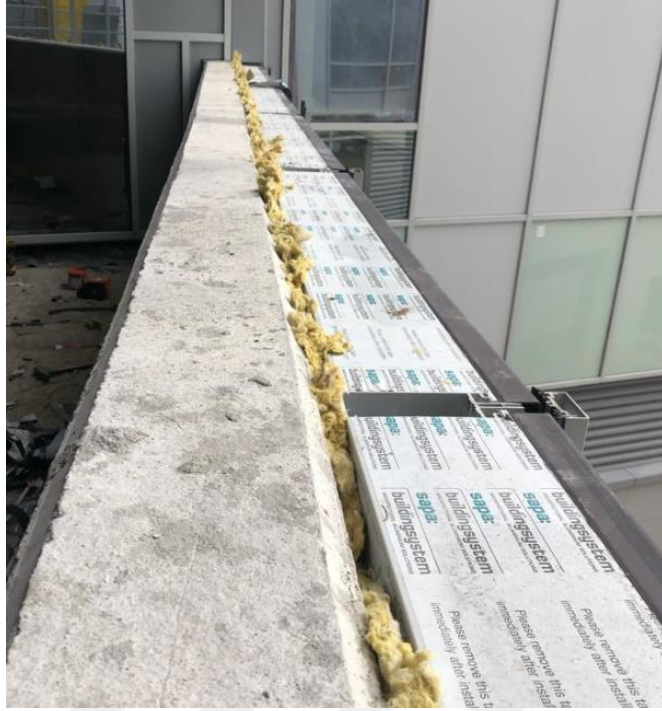
Şekil 5.43. Cephe Üst Bitiş İmalatı (Kişisel Arşiv-2019)
