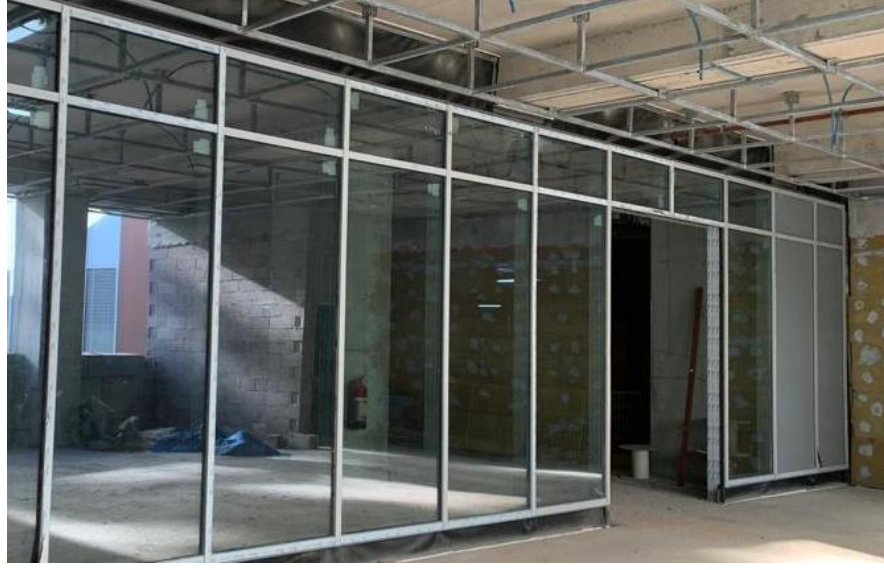
Şekil 5.41. Tamamlanmış Cephe Montajı (Kişisel Arşiv-2019)
