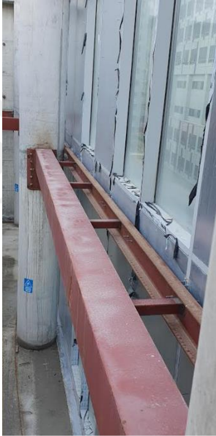
Şekil 6.28. Örnek 7 Cephe Görünümü (Kişisel Arşiv-2018)
