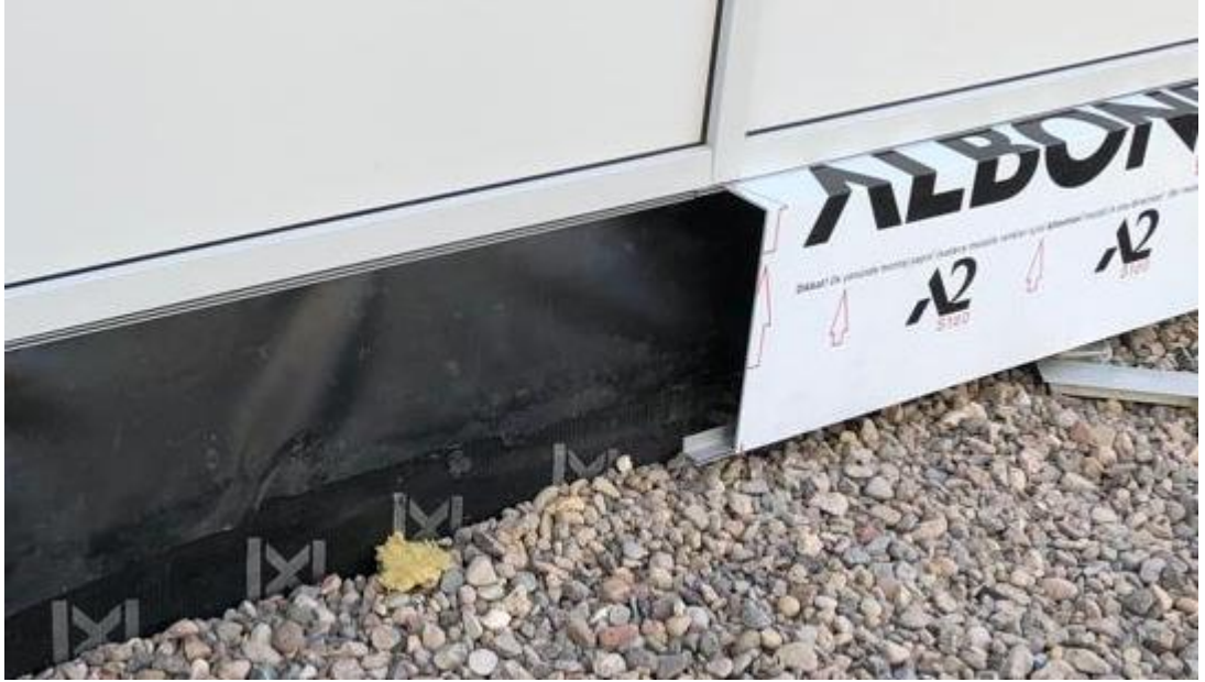
Şekil 5.42. Cephe Alt Bitiş İmalatı (Kişisel Arşiv-2019)
