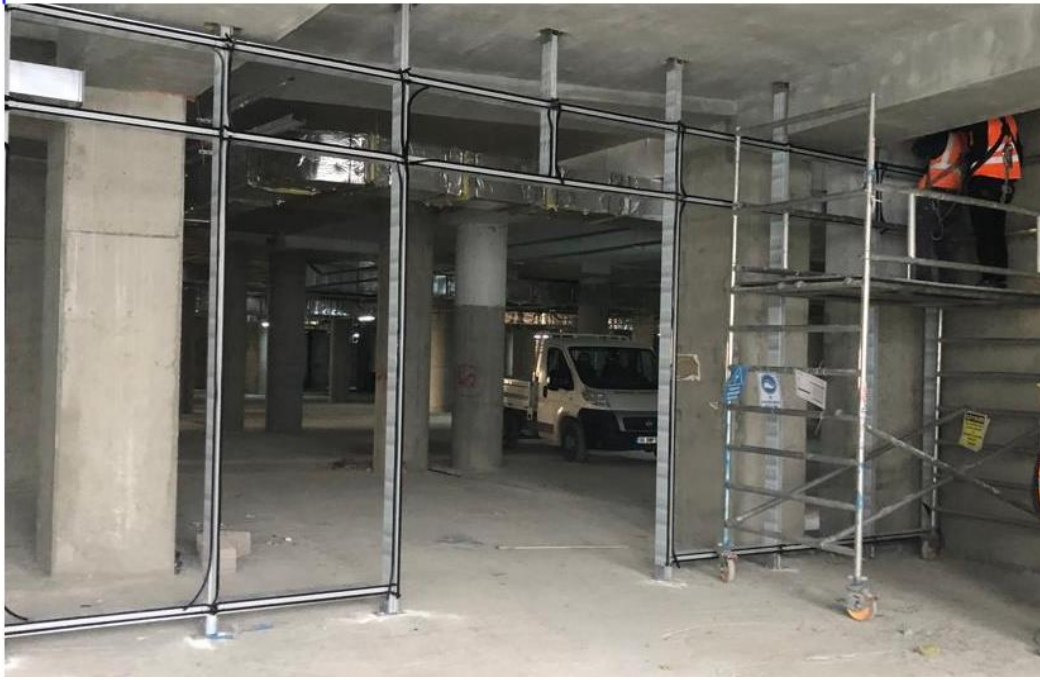
Şekil 5.38. Cephe Karkas Montajı (Kişisel Arşiv-2019)
