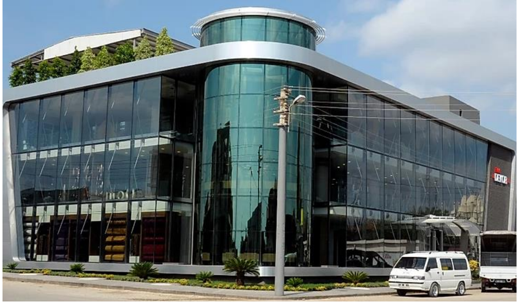
Şekil 2.12. Silikon Alüminyum Giydirmeye Cephe Sistemi Örneği (URL-9)
