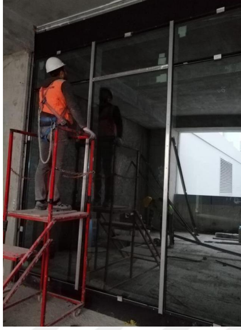
Şekil 5.39. Cephe Cam Montajı (Kişisel Arşiv-2019)
