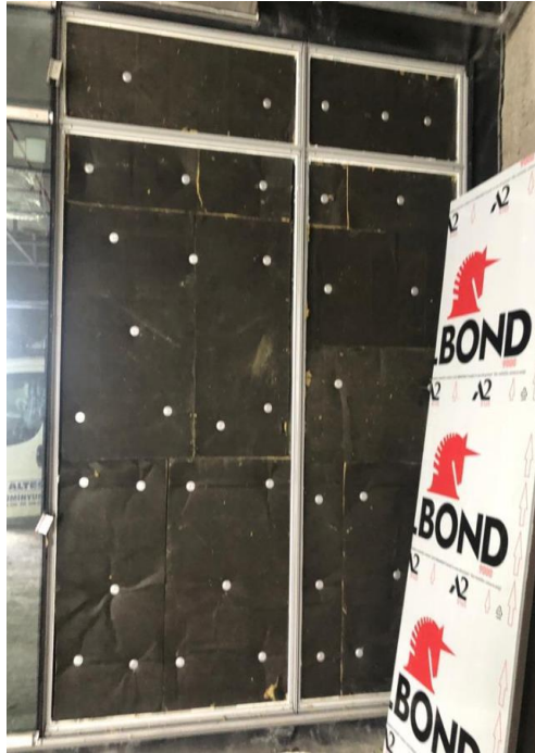
Şekil 5.40. Cephe Kompozit Montajı (Kişisel Arşiv-2019)
