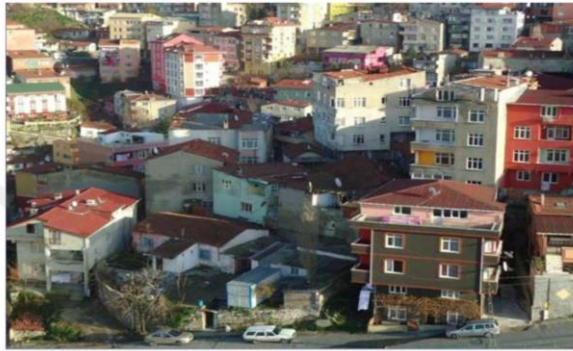
Şekil 23: Örnektepe- Sötlöce Kentsel Dönüşüm Alanının Yıkım Öncesi Görüntüsü
