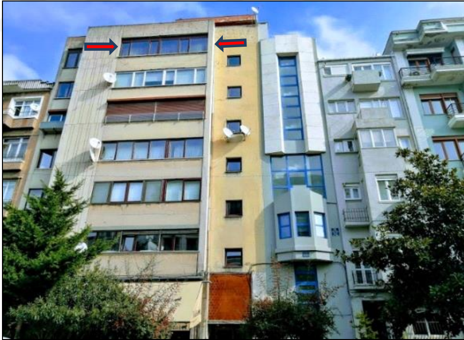
Şekil 4.62: Cihangir Ev, Apartman Dış Görünüşü, Sedat Gürel, İstanbul, 1976, Kaynak: (Fotoğraf Arşivi, Dilek Göcek, 2019)
