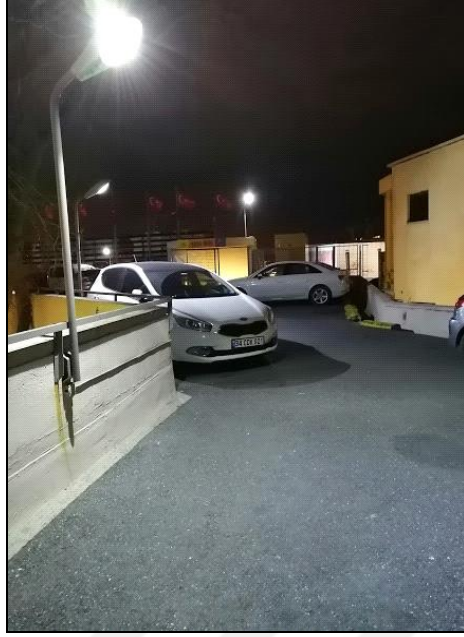
Şekil 4.84: Büyük Beşiktaş Çarşı'sı, Otopark, Sedat Gürel, İstanbul, 1977, Kaynak: (Fotoğraf Arşivi, Dilek Göcek, 2020)
