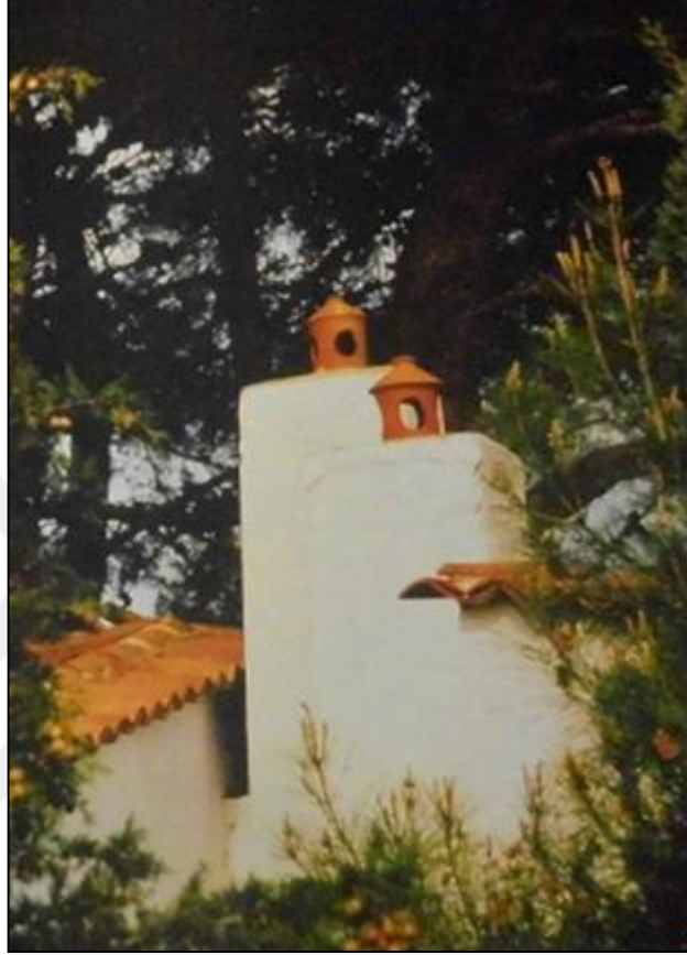
Şekil 4.38: Dalyan Köy Gürel Yazlık Ev, Çatı ve Baca Görünümü, Sedat Gürel, Çanakkale,1972, Kaynak: (Soygeniş, 2008)
