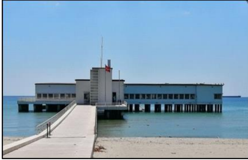
Şekil 3.9: Florya Atatürk Köşkü, Dış Cephe Görünüş, Seyfi Arıkan, Florya/İstanbul, 1935, Kaynak: (Fotoğraf Arşivi, Dilek Göcek, 2020)
