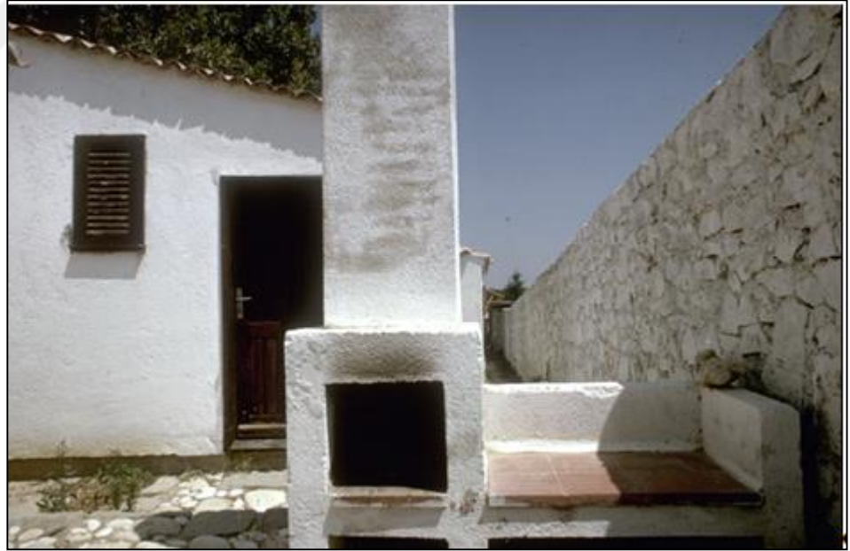
Şekil 4.46: Dalyan Köy Gürel Yazlık Ev Duvar ve Çevresi, Sedat Gürel, Çanakkale,1972, Kaynak: (Soygeniş, 2008)
