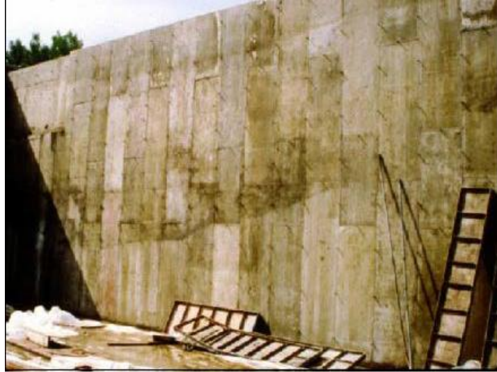
Şekil 4. 8: Soğuk derz görünümü (Engin, 2014)
