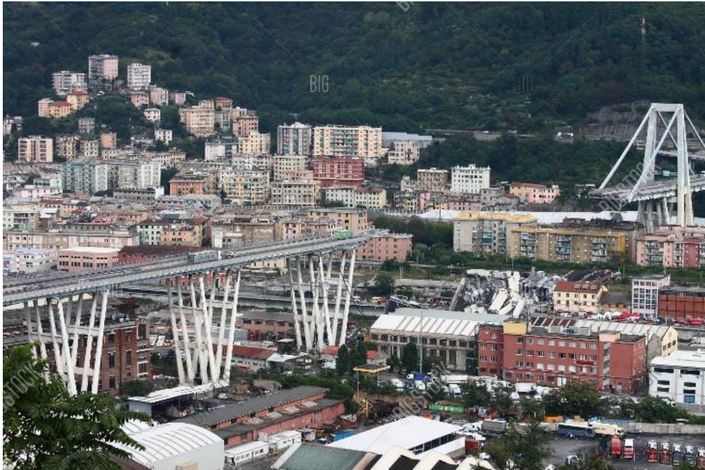
Şekil 4. 32: Yıkılan Morandi Köprüsü (url-24)
