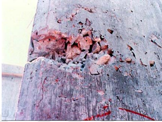
Şekil 4. 2: Petek dokusu görünümü (Akakın ve Engin, 2010)
