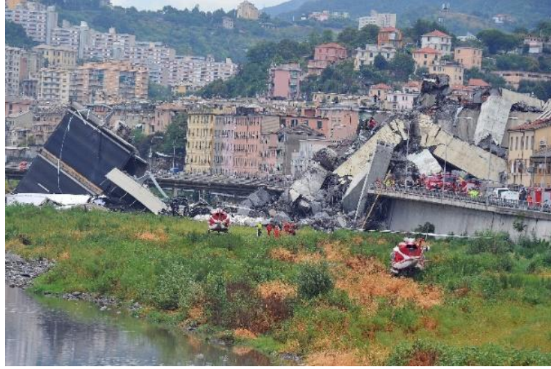
Şekil 4. 33: Yıkılan Morandi Köprüsü (url-25)
