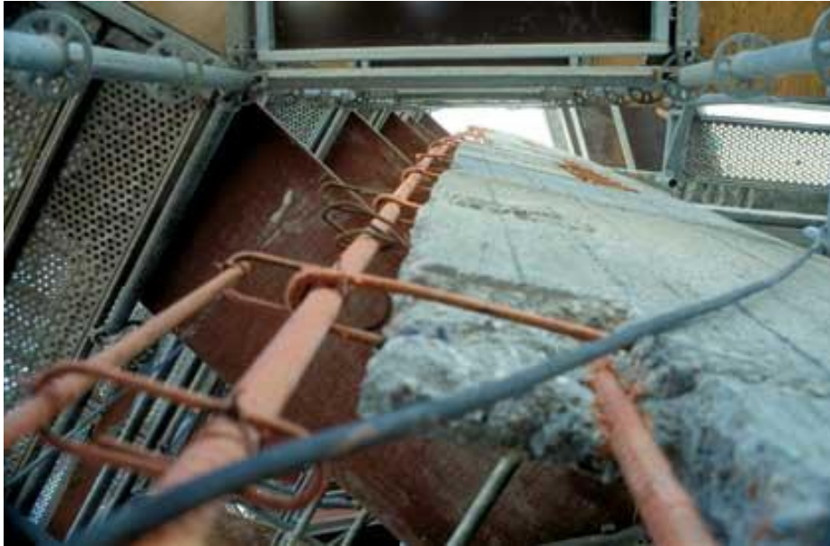
Şekil 4. 27: Strüktürde meydana gelen bozulma (Barbot, 2019)
