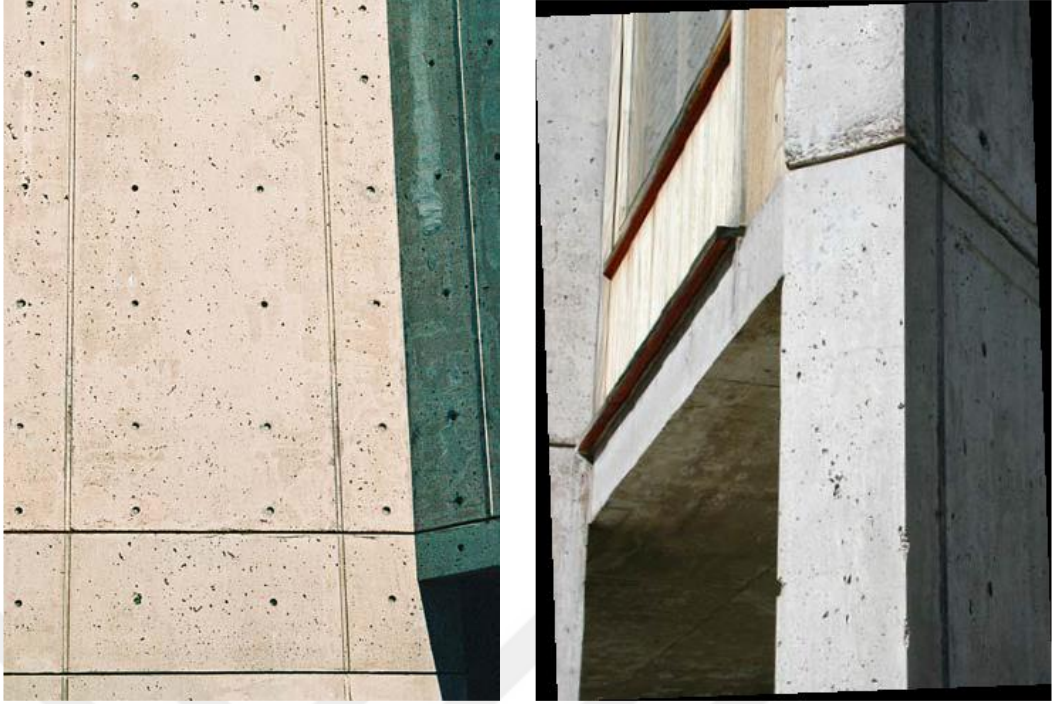
Şekil 4. 39: Yüzeylerdeki boşluklu yapılar (Loughran, 2007)
