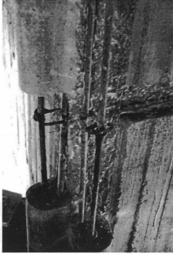
Şekil 4. 26: Strüktürde meydana gelen bozulma (Oudin, 1997)
