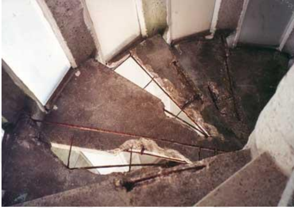
Şekil 4. 28: Merdivende ortaya çıkan bozulmalar (Barbot, 2019)
