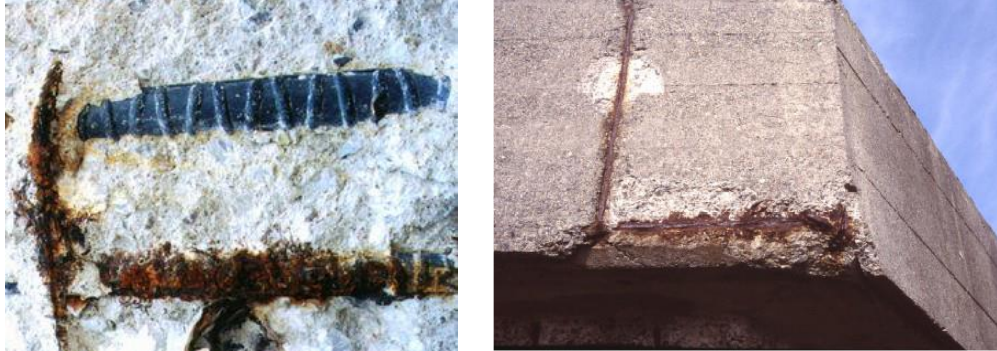
Şekil 4. 1: Karbonatlaşmanın etkisi (Engin, 2014)
