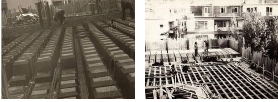
Şekil 6. 7: Türk Dil Kurumu Binası inşa aşaması (url-39)
