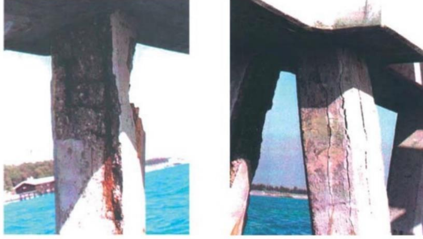
Şekil 4. 13: Oksidasyon ile yüzeylerdeki lekelenmeler (url-22)
