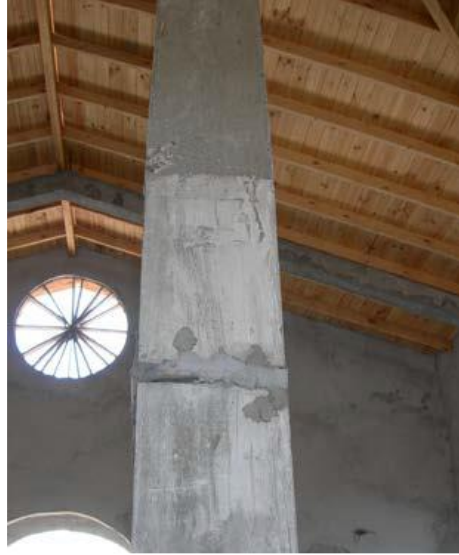
Şekil 4. 9: Soğuk derz görünümü (Engin, 2014)
