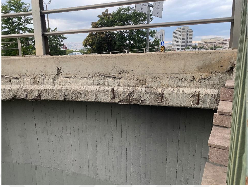
Şekil 6. 15: Yüzeydeki parça kopmaları (Okumuş, 2021)
