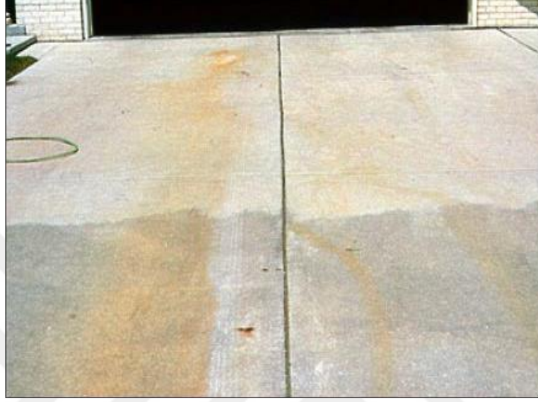
řekil 4. 6: Yüzeyde renk dzensizliđi görünümü (Akakın ve Engin, 2010)
