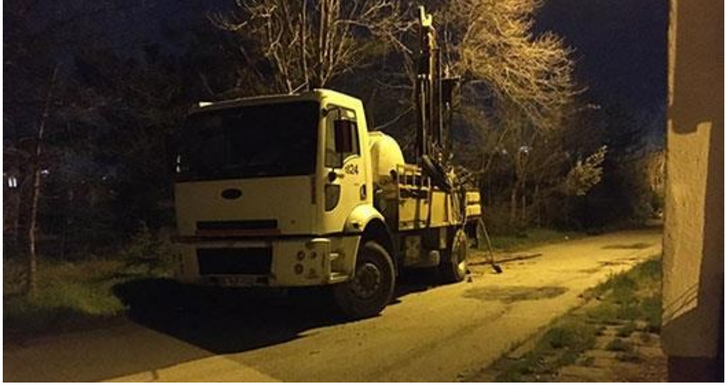
Şekil 4.18: Saraçoğlu Mahallesi'nde sondaj çalışmaları (Url-43)
