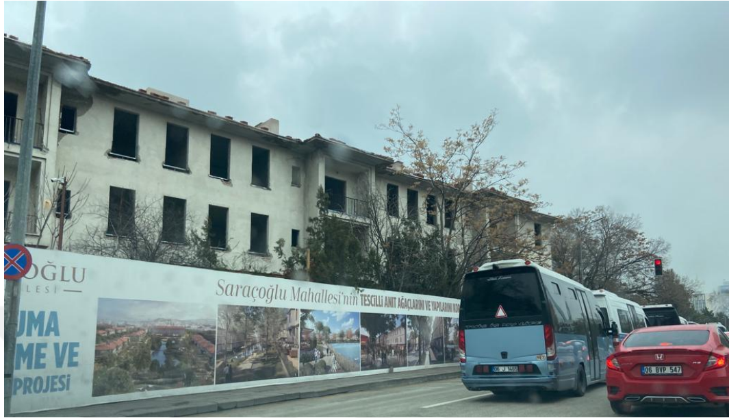
Şekil 4.33: Saraçođlu Mahallesi inşaat çalışmalarının başlaması (Enes Uçar Arşivi, Aralık 2021)
