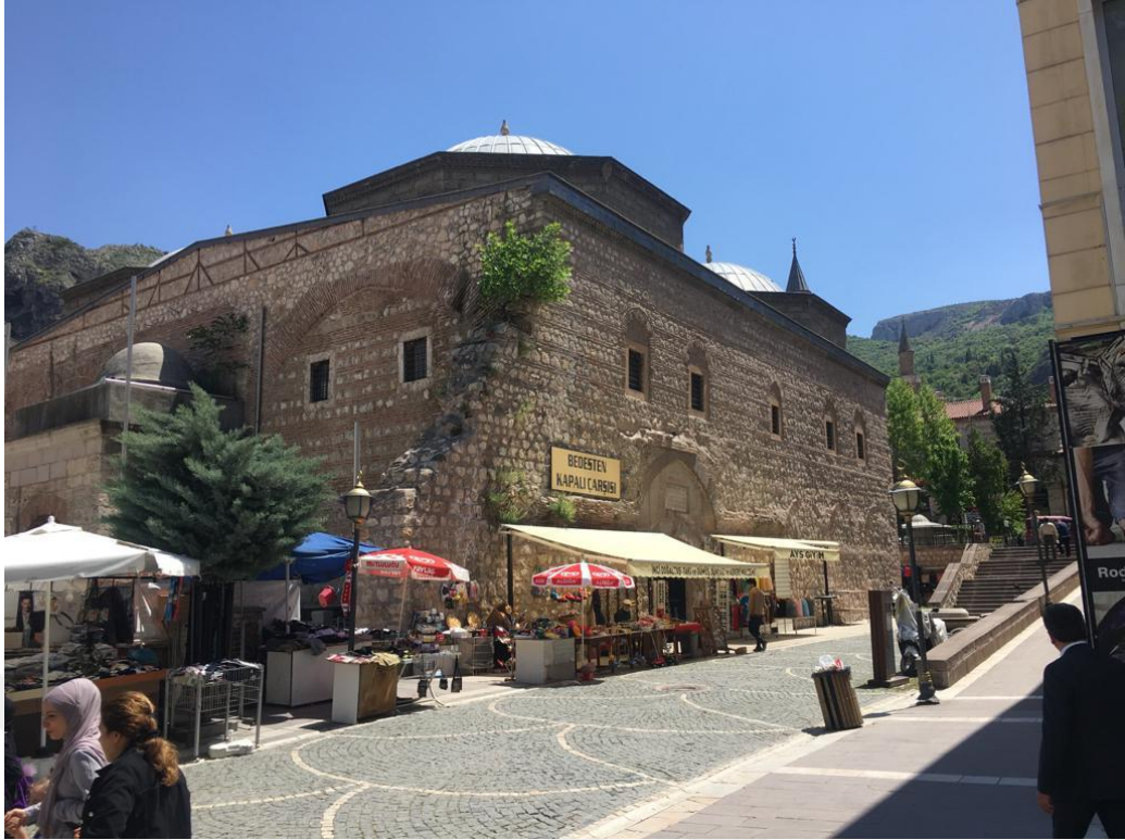
Şekil 32: 2022 yılı Bedesten çarşısı kuzey cephesi görünümü. 24
