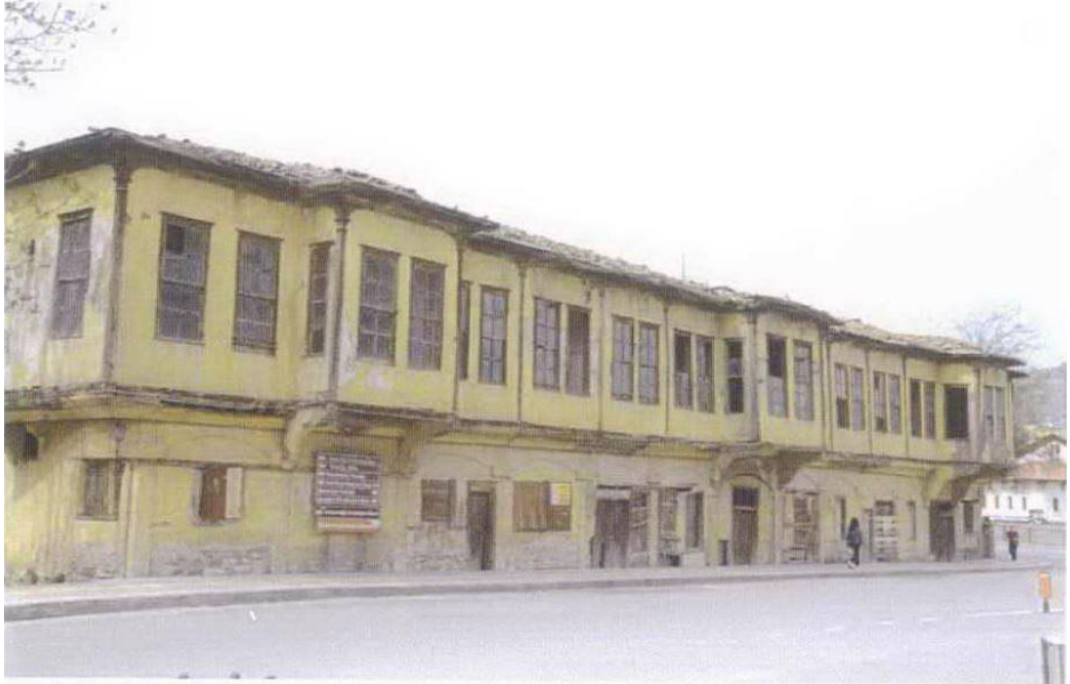
Şekil 25: 2014 yılı yapının restorasyon öncesi hali. 17 (SKVKBK, 2021)
