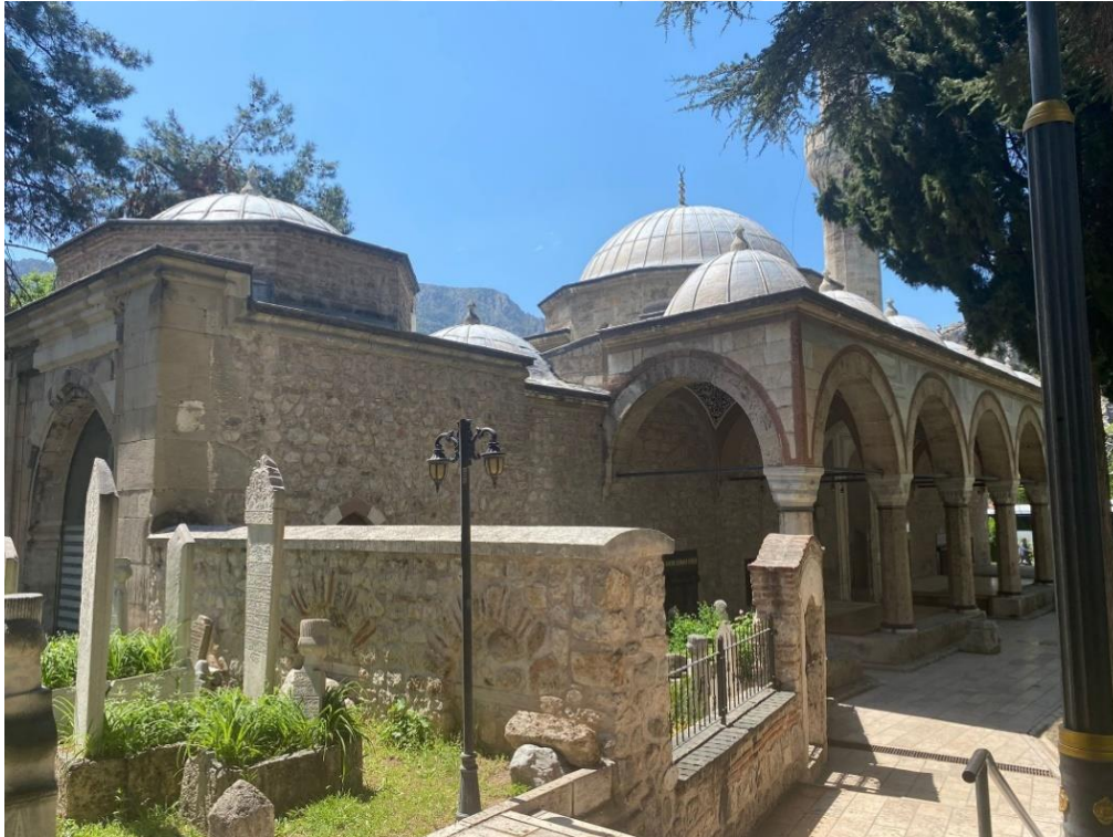
Şekil 29: 2022 yılı Mehmet Paşa Camii kuzey cephesi görünümü. 21
