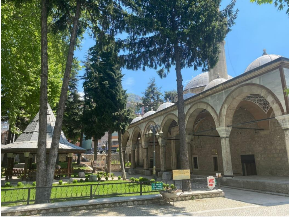
Şekil 28: 2022 yılı Mehmet Paşa Camii doğu cephesi görünümü. 20
