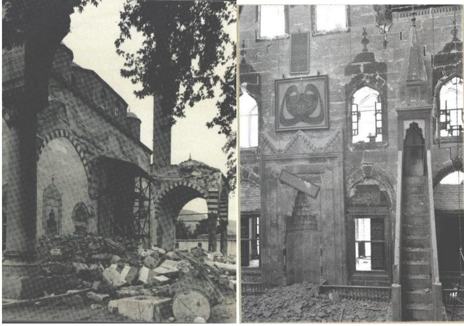
Şekil 8: 1939 yılında meydana gelen deprem sonrası Sultan Bayezit Camii (Menç,2014:220).
