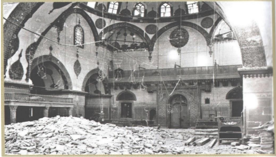
Şekil 7: 1939 yılında meydana gelen deprem sonrası Sultan Bayezid Camii iç görünümü (Menç,2014:220).
