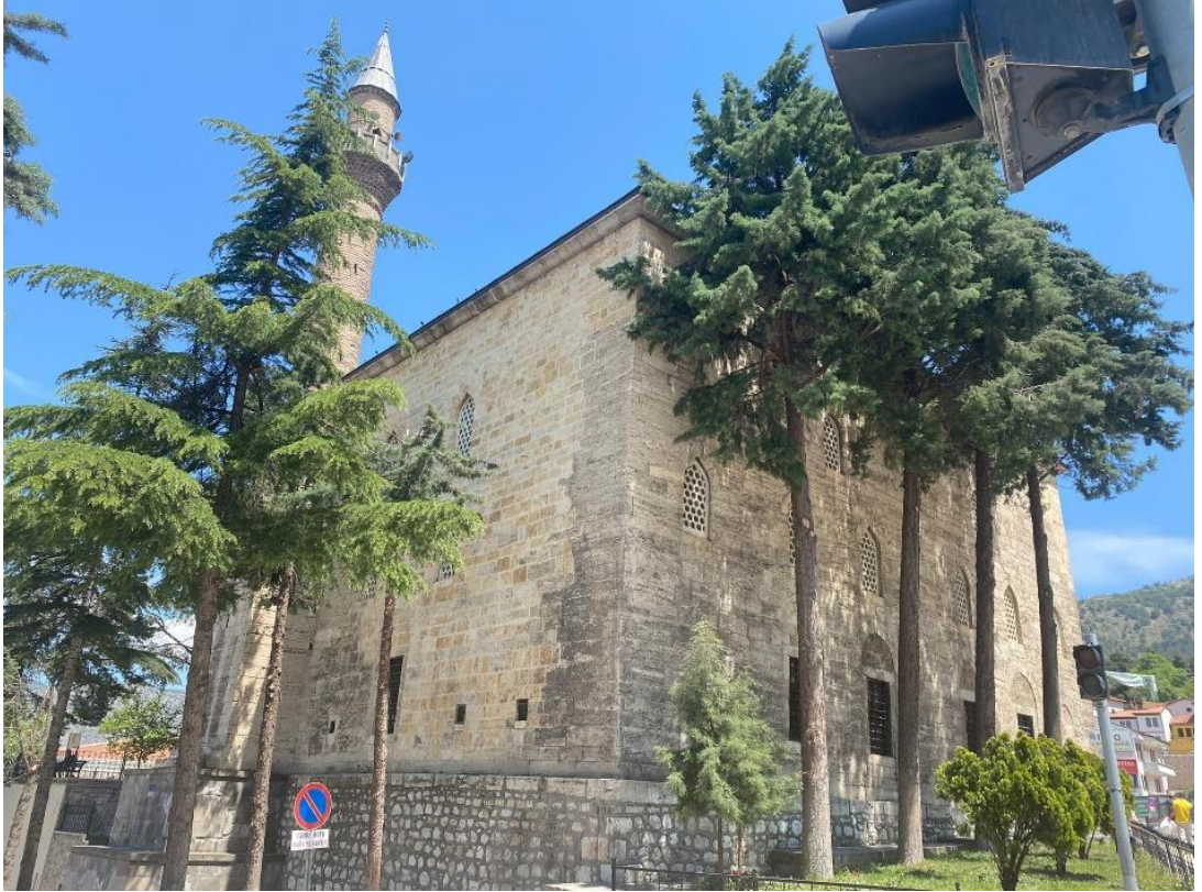
Şekil 30: 2022 yılı Gümüşlü Camii güney cephesi görünümü. 22
