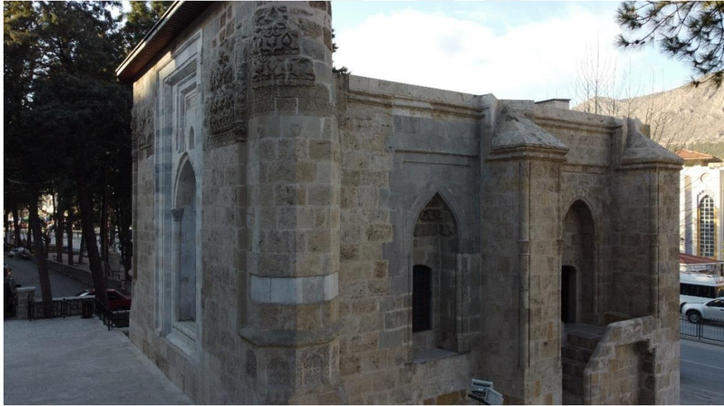
Şekil 21: Torumtay Türbesi giriş cephesi. 13
