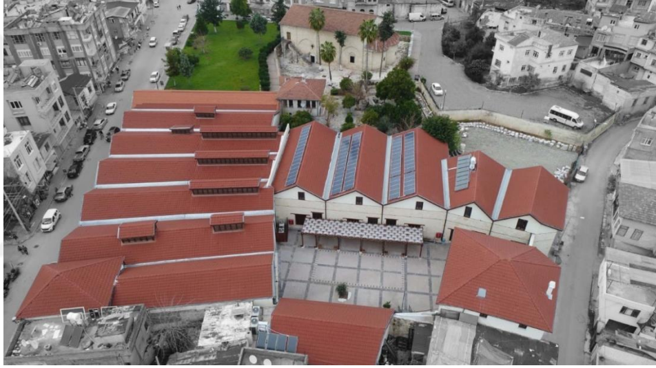
Şekil 57: Gözlükule Araştırma Merkezi Çatı Görünüşü (SAYKA Mimarlık 2022)
