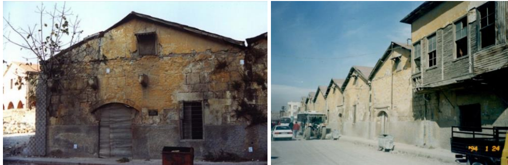
Şekil 52: Restorasyon Öncesi Cephe Durumu (Arkiv Gözlükule Kazısı Araştırma Merkezi 2022)
