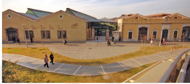
řekil 35: Konak Pier Giriř Cephesi (MATU Mimarlık 2022)
