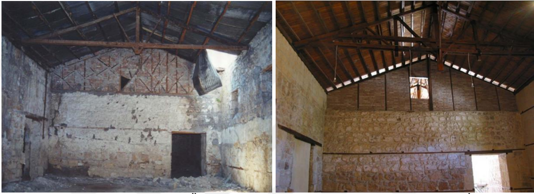
Şeki 54: Restorasyon Öncesi (Solda) ve Restorasyon Sonrası (Sağda) İç Mekan Durumu (Arkiv Gözlükule Kazısı Araştırma Merkezi 2022)
