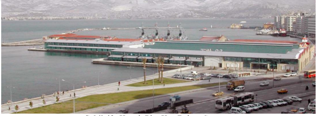
Şekil 42: Konak Pier Kuş Bakışı Görünüşü (Arkiv Konak Pier 2021)
