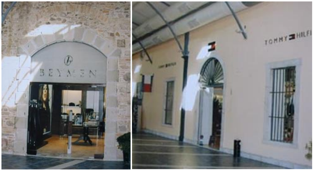
Şekil 39: Yapıda Restorasyon Sonrasında Açıklıklardaki Durum (MATU Mimarlık Arşivi 2022)
