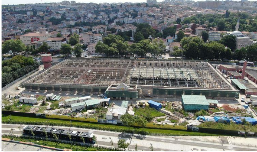
Şekil 61: Yapıdaki Çelik Kolonların Restorasyonu (Gürsoy Restorasyon 2022)
