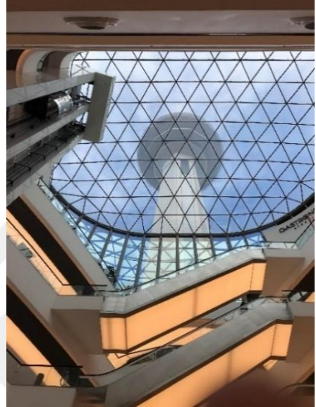
Şekil 5.74: Yeni Atakule AVM atrium üzeri cam tonoz örtü (Nalçacıoğlu, 2022)
