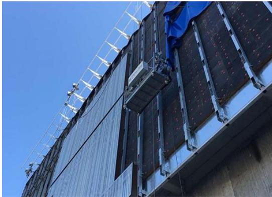
Şekil 5.52: Kompozit giydirme cephenin uygulanması (URL-68)
