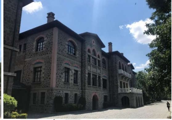
Şekil 2.30: İkinci TBMM Binası Batı Yönü (Nalçacıoğlu, 2022)
