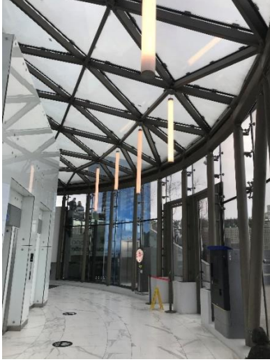
Şekil 5.42: Çatı terası holü (Nalçacıoğlu, 2022)
