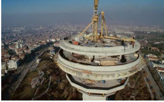
Şekil 5.21: Atakule döner platformlu kule tacı inşaatı (Baykara, 1987)
