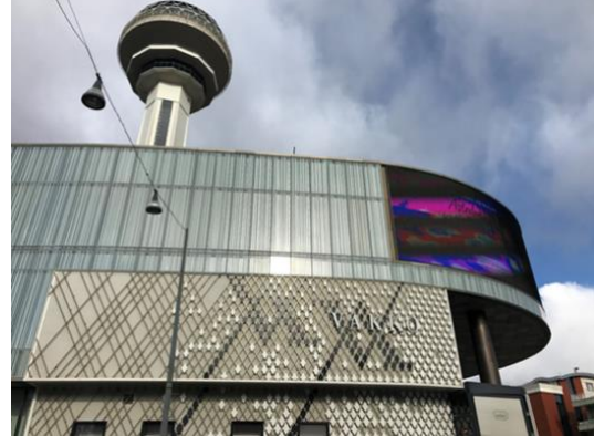
Şekil 5.53: Kompozit giydirme cephe (Nalçacıoğlu, 2022)
