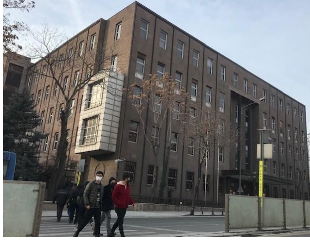
Şekil 2.31: Merkez Bankası, Clemens Holzmeister, Ankara 1933 (Nalçacıoğlu, 2022)
