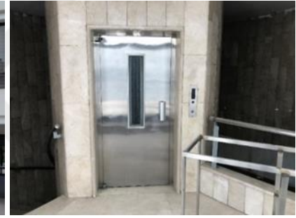
Şekil 5.121: Merdiven ve asansör kulesi içi (Nalçacıoğlu, 2022)
