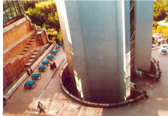
Şekil 5.20: Kule gövdesi ve açık teras alanı (Gür, 1990)
