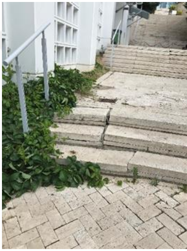
Şekil 5.124: Güney yönü yaya yolunda bitkilenme ve deformasyonlar (Nalçacıoğlu, 2022)
