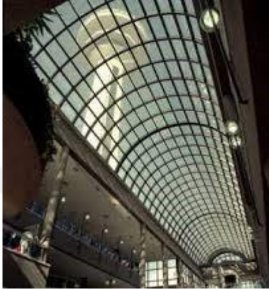
Şekil 5.73: İlk Atakule AVM atrium üzeri cam tonoz örtü (URL-72)
