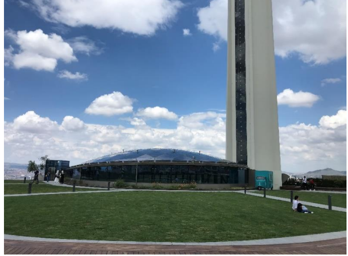
Şekil 5.43: Gezilebilir yeşil çatı (Nalçacıoğlu, 2022)
