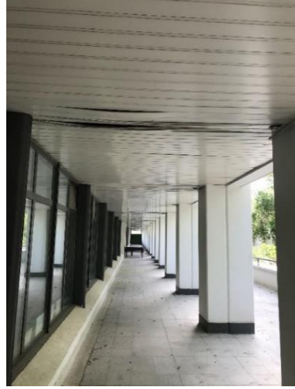
Şekil 5.127: Arkadlı geçiş asma tavanda bozulmalar (Nalçacıoğlu, 2022)
