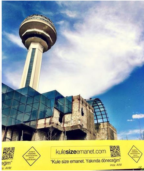
Şekil 5.56: Atakule AVM'nin yıkım sürecinde kullanılan şantiye panelleri (URL-70)
