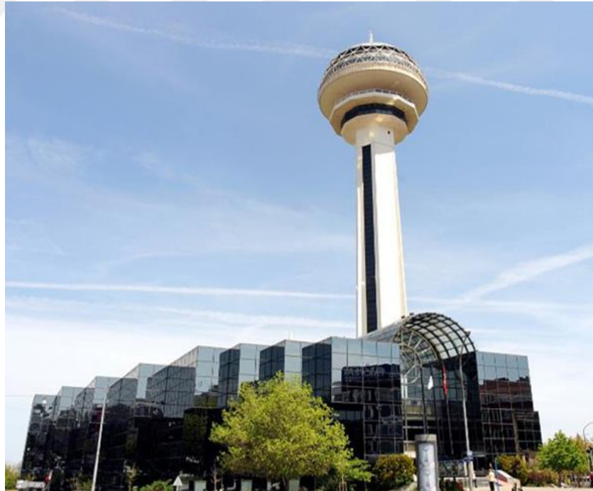
Şekil 5.9: İlk Atakule Alışveriş Merkezi yapısı giriş cephesi (URL-62)
