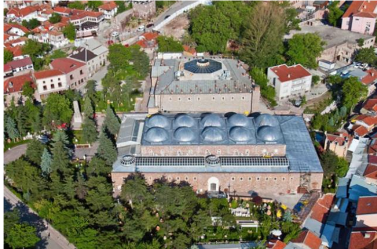
Şekil 3.5: Mahmutpaşa Bedesteni (önde) ve Kurşunlu Han (arkada) (Ankara İl Kültür Turizm Müdürlüğü, 2020)
