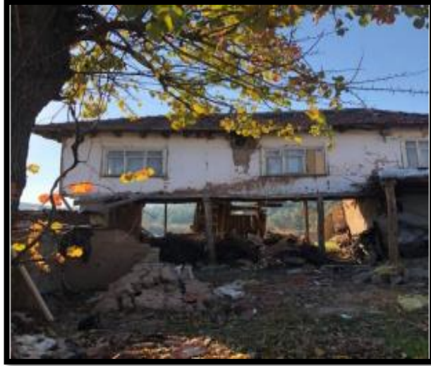
Şekil 2.26: Tongurlar Köyü Kerpiç Ev (Sarıkaya ve Arpacıoğlu 2019:25)
