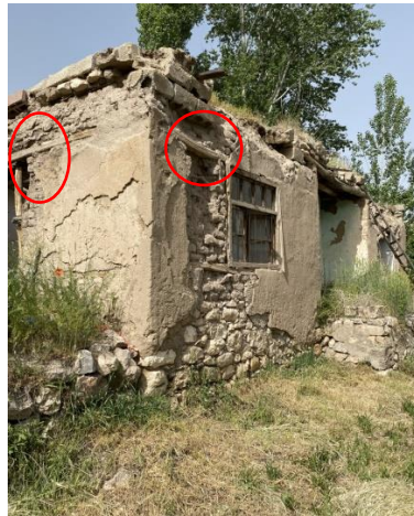
Şekil 4.4: Bozulmanın Etkisiyle Ortaya Çıkan Ahşap Hatıllar (1 ve 9 Numaralı Yapılar) (Kişisel Arşiv, 2022)
