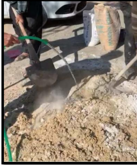
Şekil 2.5: Kerpiç Harcının Hazırlanması (Öztürk 2013:106)
