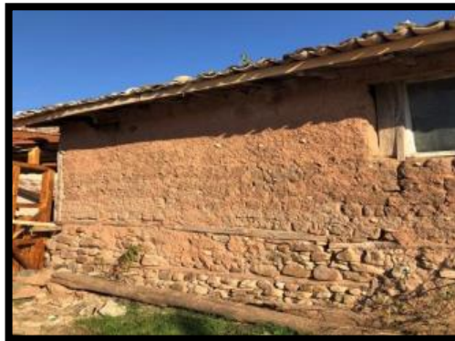
Şekil 2.24: Taş Temel Üzeri Kerpiç Ev (Sarıkaya ve Arpacıoğlu 2019:25)
