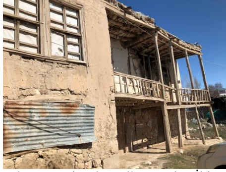
Şekil 4.3: Ahşap Strüktürlü Balkonlu Olan İki Katlı Kerpiç Yapılar (8 ve 9 Numaralı Yapılar) (Kişisel Arşiv, 2022)
