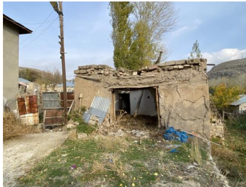
Şekil 4.11: 1 Numaralı Yapının Batı Cephesinde Bulunan Kapı Boşluğu (Kişisel Arşiv, 2022)
