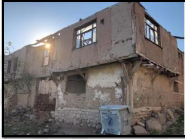
Şekil 2.25: Tongurlar Köyü Kerpiç Ev (Sarıkaya ve Arpacıoğlu 2019:25)
