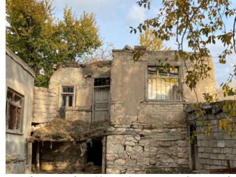
Şekil 4.3: Ahşap Strüktürlü Balkonlu Olan İki Katlı Kerpiç Yapılar (8 ve 9 Numaralı Yapılar) (Kişisel Arşiv, 2022)
