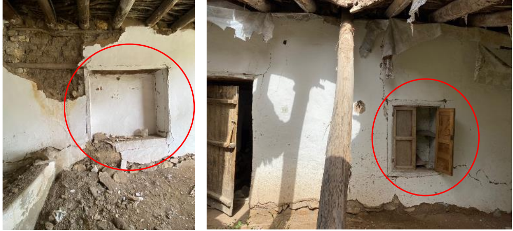
Şekil 4.10: 1 Numaralı Yapı İçerisindeki Yüklük Ve Dolap Nişi (Kişisel Arşiv, 2022)
