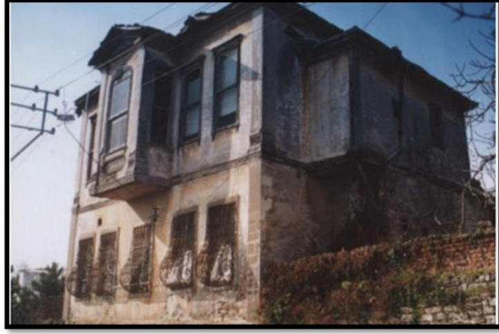
Şekil 2.14: Bağdadi Tekniğiyle Yapılmış Bir Ev (Aktaş 2020:35)
