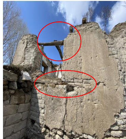
Şekil 4.4: Bozulmanın Etkisiyle Ortaya Çıkan Ahşap Hatıllar (1 ve 9 Numaralı Yapılar) (Kişisel Arşiv, 2022)
