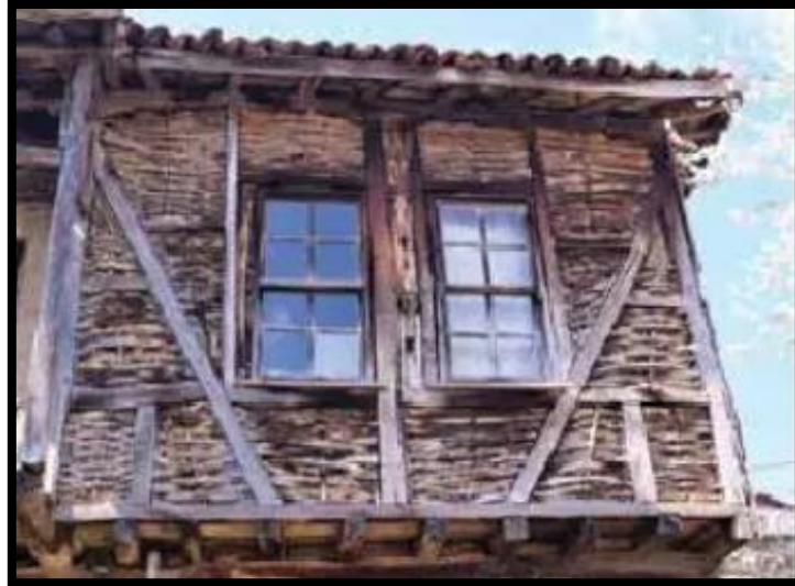
Şekil 2.15: Sepet Örgü Sistemi (Göçer ve Eraslan 2020: 121)
