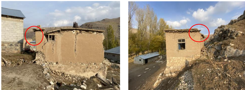
Şekil 4.7: Yağmur Oluklarının (Şoratan) Görüldüğü Yapılar (Kişisel Arşiv, 2022)
