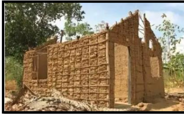
Şekil 2.8: Omurgalı Kerpiç Tekniğiyle Yapılmış Bir Yapı (Fındık 2017:18)
