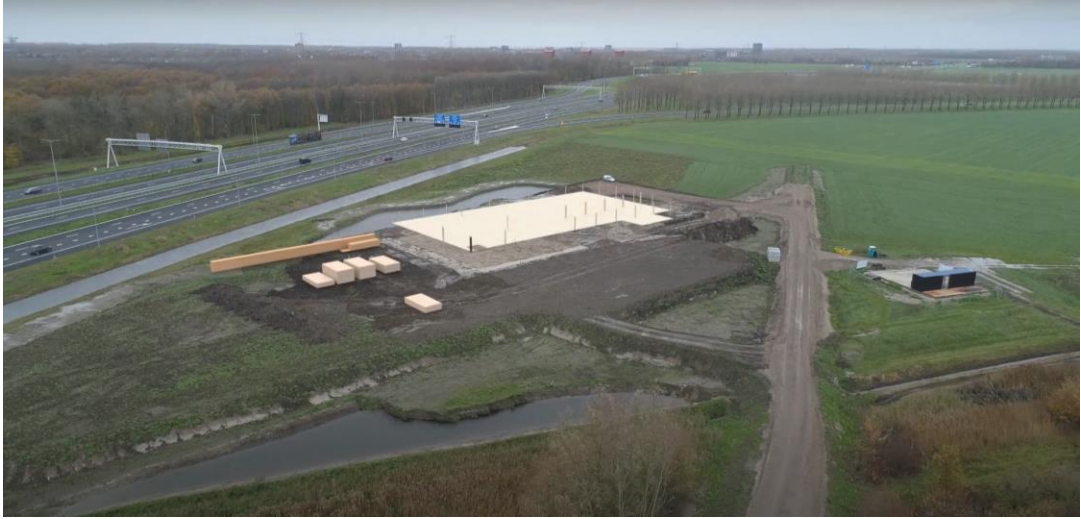
Şekil 3.4: Şantiye İmalat Hazırlık Aşaması (LIDL Supermarket 2021)
