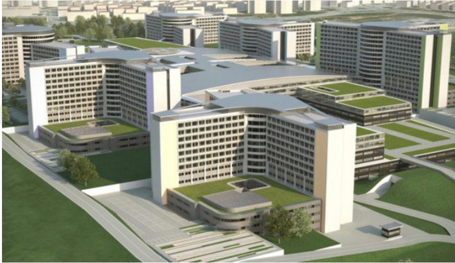
Resim 17: Ankara Etlik Şehir Hastanesi Hastanesinden Bir Görünüm (İnşaatı henüz Tamamlanmamış)
