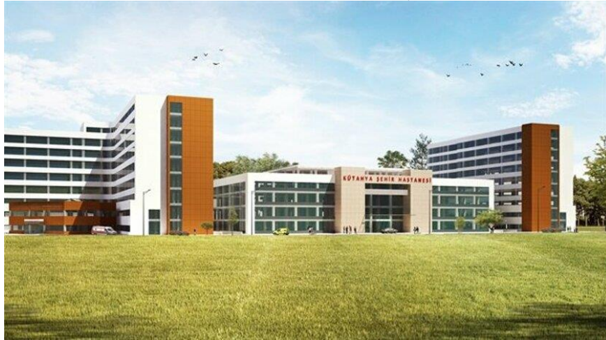
Resim 16: Kütahya Şehir Hastanesi Hastanesinden Bir Görünüm (İnşaatı Henüz Tamamlanmamış)
