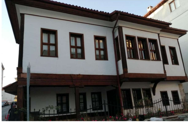
Şekil 2.99: Kolağası Konağı Güney Cephe
