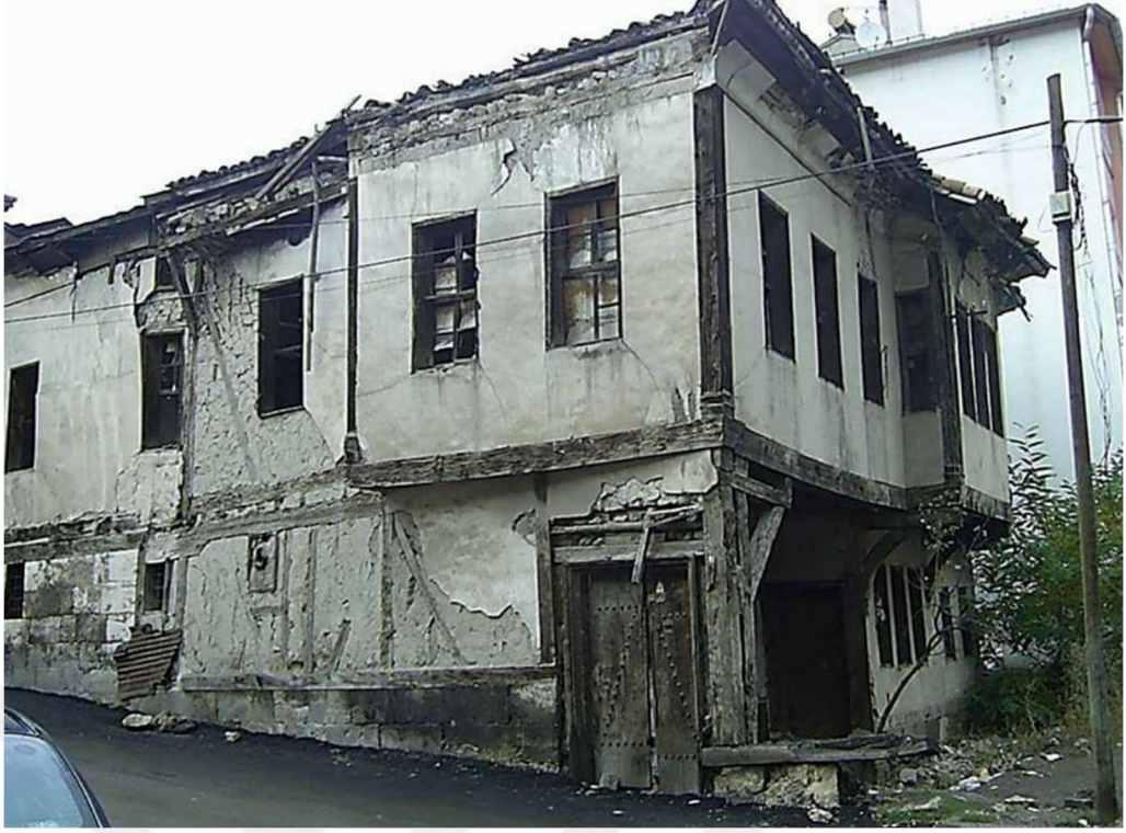
Şekil 2.115: Kolağası Konağı Eski Hali((Sivas Koruma Kurulu)
