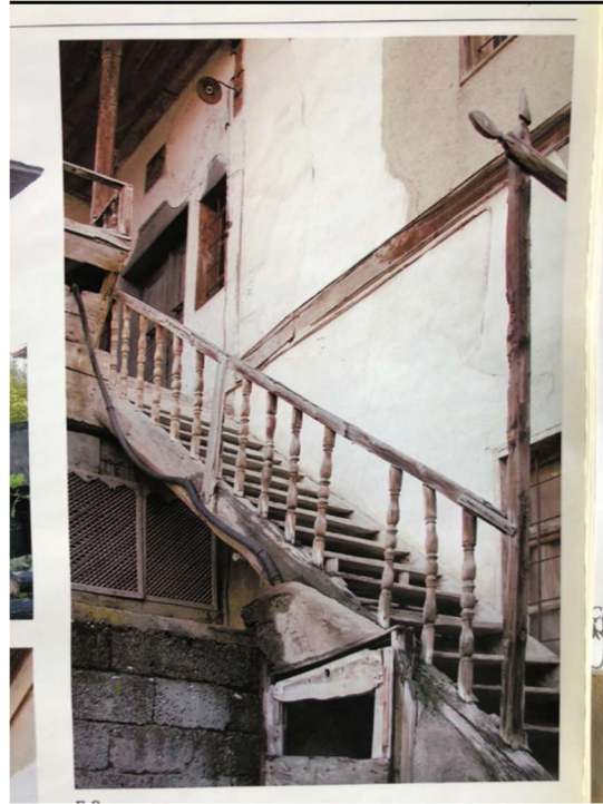
Şekil 2.60: Mühürzade Konağı Merdiven (Sivas Koruma Kurulu)
