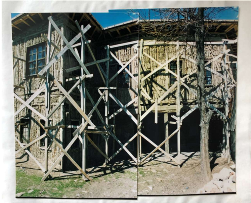
Şekil 2.56: Mühürzade Konağı Zemin kat değişimi (Sivas Koruma Kurulu)
