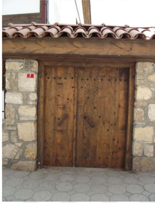
Şekil 2.66: Terzioğlu Konağı Giriş Kapısı
