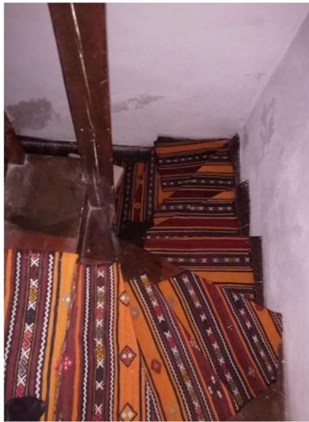
Şekil 2.103: Kolağası Konağı Zemin kata inilen kapı
