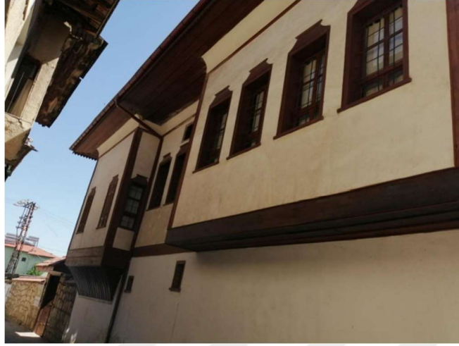
Şekil 2.29: Mühürzade Konağı Kuzey Cephesi
