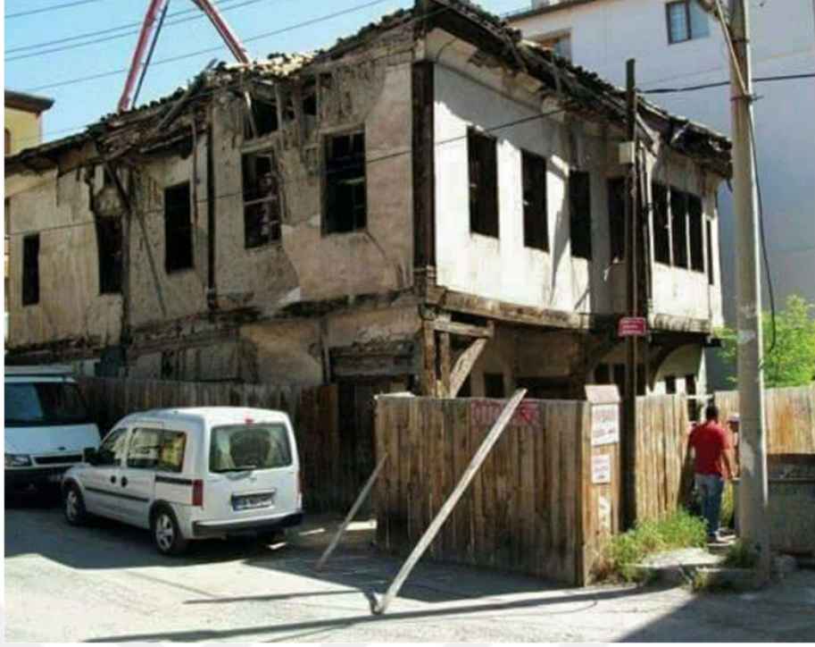
Şekil 2.117: Kolağası Konağı Eski Hali (Sivas Koruma Kurulu)
