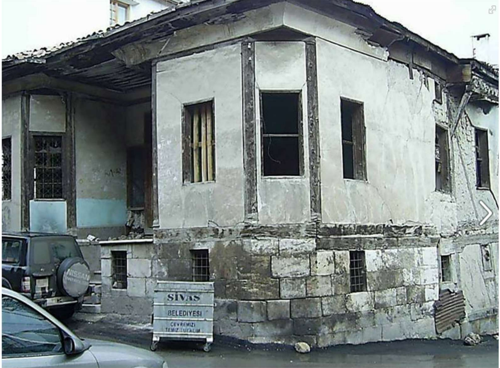
Şekil 2.116: Kolağası Konağı Eski Hali(Sivas Koruma Kurulu)
