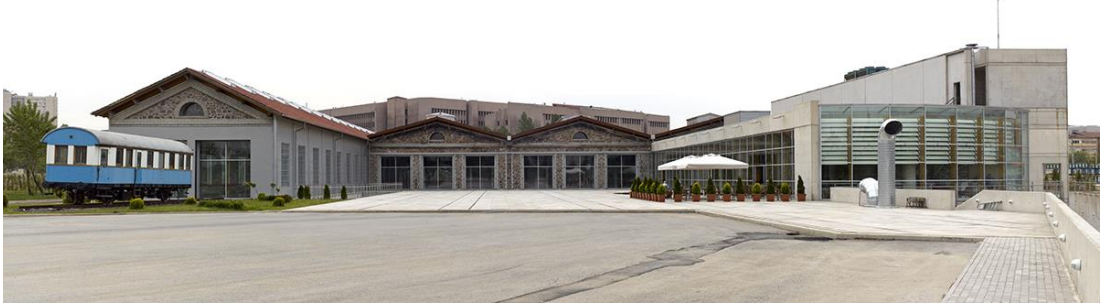
Şekil 138: CerModern Görünüş [URL 18]
