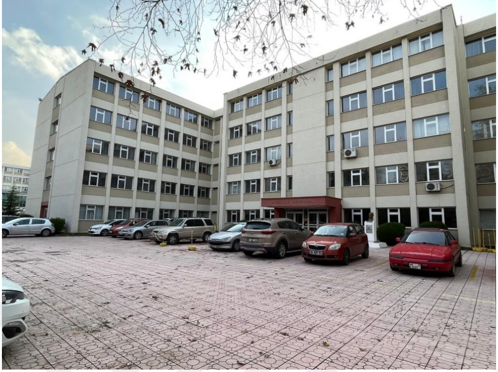
Şekil 34: Mevcut Yapının Cephesi
