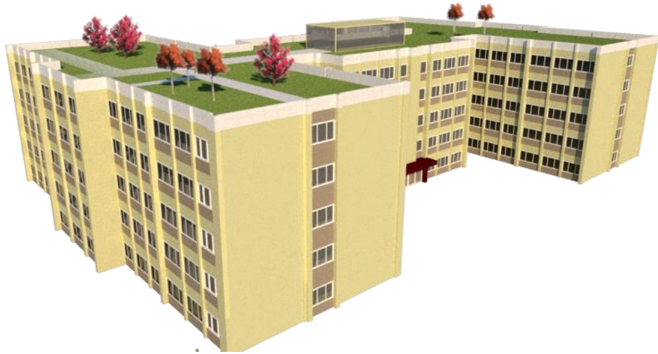
Şekil 46: Okul Yapısı Yeşil Çatı Uygulaması
