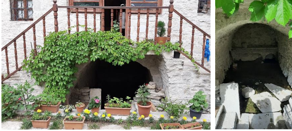
Şekil 18: Muhsin Bey Konağının bahçesinde bulunan sarnıç (Kahyaoğlu 2021).
