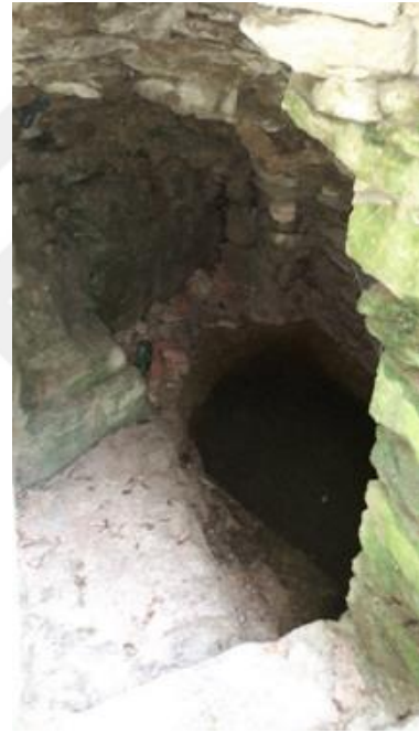
Şekil 20: Nimet Hanım Konağının bahçesinde bulunan sarnıç (Kahyaoğlu 2021).
