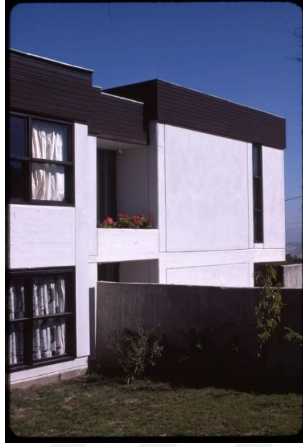
Şekil 4. 9: Esat Sivri Evi, Giriş ile Salon Cephesi Arasındaki Görsel İlişkiyi Kesen Duvar ve Sokak Cephesi (Bektaş 1975a) [URL-5]
