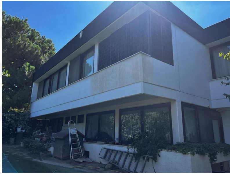
Şekil 4. 32: Esat Sivri Evi, Dış Cephe Kafes Uygulaması (Akmil Kahraman 2022)
