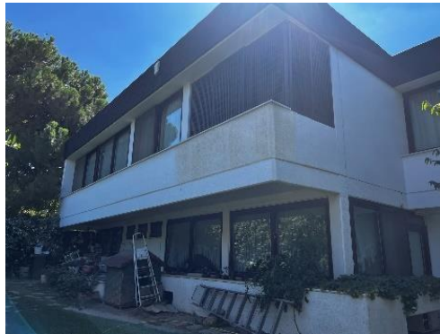
Şekil 4. 21: Esat Sivri Evi, Birinci Kat, Balkonun Dış Cephesine Uygulanan Ahşap Kafes Uygulaması (Akmil Kahraman 2022)
