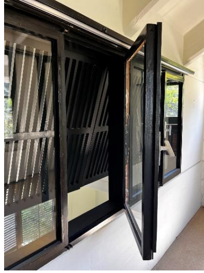
Şekil 4. 61: İsmailgil Evi, Birinci Kat, Odaların Zemin Kat Oturma Alanına Bakan İç Pencerelelerinde Ahşap Kafes Uygulaması (Akmil Kahraman 2022)
