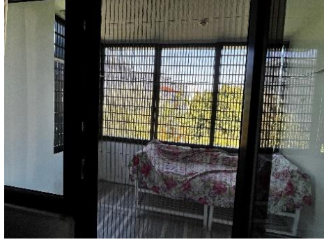
Şekil 4. 19: Esat Sivri Evi, Birinci Kat Ebeveyn Banyosu Çamaşır Balkonu, Balkonun Dış Cephesine Uygulanan Ahşap Kafes Uygulaması (Akmil Kahraman 2022)
