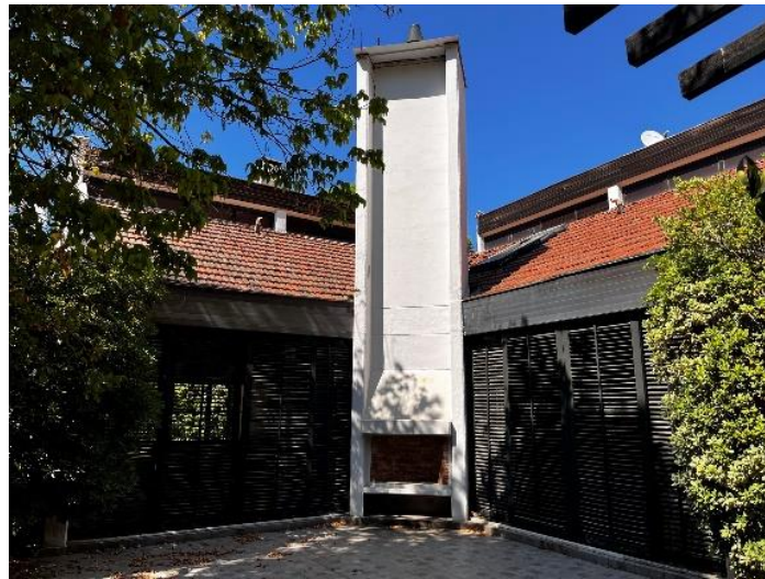
Şekil 4. 62: İsmailgil Evi, Avluya Bakan Ocak ve Zemin Kat Oturma Alanı Ahşap Kafesli Pencereleleri (Akmil Kahraman 2022)
