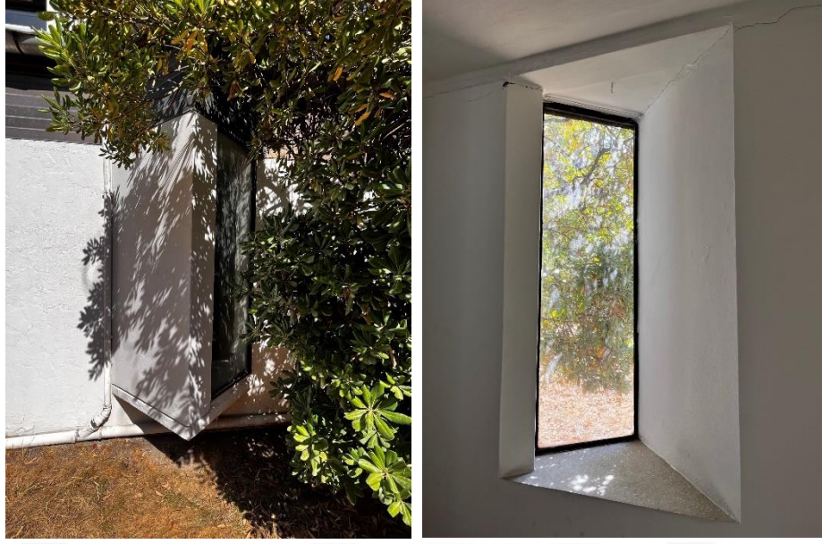
Şekil 4. 52: İsmailgil Evi, Zemin Kat Oturma Alanı, Güney Cephe Pencere Tasarımı İç ve Dış Mekân Görselleri (Akmil Kahraman 2022)
