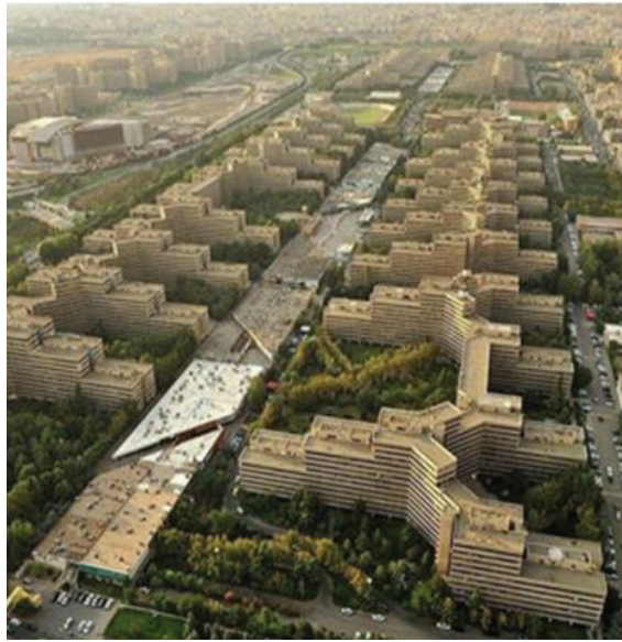
Foto. 4. Ekbatan Projesi Genel Görünüm
