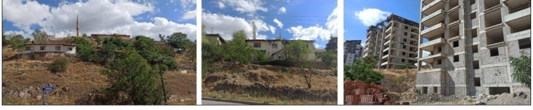
Şekil 15: Yıkılmış veya Harabelerden Oluşan Gecekondu ile İnşasına Devam Edilen Çok Katlı Yapılaşmalar
